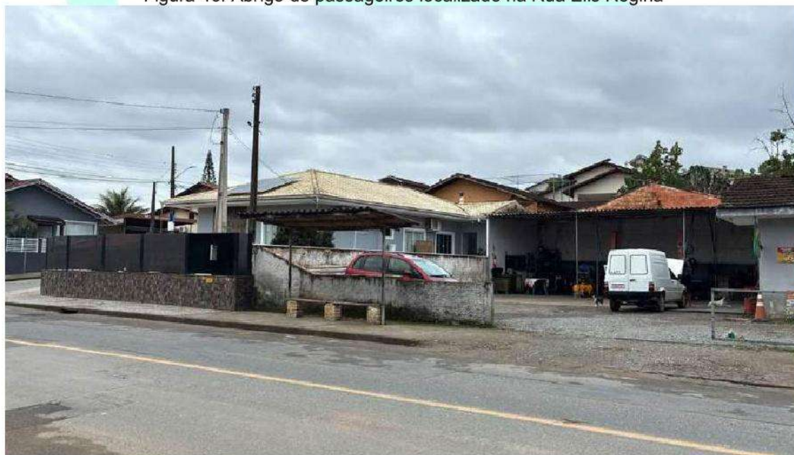
Figura 46: Abrigo de passageiros localizado na Rua Elis Regina
