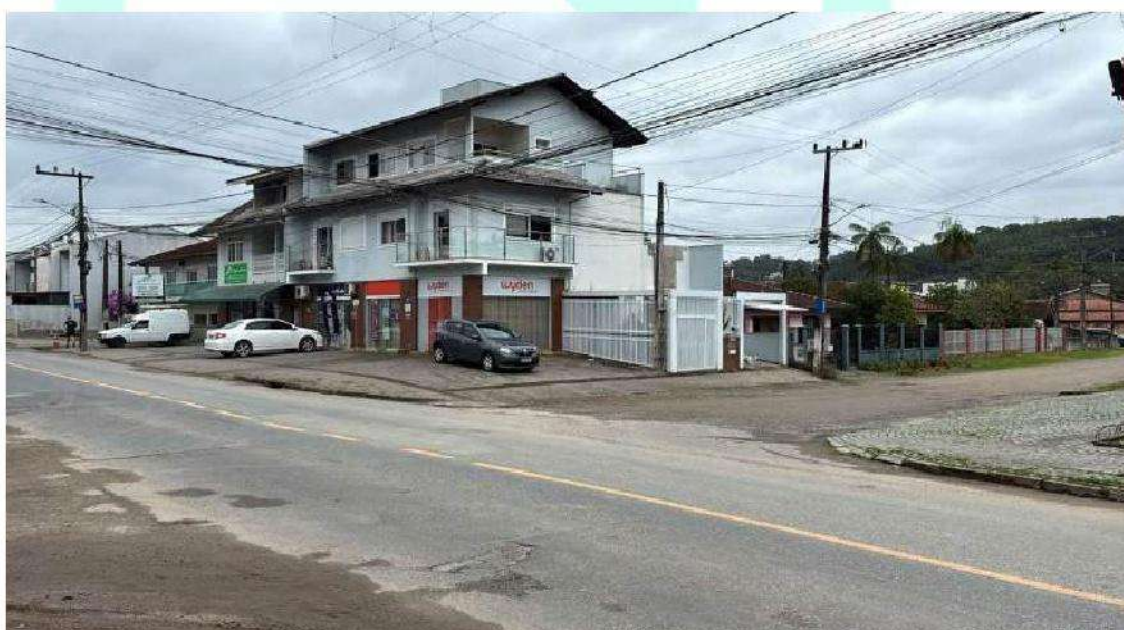
Figura 35: Condições atuais da interseção das ruas Pres. Samora Machel com a Rua Elis Regina.
