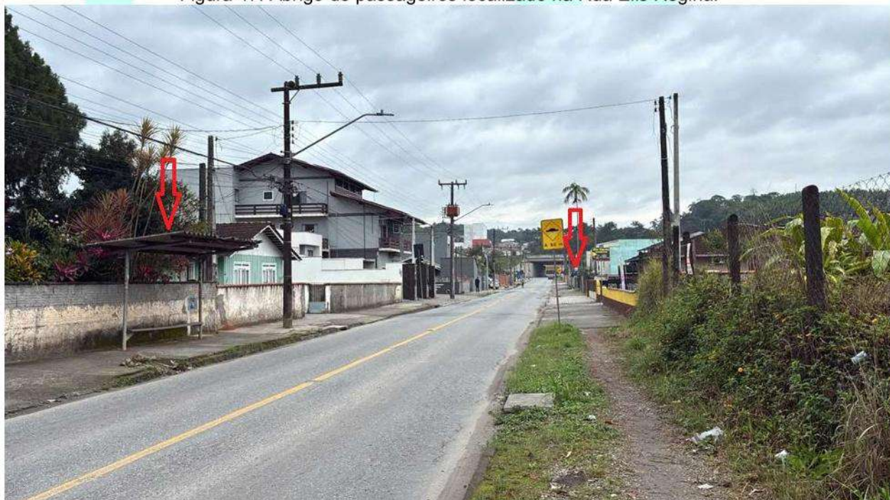
Figura 47: Abrigo de passageiros localizado na Rua Elis Regina.
