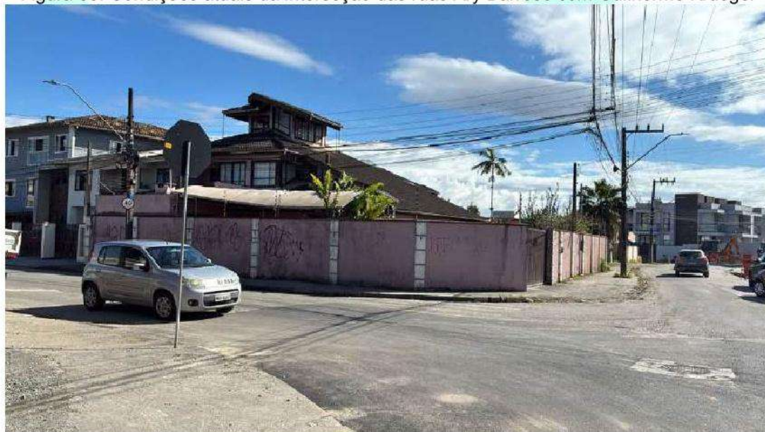
Figura 39: Condições atuais da interseção das ruas Ary Barroso com Guilherme Krueger
