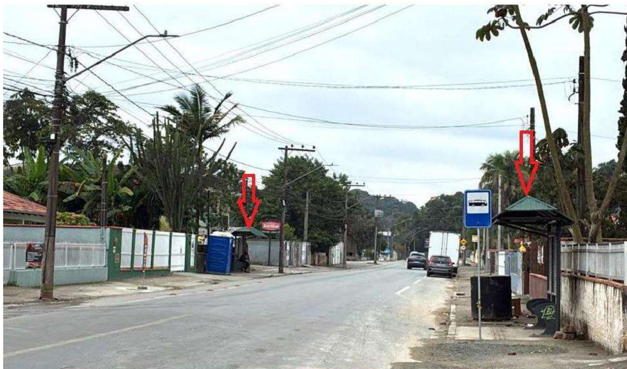
Figura 48: Abrigos de passageiros localizados na Rua Francisco Alves.
