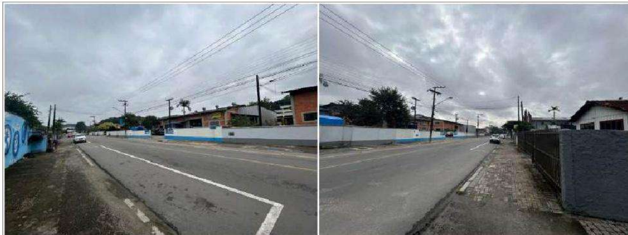
Figura 14: Imagens da pavimentação da Rua Francisco Alves em 30/04/2026.
