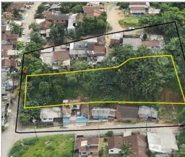
Defesa Civil de Joinville - PMSRD - Plano Municipal de Gestão de Riscos de Desastres
