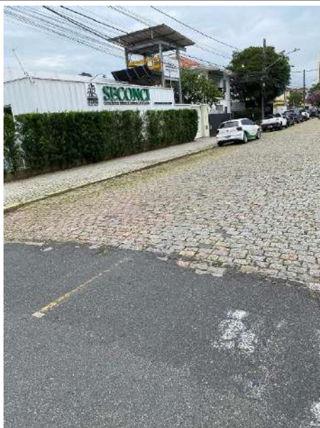
Pavimento da Rua Dr Plácido Gomes esquina com Rua São Paulo
