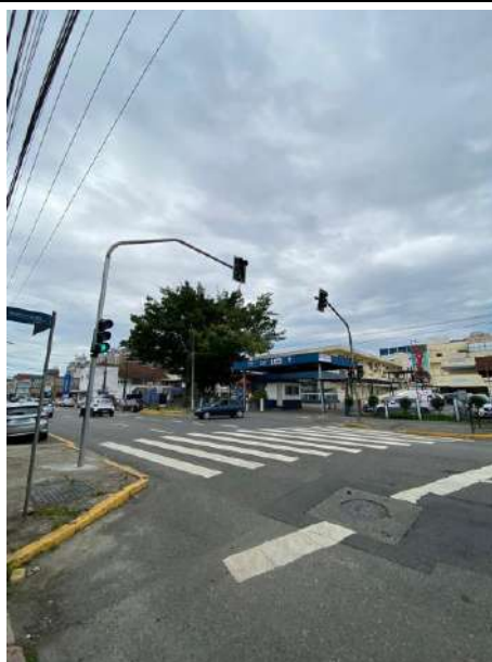
Sinalização vertical e horizontal na Av. Getúlio Vargas, em frente ao Hospital São José
