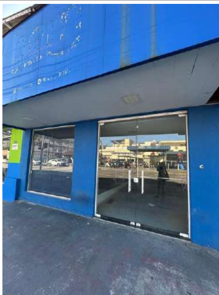
Imóvel desocupado na Av. Getúlio Vargas
