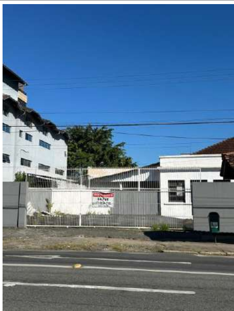
Imóvel desocupado na Av. Getúlio Vargas
