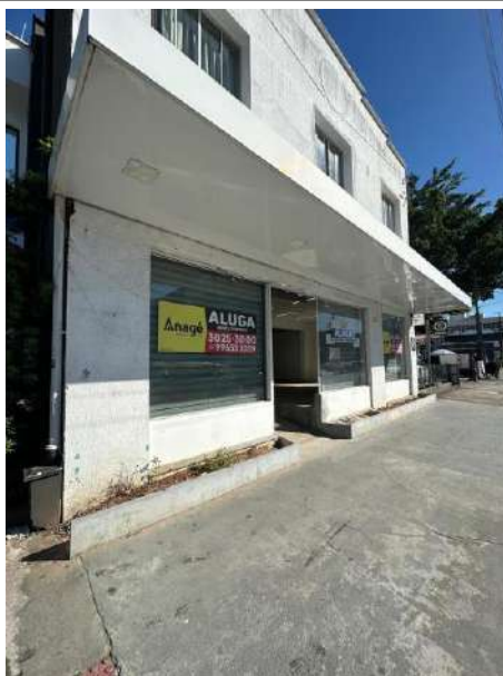
Imóvel desocupado na Av. Getúlio Vargas
