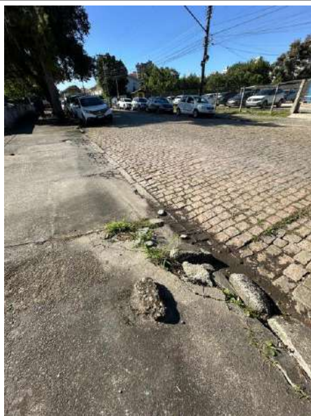
Calçada em frente ao empreendimento – R. Dr Plácido Gomes
