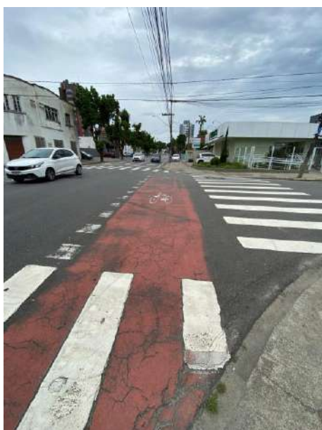
Sinalização horizontal na Rua São Paulo, esquina com Rua Plácido Gomes
