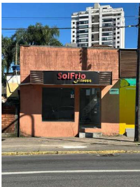
Imóvel desocupado na Av. Getúlio Vargas
