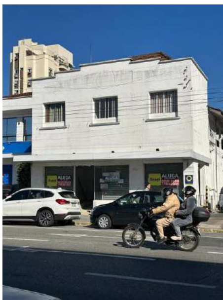
Imóvel desocupado na Av. Getúlio Vargas
