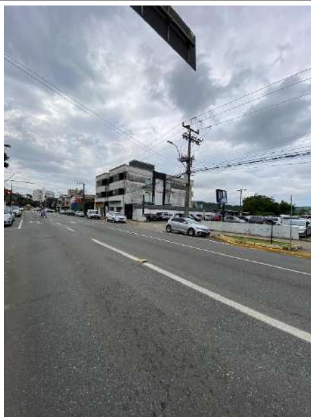
Pavimento na Av. Getúlio Vargas, na frente do empreendimento
