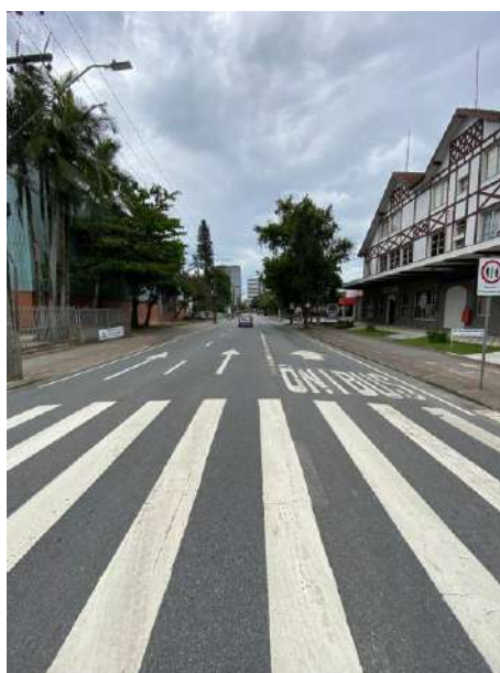
Sinalização horizontal e vertical na Rua São Paulo
