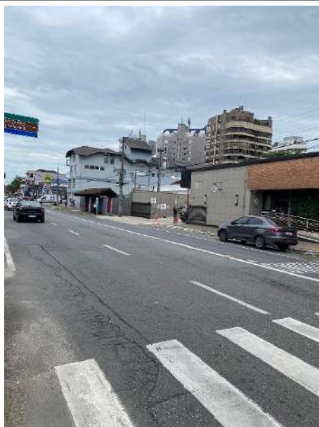
Pavimento na Av. Getúlio Vargas em frente ao empreendimento
