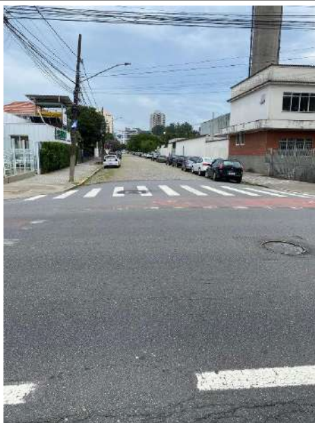
Pavimento da Rua São Paulo em frente com Dr Plácido Gomes
