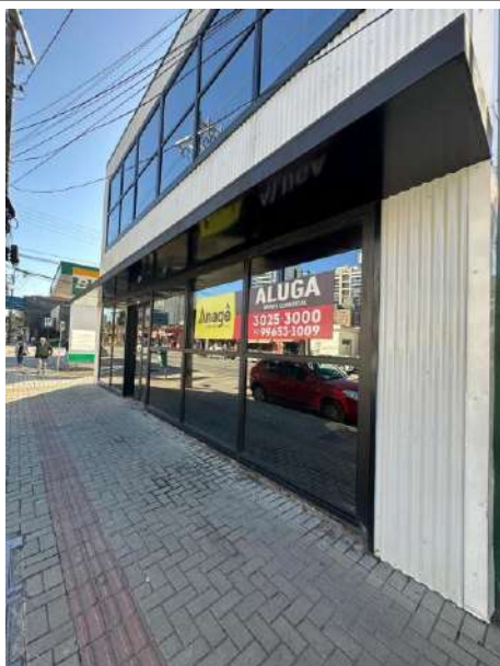
Imóvel desocupado na Av. Getúlio Vargas
