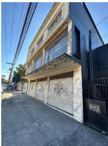
Imóvel desocupado na Av. Getúlio Vargas
