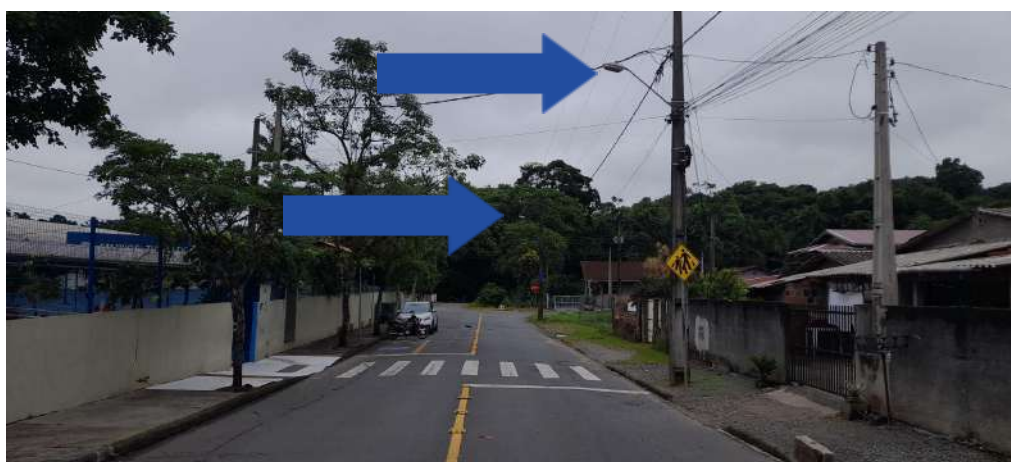
Imagem 17 - Iluminação Pública Rua das Cabeleiras
