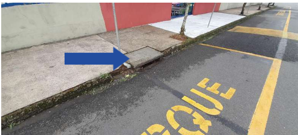
Imagem 14 - Área de captação de água pluvial Rua Willy Affonso Jacob
