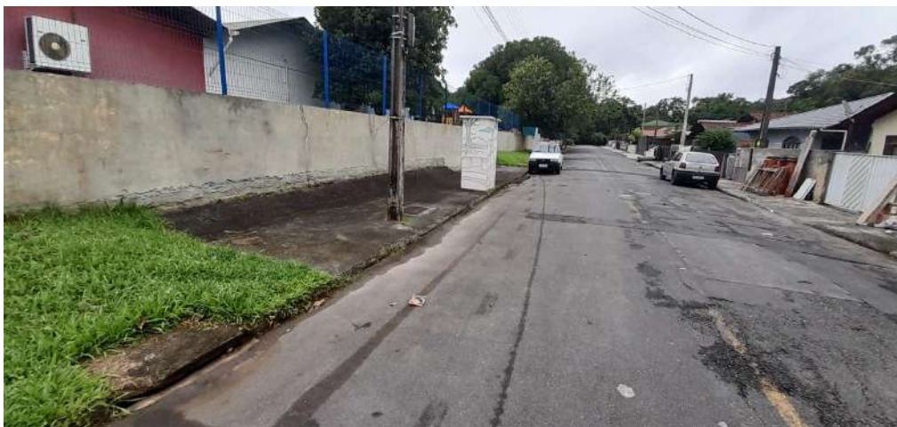
Imagem 12 - Pavimentação Testada Oeste
