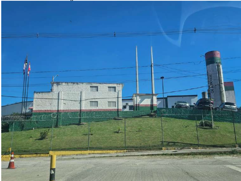
Figura 1. Vista Atual do Presídio Masculino.
