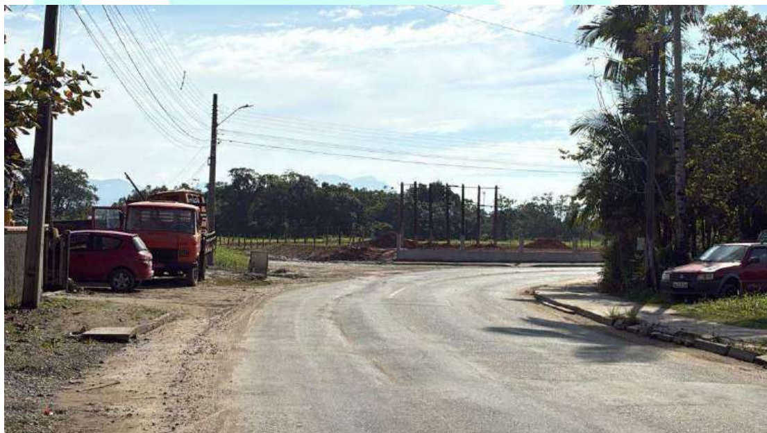
Figura 31: Condições atuais da Rua Lagoinha em frente ao empreendimento
