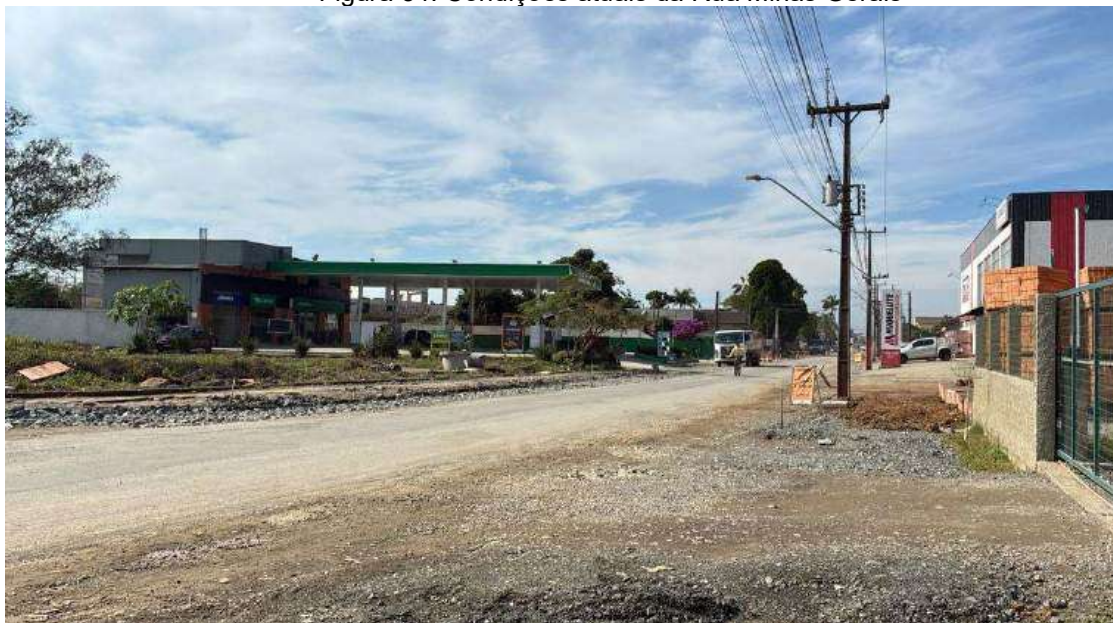
Figura 34: Condições atuais da Rua Minas Gerais
