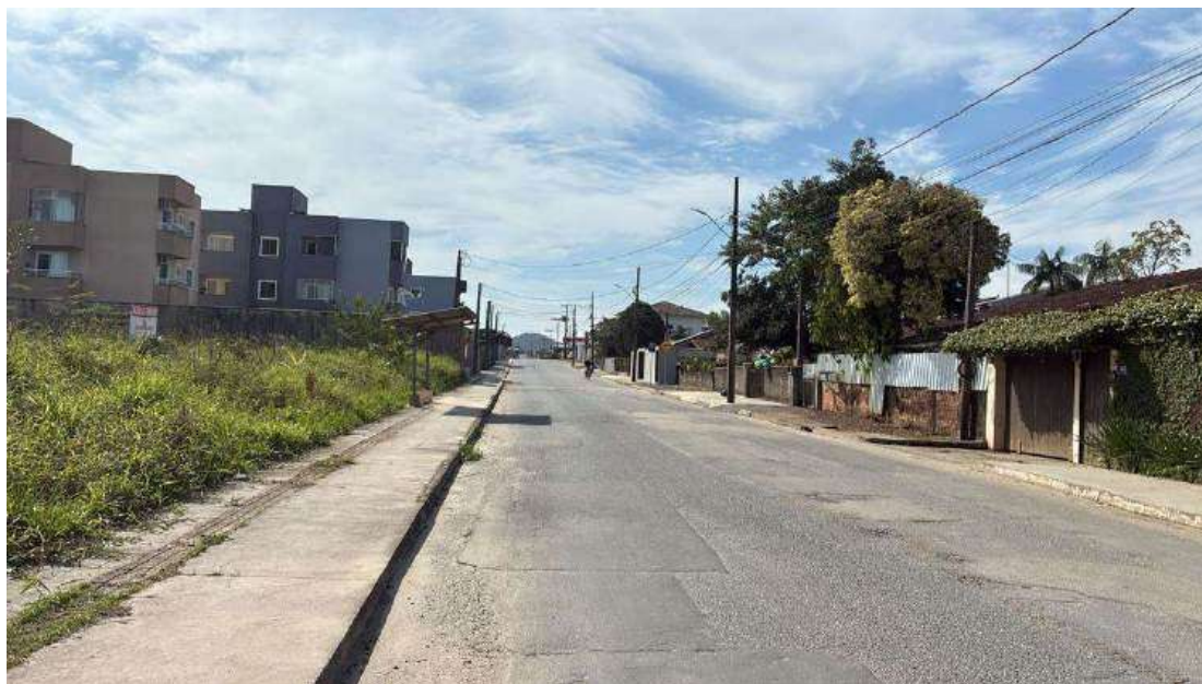
Figura 32: Condições atuais da Rua Lagoinha em frente ao empreendimento
