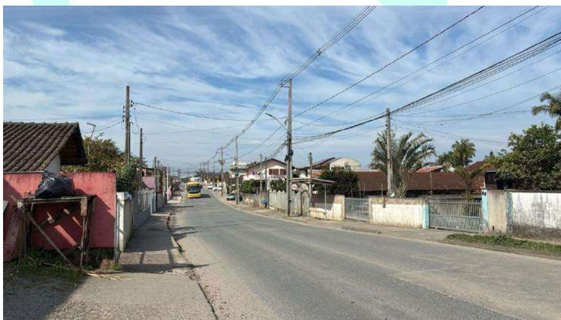
Figura 35: Condições atuais da Rua Antônio Alves
