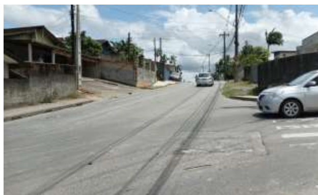
Figura 203 – Rua Rio Velho – ETE Atrás (Ponto 21C)
