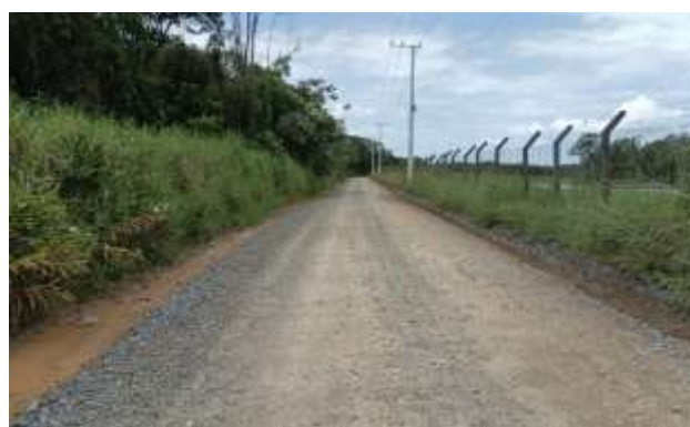
Figura 235 – Rua Rio Velho – ETE à esquerda (Ponto 29B)
