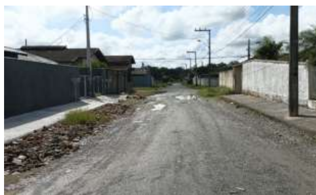
Figura 119 – Rua Cidade de Guarulhos – ETE Frente (Ponto 1B)
