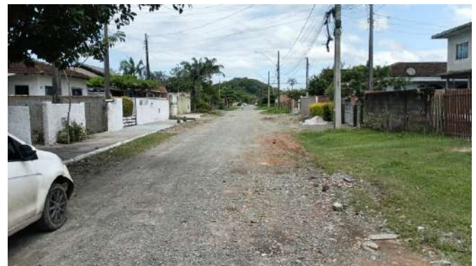
Figura 101 – Rua Hildebrando Soares – ETE Atrás (Ponto 24B)
