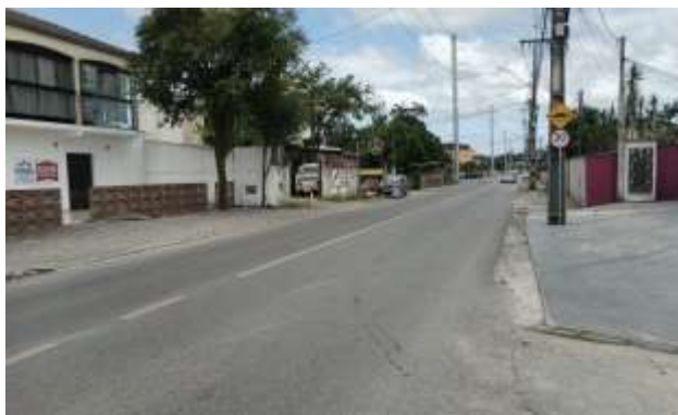
Figura 210 – Rua Atila Urban – ETE Atrás (Ponto 23A)
