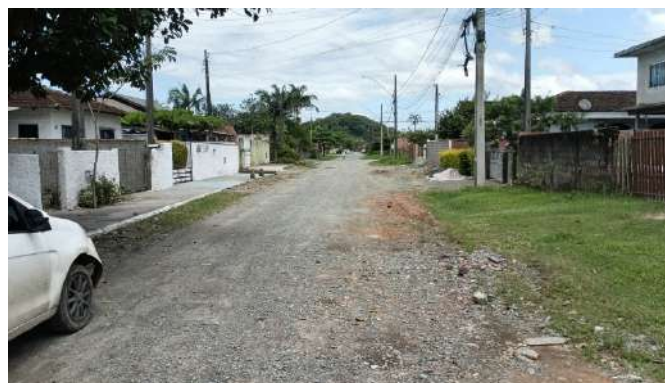
Figura 101 – Rua Hildebrando Soares – ETE Atrás (Ponto 24B)
