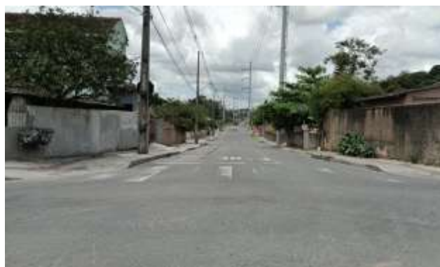
Figura 178 – Rua Eurides Francisco Tomasoni – ETE à esquerda (Ponto 15A)
