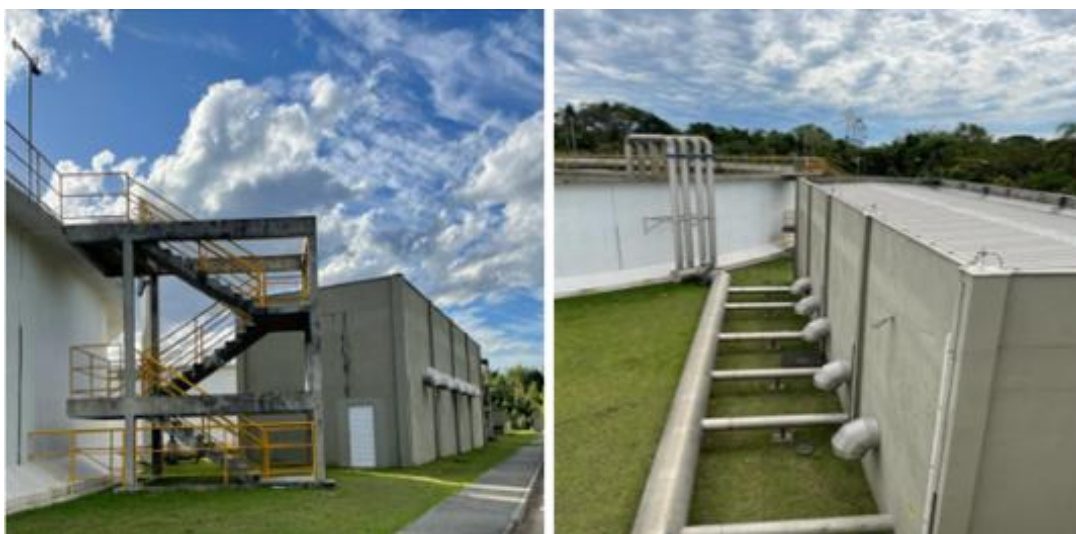
Figura 15 – À esquerda, vista externa da edificação de Sopradores dos reatores B e D. À direita, tubulação de inox que encaminha o ar para o reator D.
