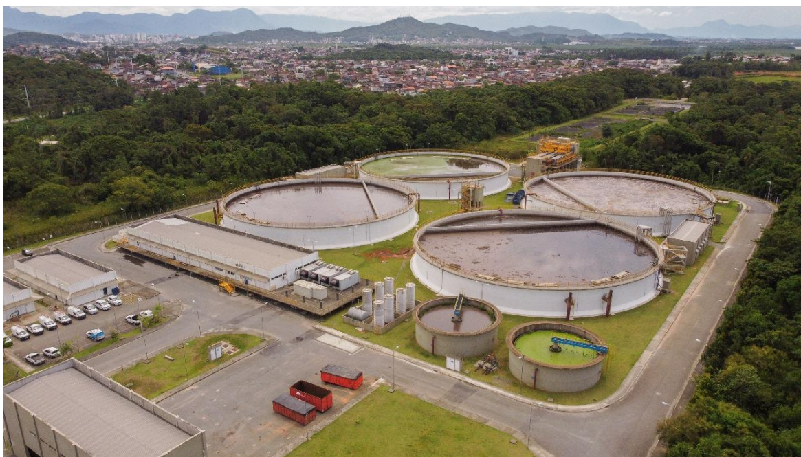
Figura 3 – Vista aérea da ETE Jarivatuba em operação
