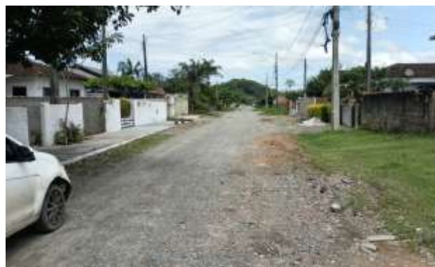
Figura 216 – Rua Hildebrando Soares – ETE Atrás (Ponto 24B)
