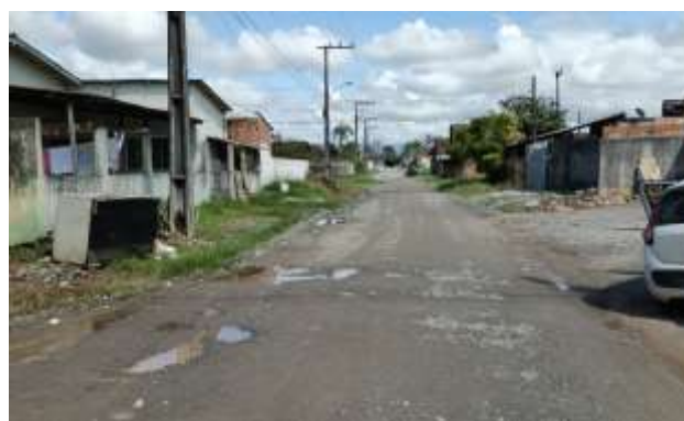
Figura 136 – Rua Cidade de Guarulhos – ETE Atrás (Ponto 5B)
