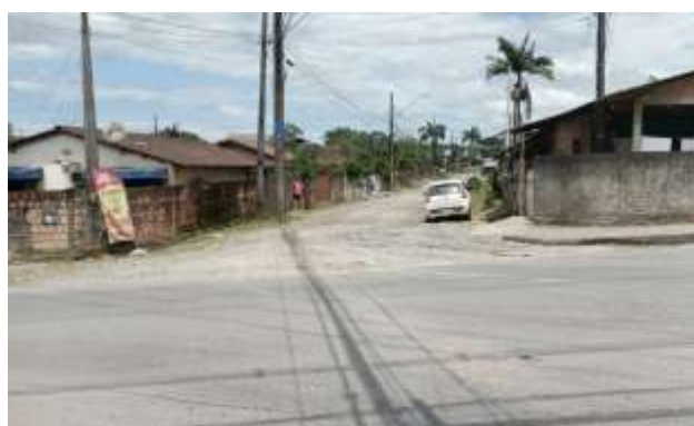
Figura 201 – Servidão Alvin Martinho Armando – ETE à esquerda (Ponto 21A)
