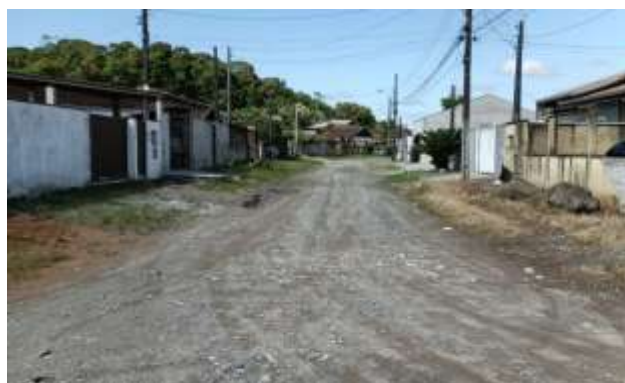
Figura 137 – Rua Dep. Aderbal Tavares Lopes – ETE à esquerda (Ponto 5C)
