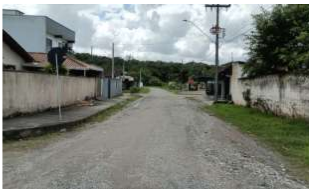
Figura 169 – Rua José Clara de Oliveira – ETE à Frente (Ponto 13A)
