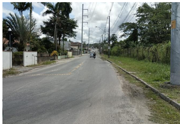
Figura 53 – Rua Rio Velho (ETE Jarivatuba à direita)
