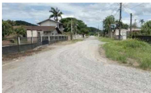
Figura 221 – Rua Hildebrando Soares – ETE Atrás (Ponto 25B)
