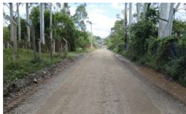
Figura 229 – Rua Rio Velho – ETE à direita (Ponto 27B)
