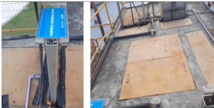
Figura 10 – Comportas da Torre de Distribuição. Detalhes da comporta motorizada e das tubulações rosa (NaOH) e laranja (FeCl 3 ) chegando
