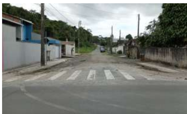
Figura 188 – Rua Alfredo Stringari – ETE Atrás (Ponto 17C)
