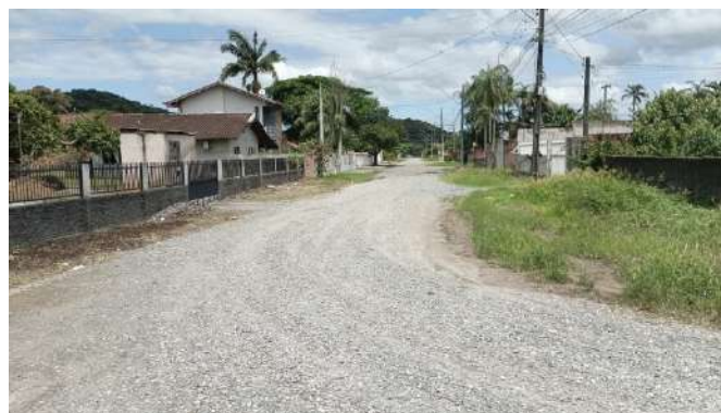
Figura 106 – Rua Hildebrando Soares – ETE Atrás (Ponto 25B)
