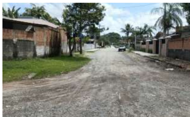
Figura 218 – Rua Golda Meir – ETE à direita (Ponto 24D)
