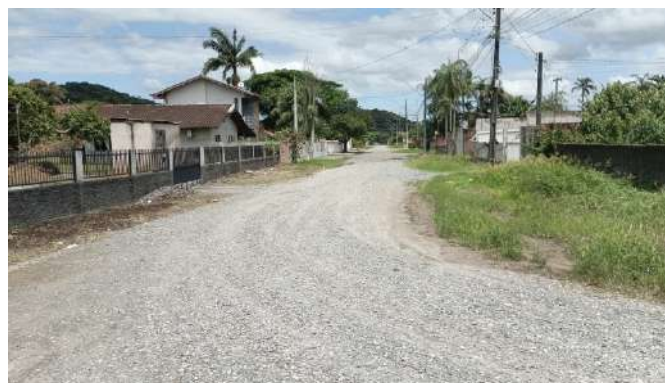
Figura 106 – Rua Hildebrando Soares – ETE Atrás (Ponto 25B)
