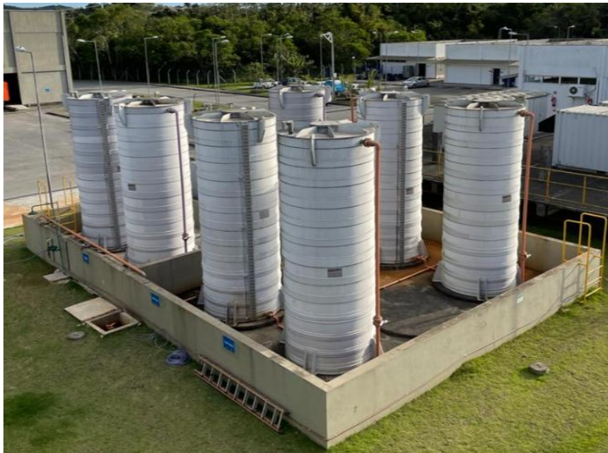
Figura 30 – Tanques de armazenamento de produtos químicos em estrutura de contenção ao lado dos adensadores.
