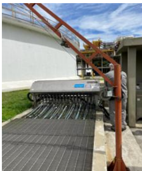
Figura 21 – Canal de desinfecção por UV, com detalhe da disposição da estrutura de suporte das lâmpadas.
