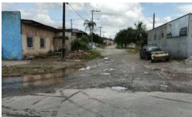
Figura 159 – Rua Cidade de Ourinho – ETE Atrás (Ponto 11A)
