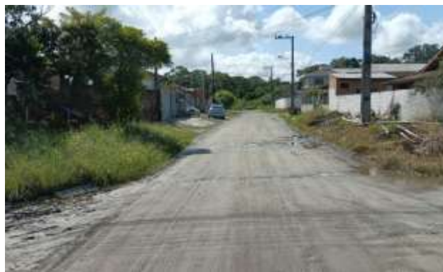
Figura 130 – Rua Cidade de Guarulhos – ETE à Frente (Ponto 4A)
