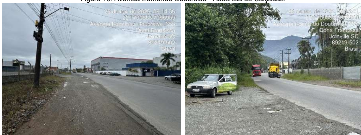
Figura 19. Avenida Edmundo Doubrawa - Ausência de Calçadas.
