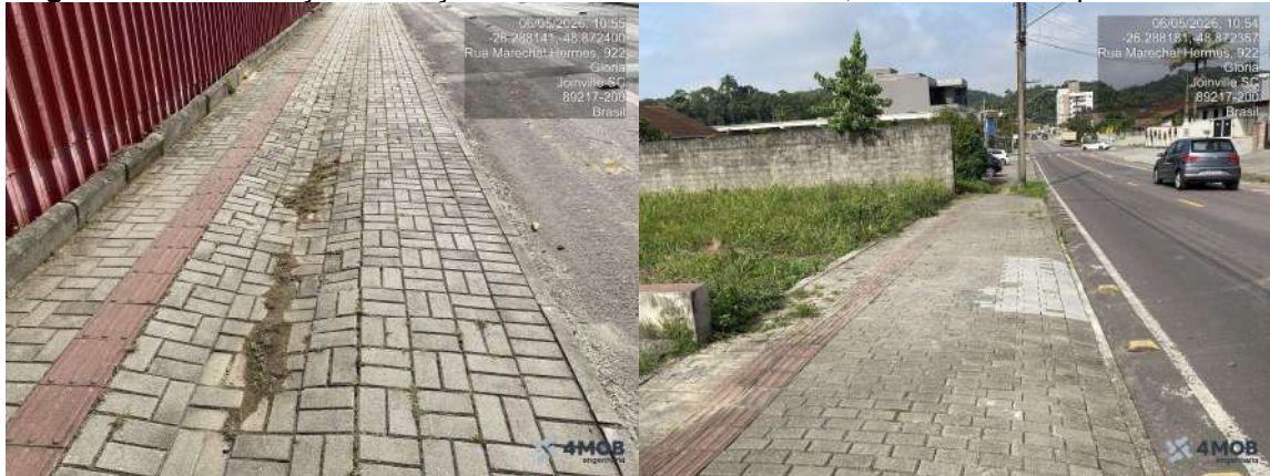
Figura 9 - Pavimentação da calçada da Rua Marechal Hermes, em frente ao empreendimento
