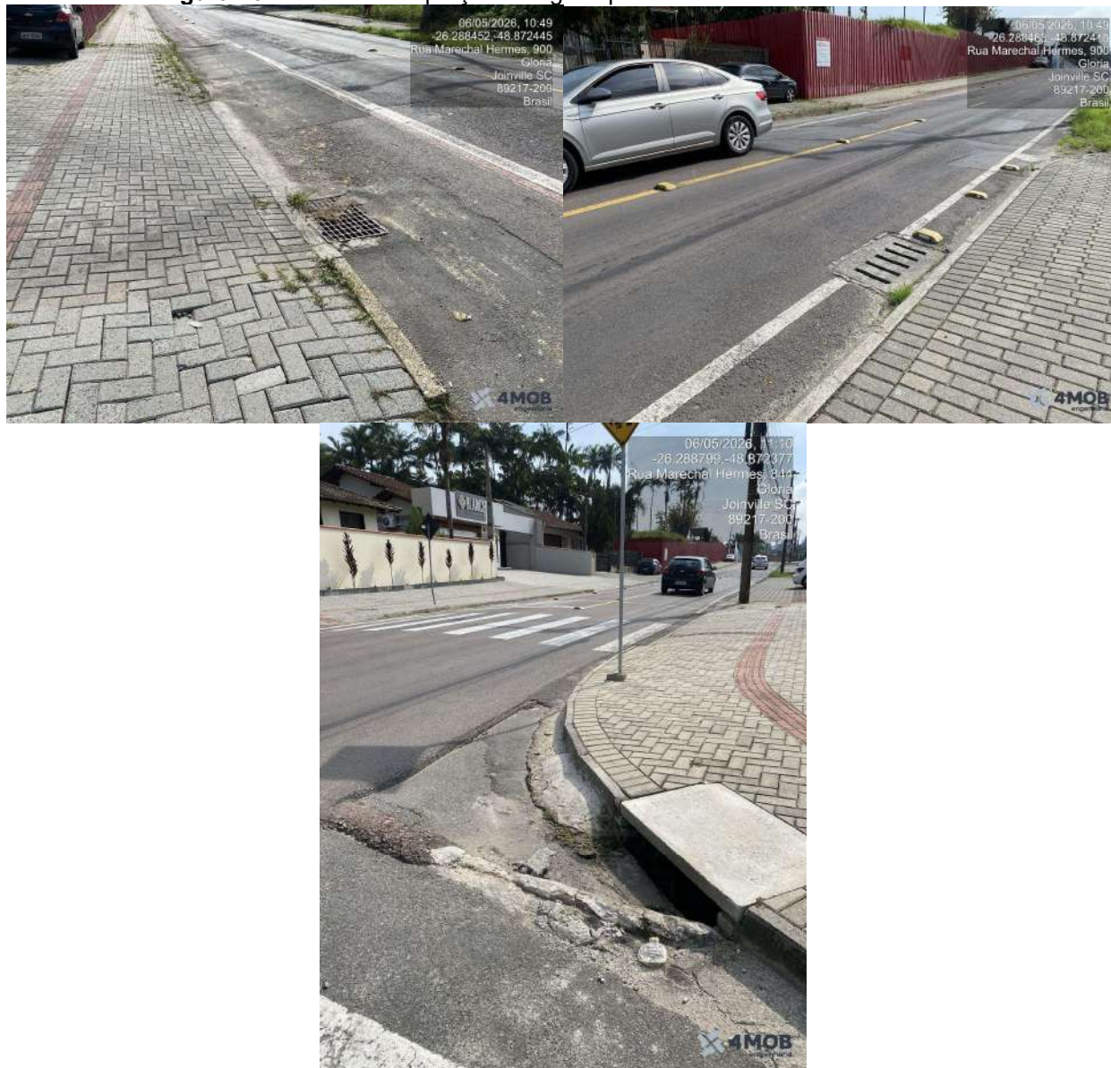
Figura 10 - Pontos de captação de águas pluviais na Rua Marechal Hermes
