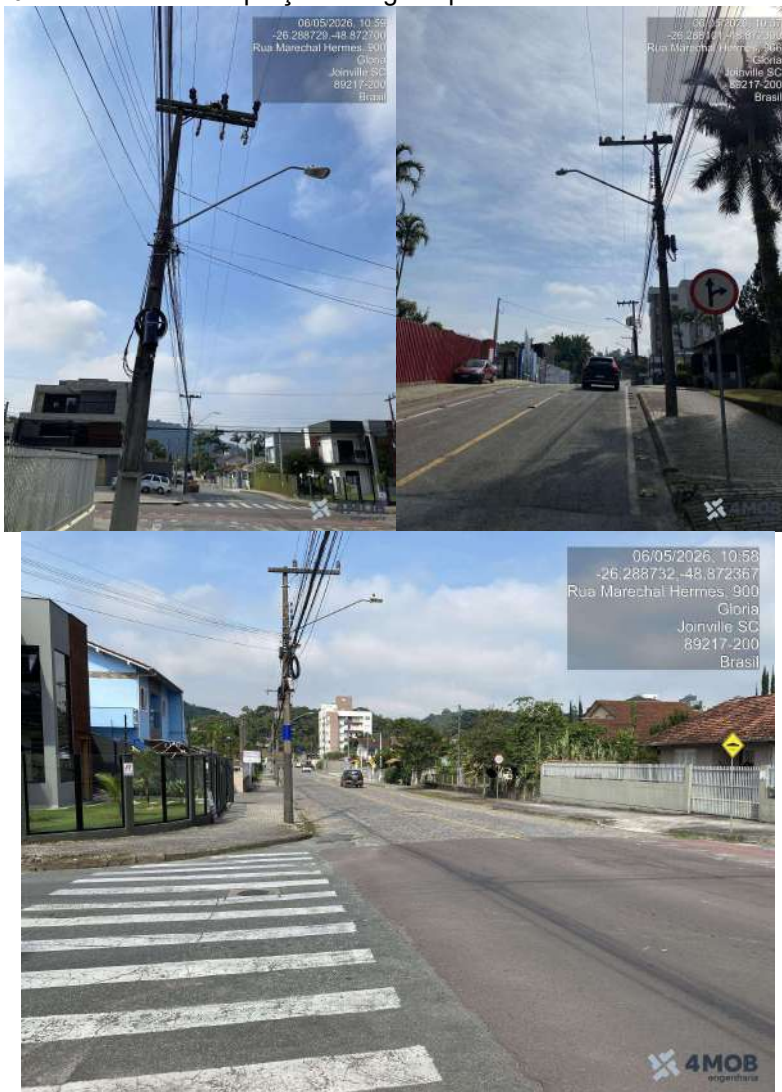
Figura 11 - Pontos de captação de águas pluviais na Rua Marechal Hermes
