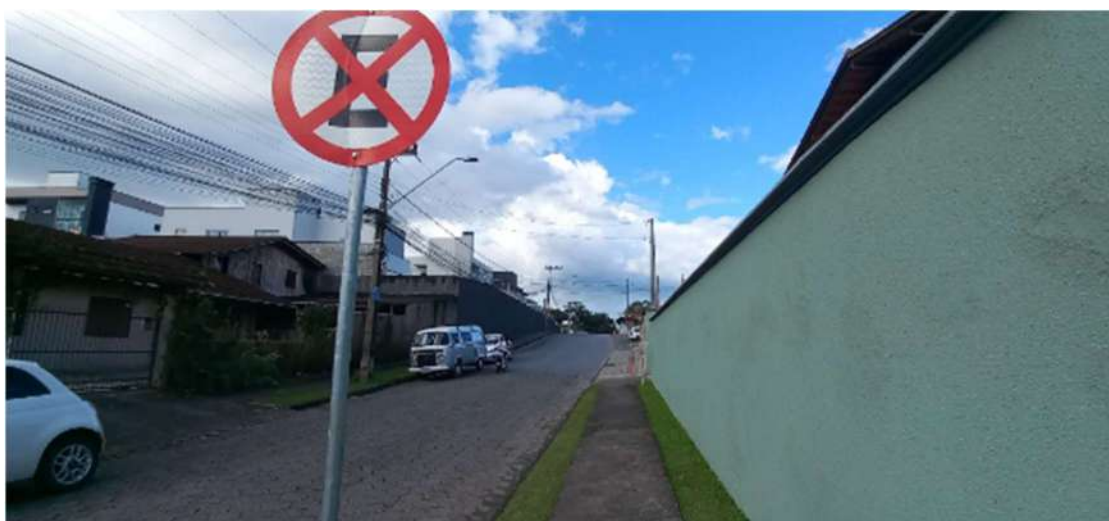
Figura 65 – Trecho de Rua com variação entre cercamentos permeáveis e áreas muradas, infraestrutura viária com pavimentação em diferentes tipos de materiais.
