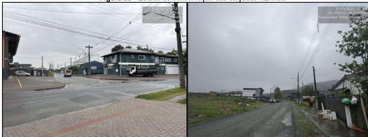
Figura 29 - Estado de conservação das calçadas vizinhas
