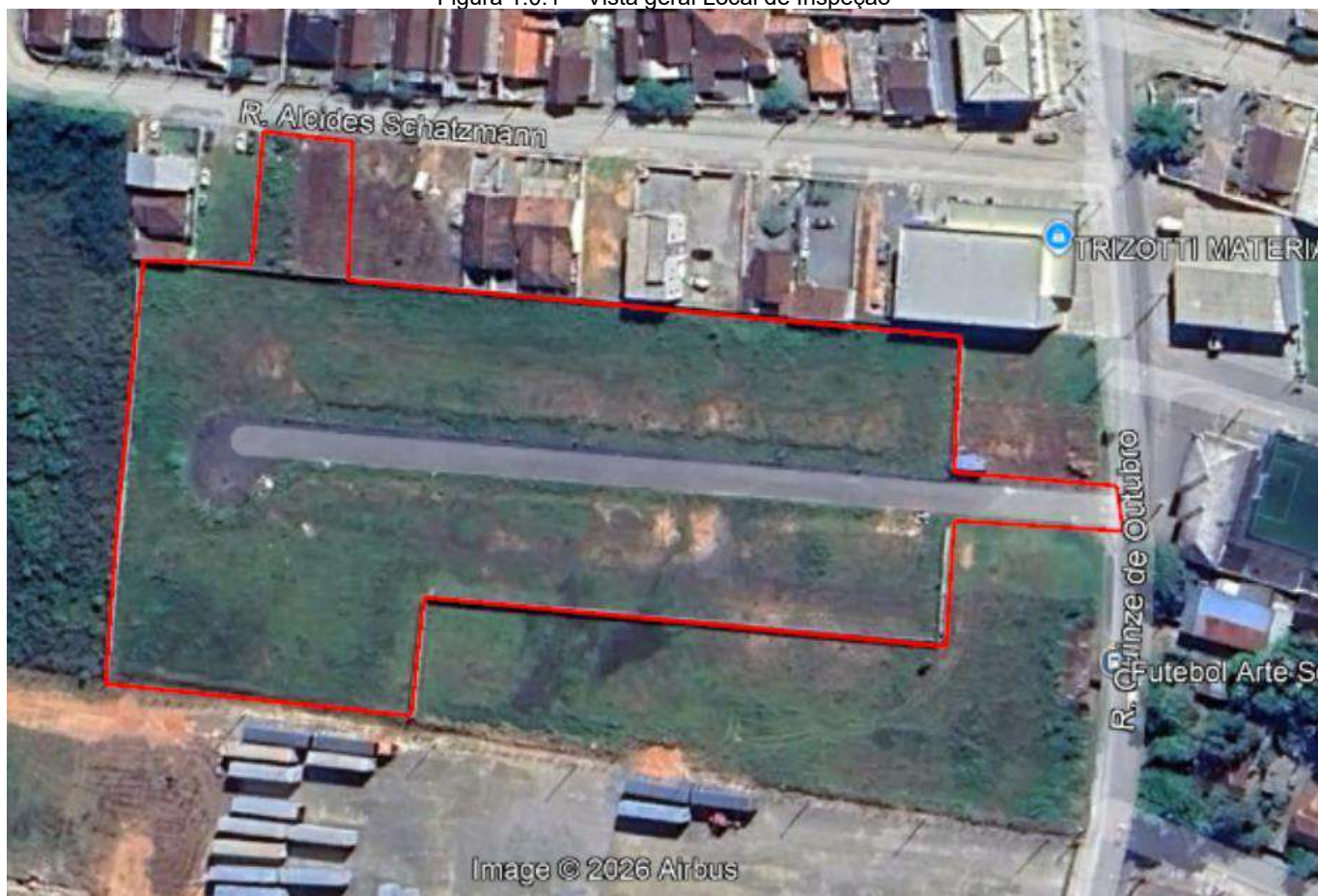
Figura 1.0.1 – Vista geral Local de Inspeção
