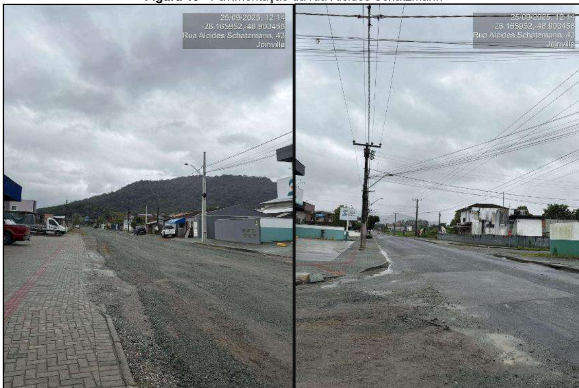
Figura 10 - Pavimentação da rua Alcides Schatzmann
