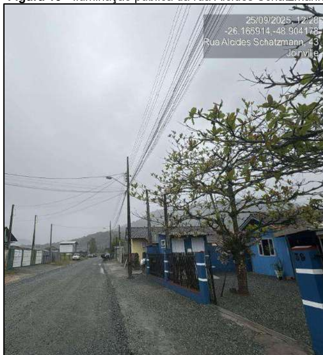
Figura 15 - Iluminação pública da rua Alcides Schatzmann
