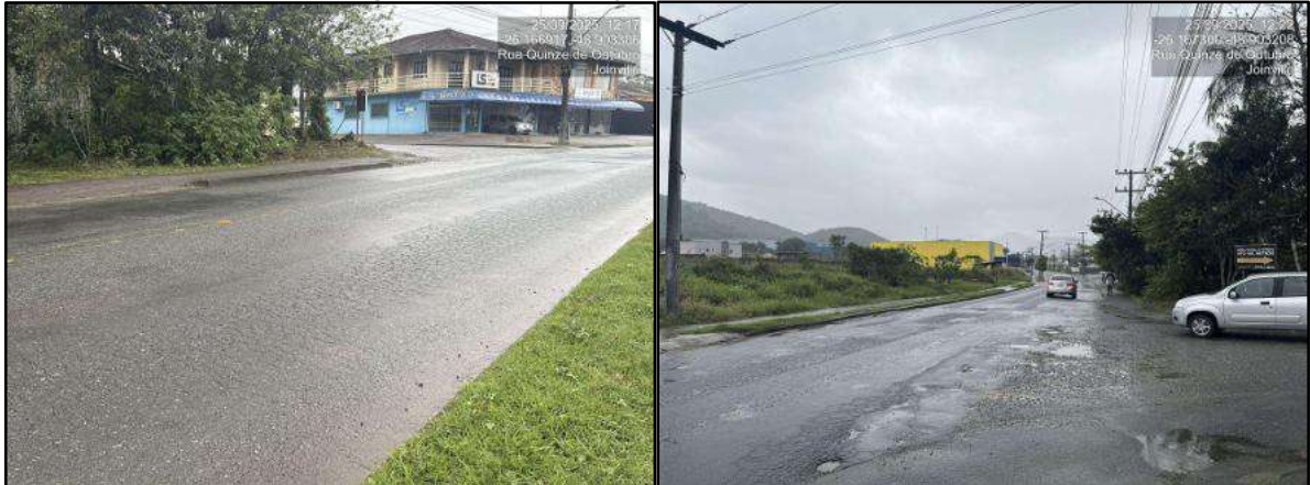
Figura 11 - Pavimentação da rua Quinze de Outubro
