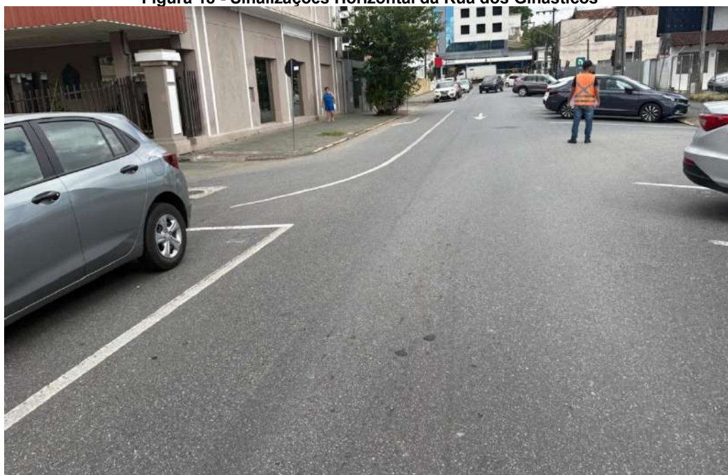
Figura 18 - Sinalizações Horizontal da Rua dos Ginásticos
