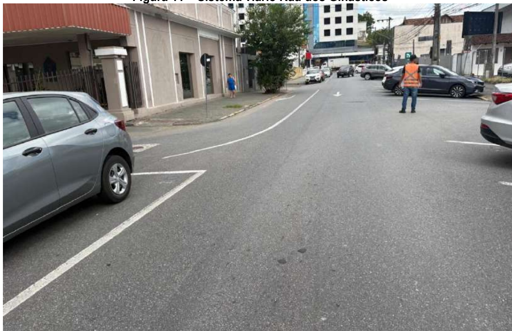
Figura 11 – Sistema viário Rua dos Ginásticos
