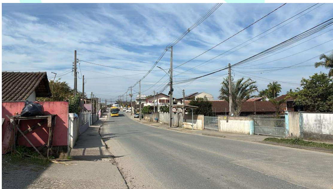
Figura 35: Condições atuais da Rua Antônio Alves
