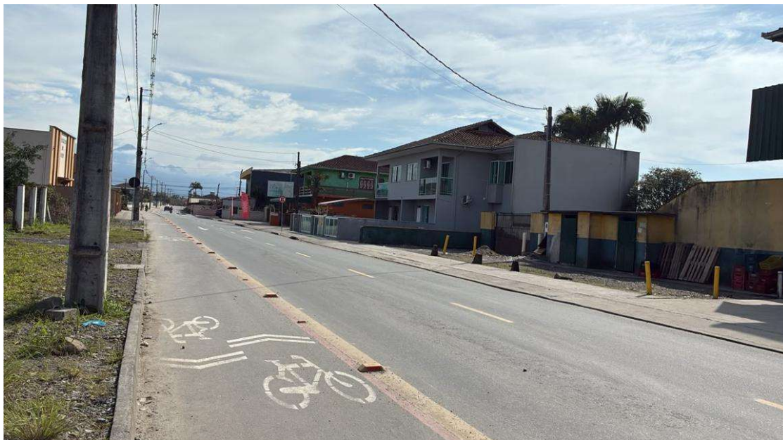
Figura 36: Condições atuais da Rua Porfíria Alves de Lima
