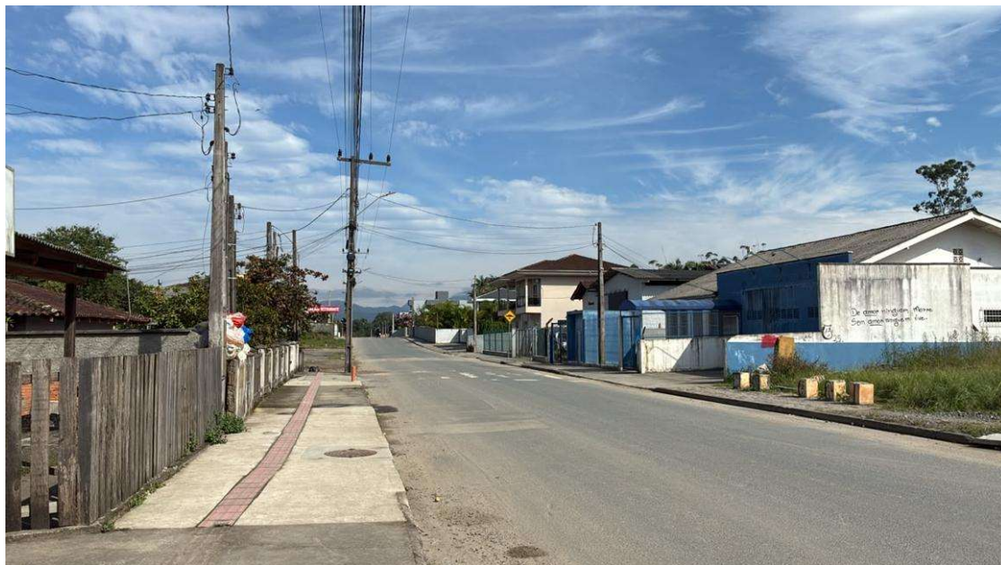
Figura 41: Passeios existentes na Rua Lagoinha
