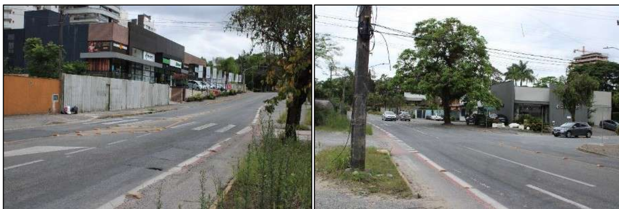
Figura 52 - Sinalização viária horizontal em frente ao empreendimento. Fonte: Bioeco, 2026.
