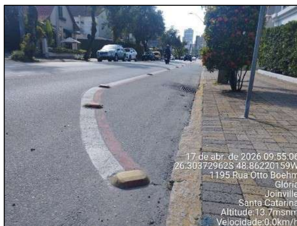
Figura 59 - Ciclofaixas em frente ao empreendimento. Fonte: Bioeco, 2026.
