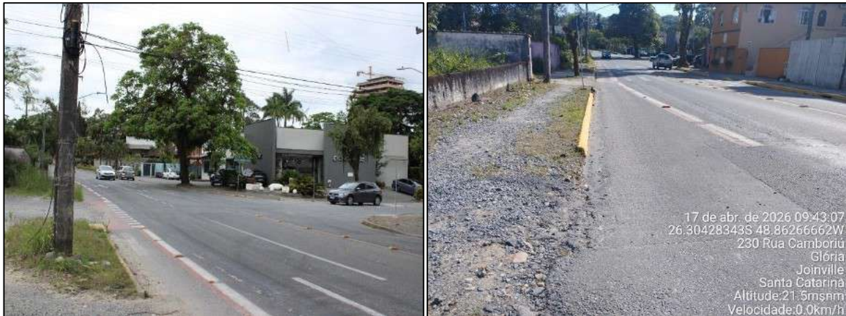
Figura 57 - Ciclofaixas em frente ao empreendimento. Fonte: Bioeco, 2026.
