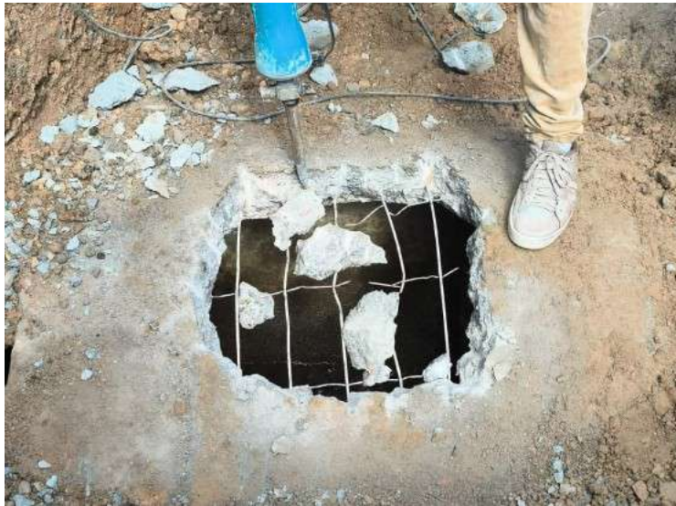
Figura 8 - Abertura da tubulação para inserção do robô de inspeção.
