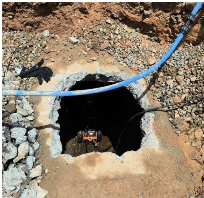
Figura 9 - Inserção do robô na rede.
