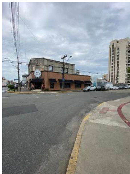
Postes de iluminação pública da AIE
