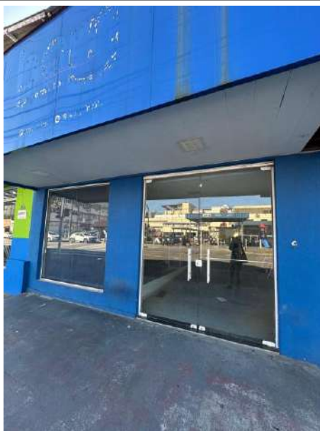
Imóvel desocupado na Av. Getúlio Vargas
