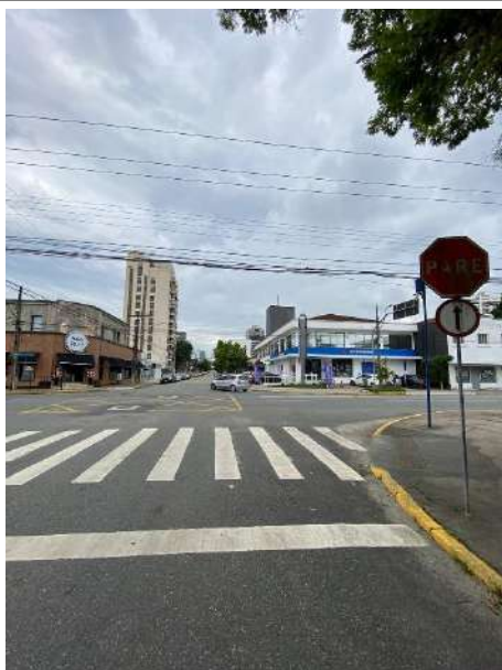
Pavimento da Rua Dr Plácido Gomes
