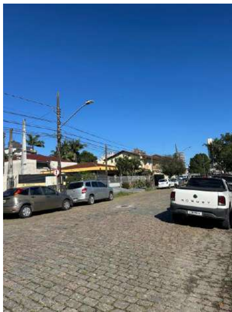
Paralelepípedo bem conservado na Rua Plácido Gomes
