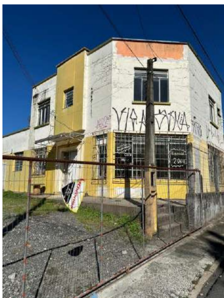
Imóvel desocupado em rua transversal à Av. Getúlio Vargas
