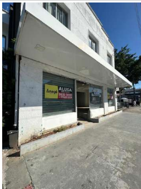
Imóvel desocupado na Av. Getúlio Vargas
