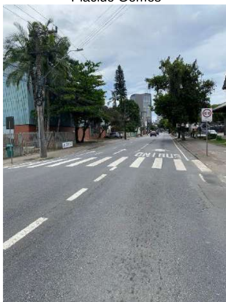
Pavimento da Rua São Paulo esquina com Dr Plácido Gomes
