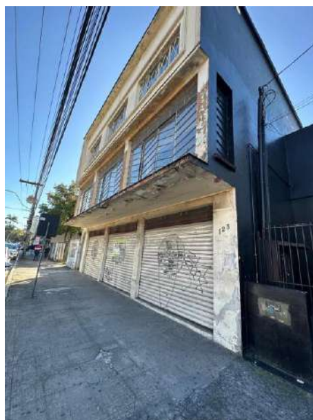
Imóvel desocupado na Av. Getúlio Vargas
