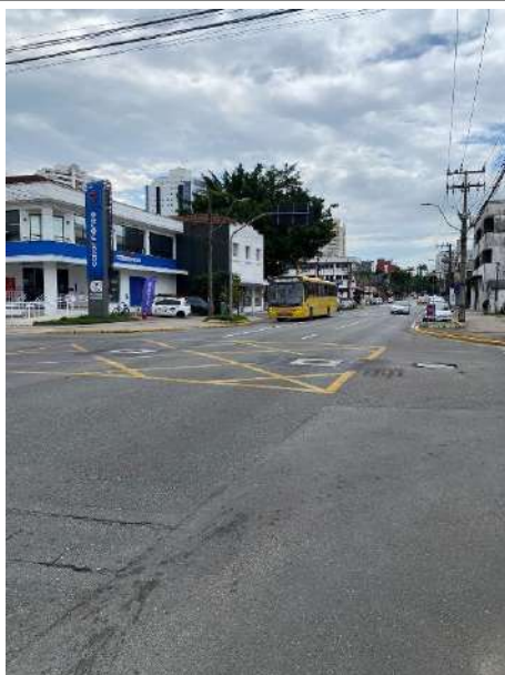
Pavimento na Av. Getúlio Vargas, na esquina do empreendimento
