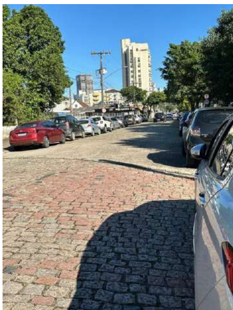
Paralelepípedo bem conservado na Rua Plácido Gomes
