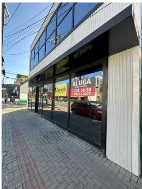
Imóvel desocupado na Av. Getúlio Vargas
