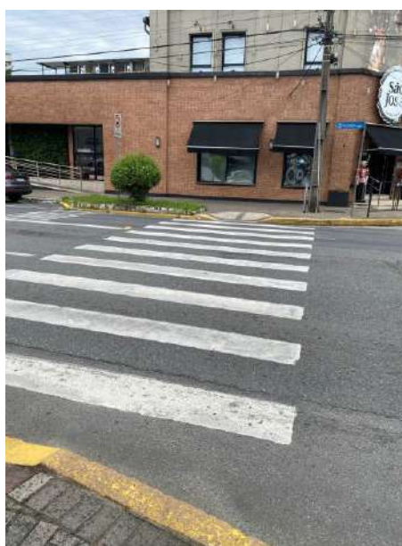
Sinalização horizontal na Av. Getúlio Vargas, após o empreendimento
