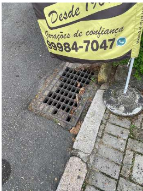
Dispositivos de drenagem próximos do empreendimento
