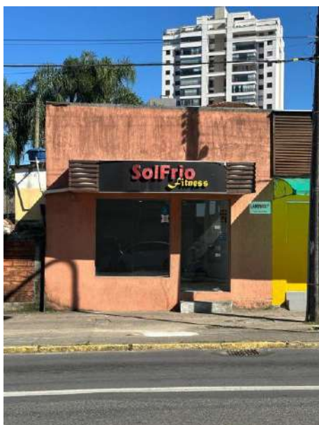
Imóvel desocupado na Av. Getúlio Vargas
