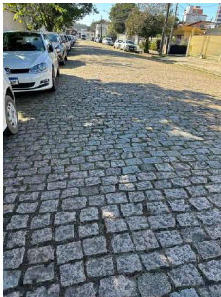
Paralelepípedo bem conservado na Rua Plácido Gomes
