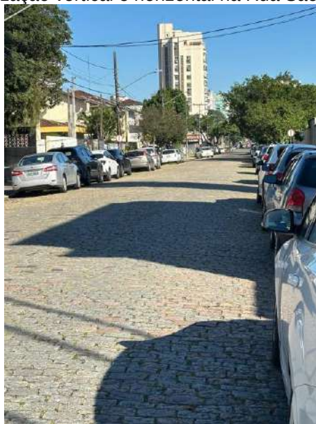
Paralelepípedo bem conservado na Rua Plácido Gomes
