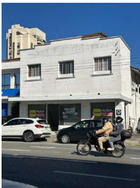
Imóvel desocupado na Av. Getúlio Vargas
