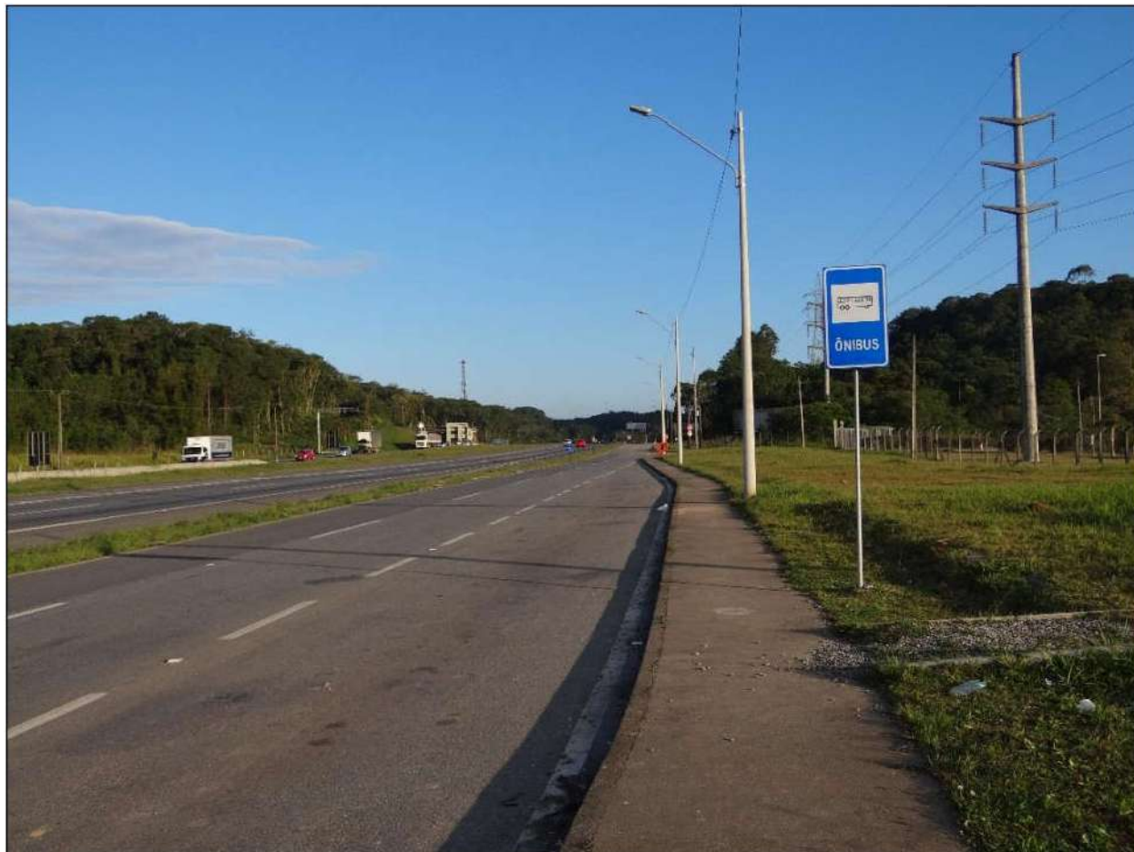
Acesso à área da GM a partir de pista lateral
