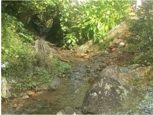
Foto 4.1.2.1-10: Detalhe para drenagem ao longo da encosta.
