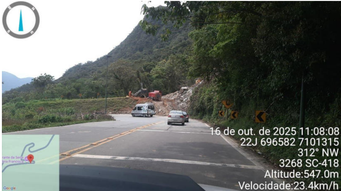
Construção de área de escape na rodovia SC-418. (Foto: Maiko Richter, 2025)
