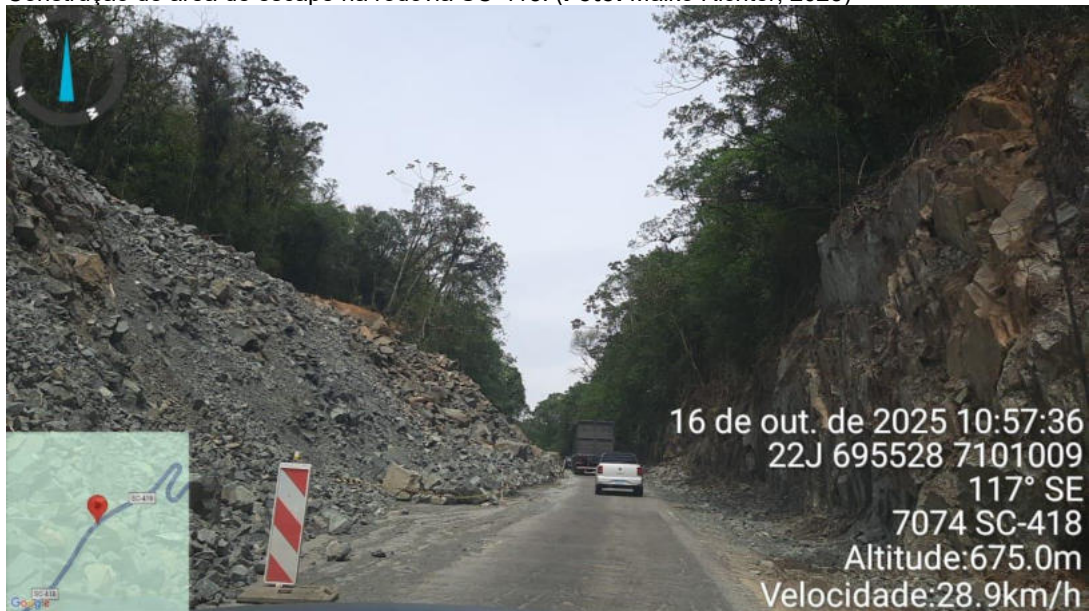
Obras em andamento na rodovia SC-418. (Foto: Maiko Richter, 2025)
