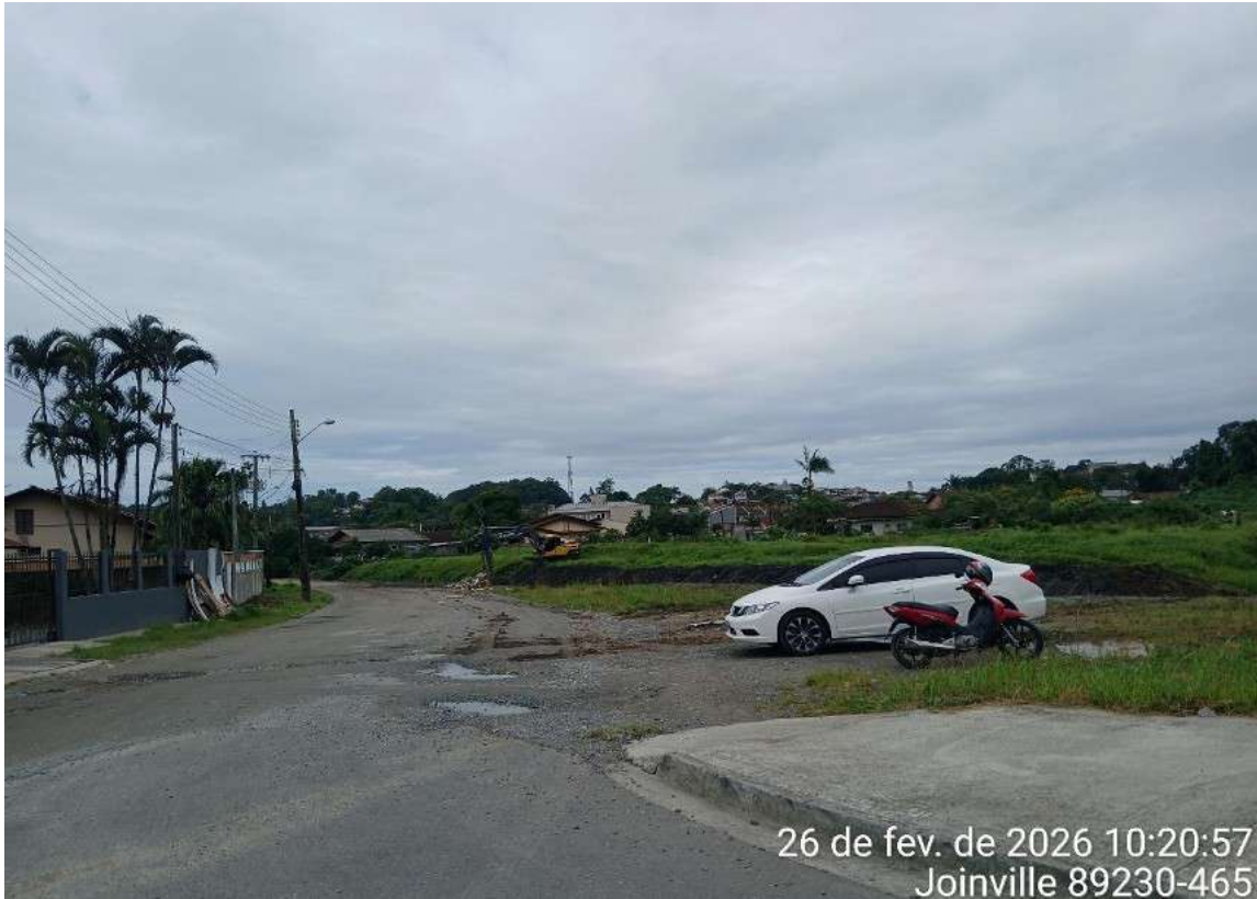
Figura 18: Rua Renato Caetano da Silva Fiho, cruzamento com a Rua Eurides Francisco Tomasoni.
