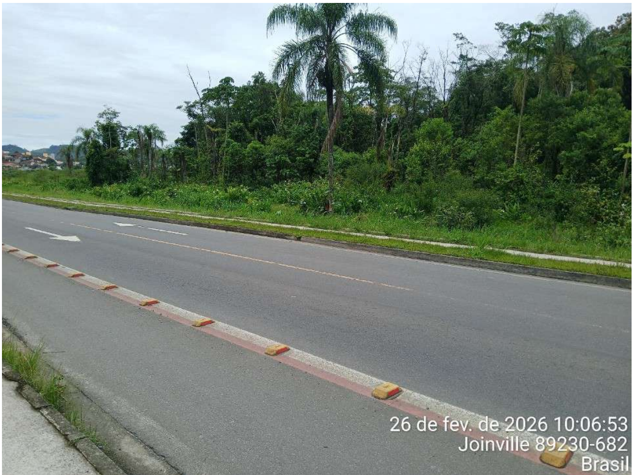
Figura 43: Trecho da rua em frente à Rua Eurides Francisco Tomasoni.
