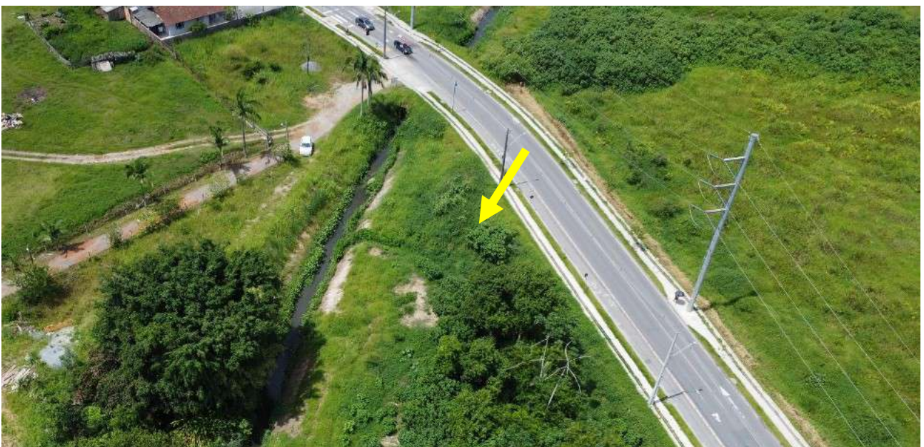
Figura 45: Indicação do imóvel em estudo. Também, é possível observar as delimitações do passeio, ciclofaixa e pista de rolamento da via.
