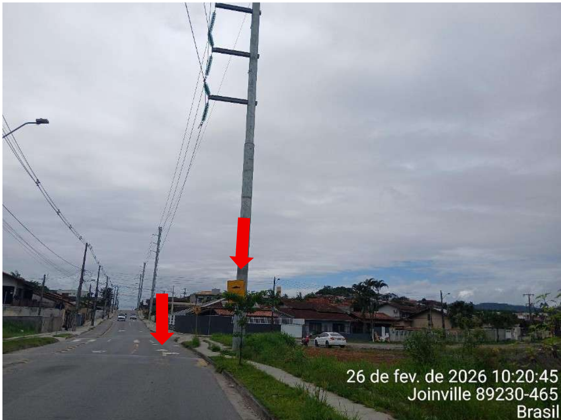
Figura 62: Rua Eurides Francisco Tomasoni, próximo ao imóvel. Vista sentido sul.
