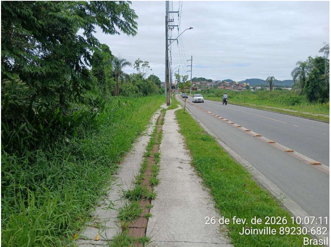
Figura 44: Calçada em frente ao imóvel em estudo.
