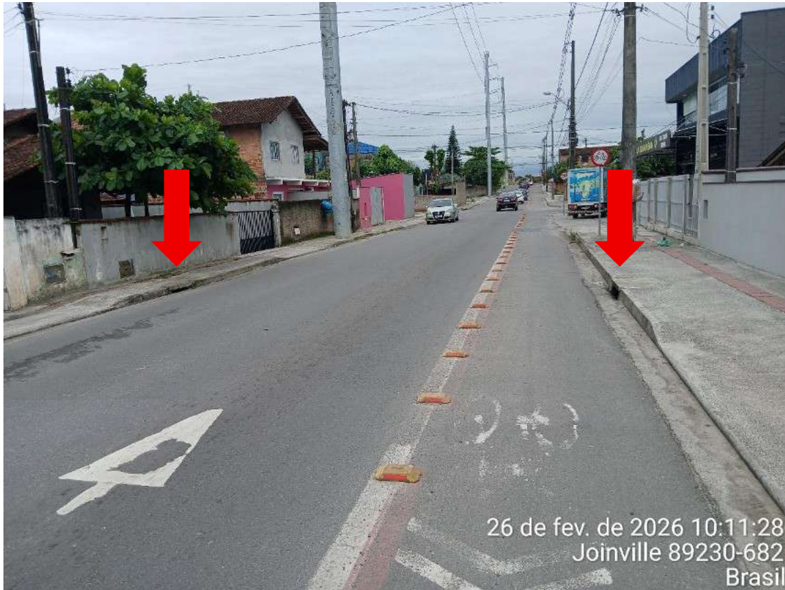
Figura 35: Bocas de lobo, Rua Eurides Francisco Tomasoni. Vista sentido norte.
