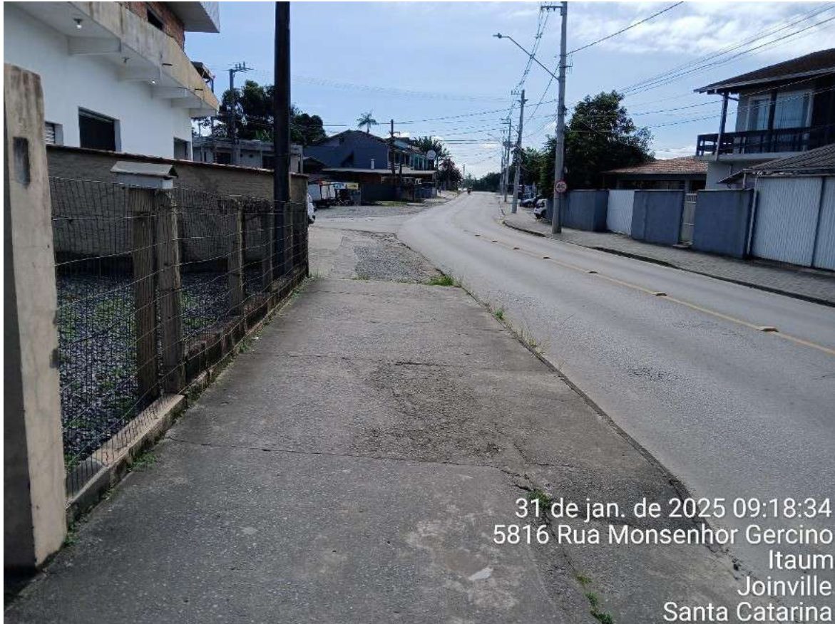
Pavimentação entorno do imóvel.
