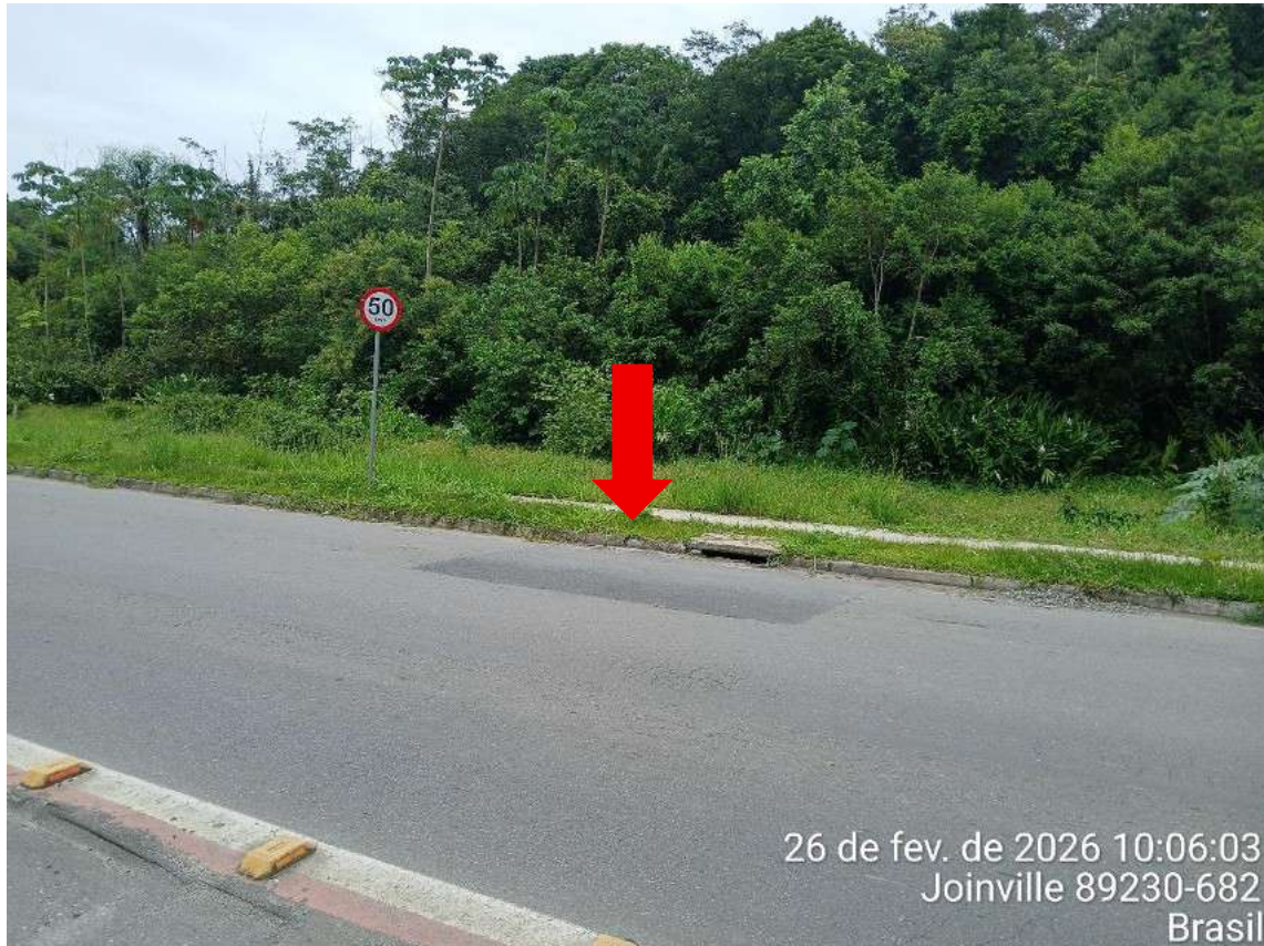
Figura 11: Rua Eurides Francisco Tomasoni, em frente ao imóvel. Vista sentido sul.
