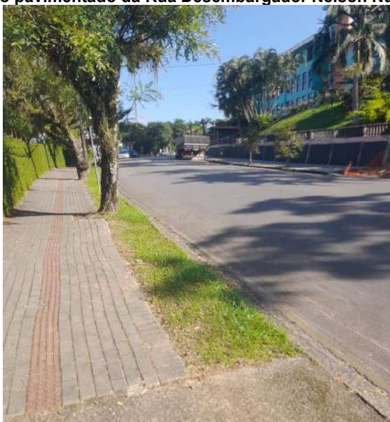
Figura 7 - Trecho pavimentado da Rua Desembargador Nelson Nunes Guimarães
