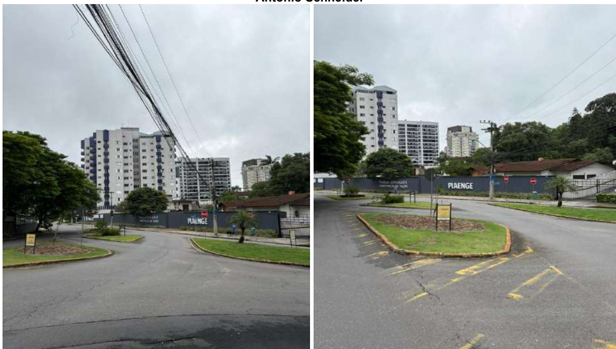
Figura 20 - Vista das Sinalizações do Trevo das Ruas Desembargador Nelson Nunes Guimarães e Oscar Antônio Schneider
