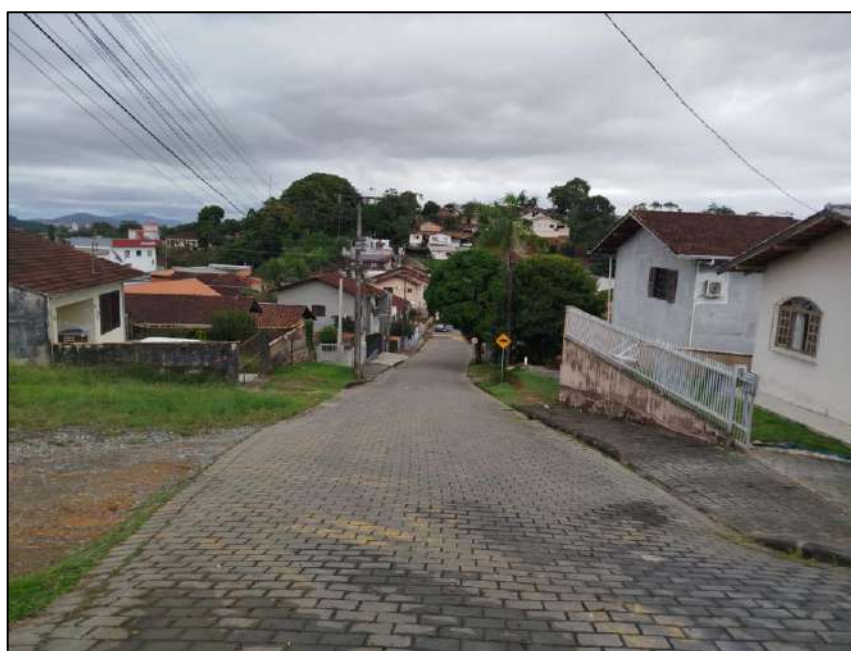
Rua Olindo J. Dias, com alguns trechos sem calçada.
