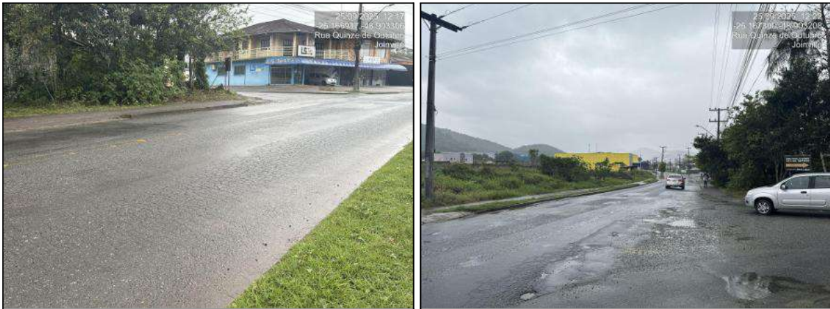
Figura 11 - Pavimentação da rua Quinze de Outubro
