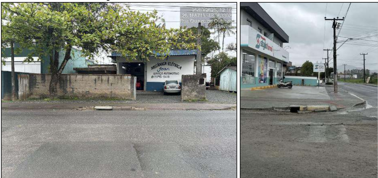
Figura 13 - Bocas de lobo existentes nas vias ao entorno
