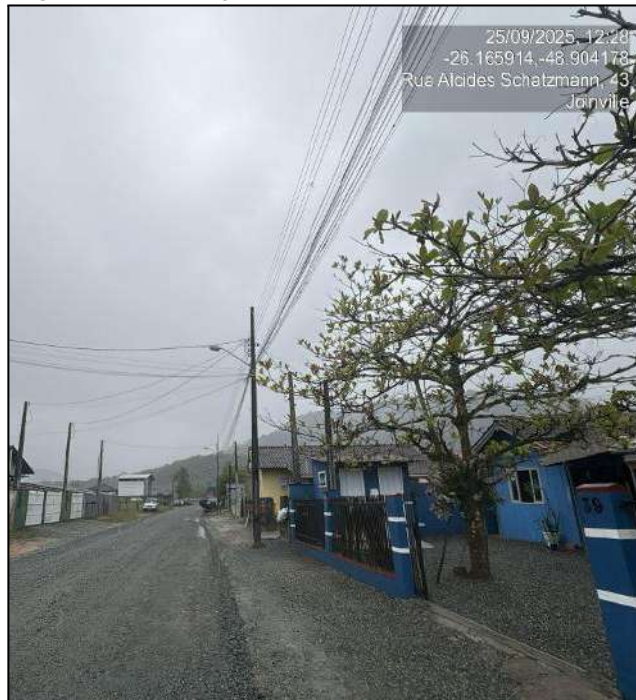
Figura 15 - Iluminação pública da rua Alcides Schatzmann
