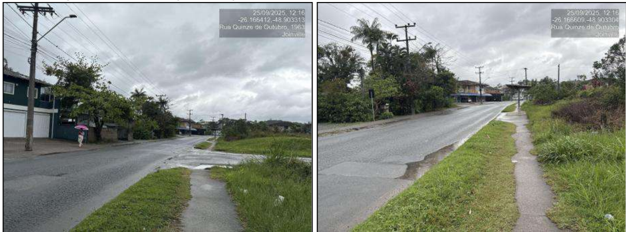
Figura 12 - Pavimentação da calçada da Rua Quinze de Outubro, em frente ao empreendimento
