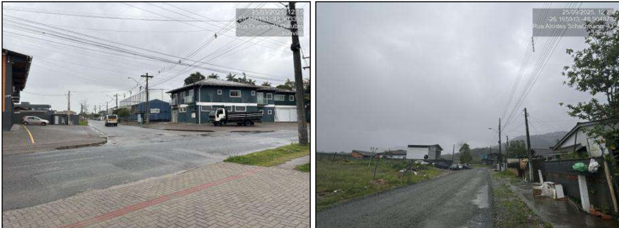
Figura 29 - Estado de conservação das calçadas vizinhas
