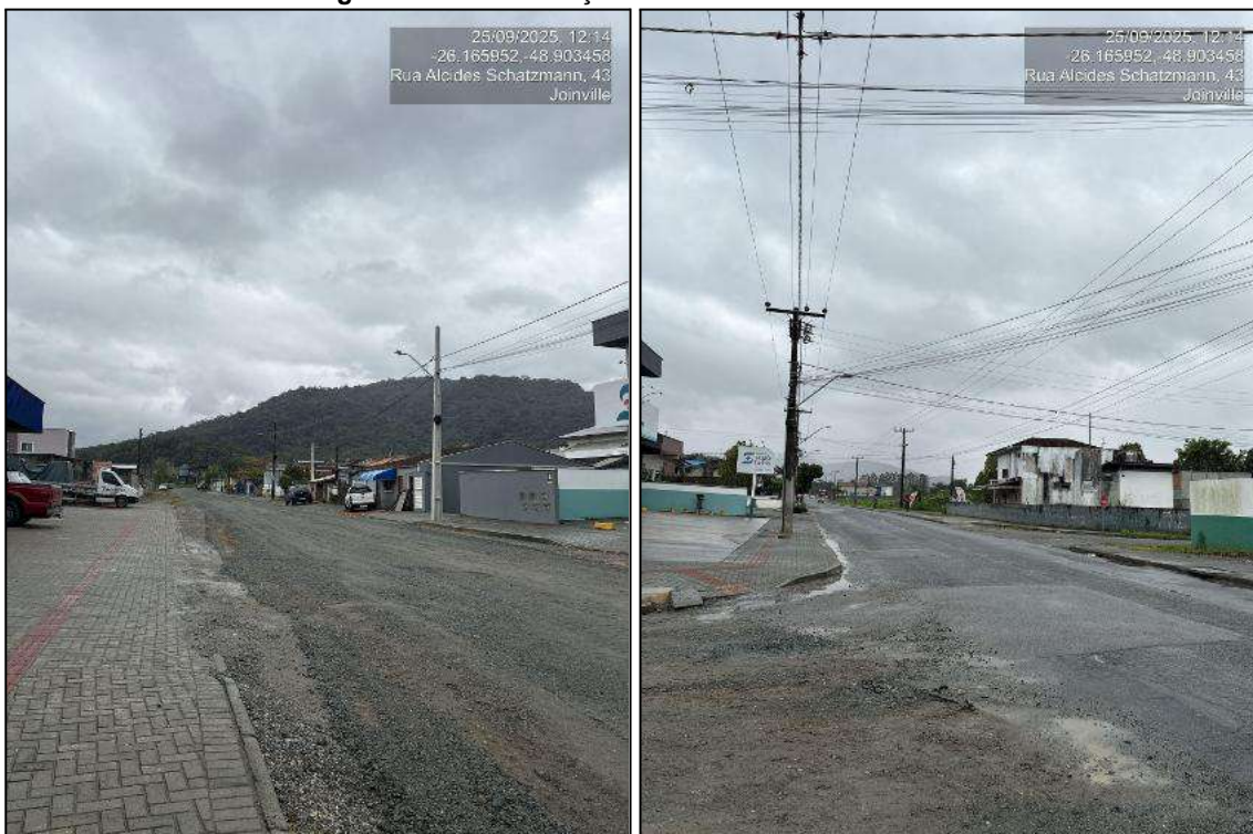
Figura 10 - Pavimentação da rua Alcides Schatzmann
