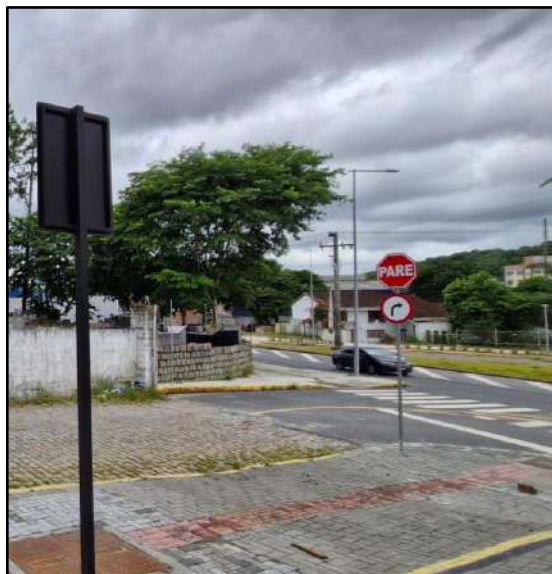
Figura 35: Sinalização na Rua Iguapé. Fonte: Arquivo pessoal, 2025.
