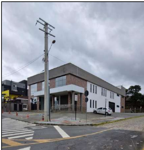
Figura 21 Poste com iluminação em frente ao empreendimento. Fonte: Arquivo pessoal, 2025.
