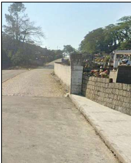
Figura 19: Sarjeta na Rua Iguapé. Fonte: Arquivo pessoal, 2025.
