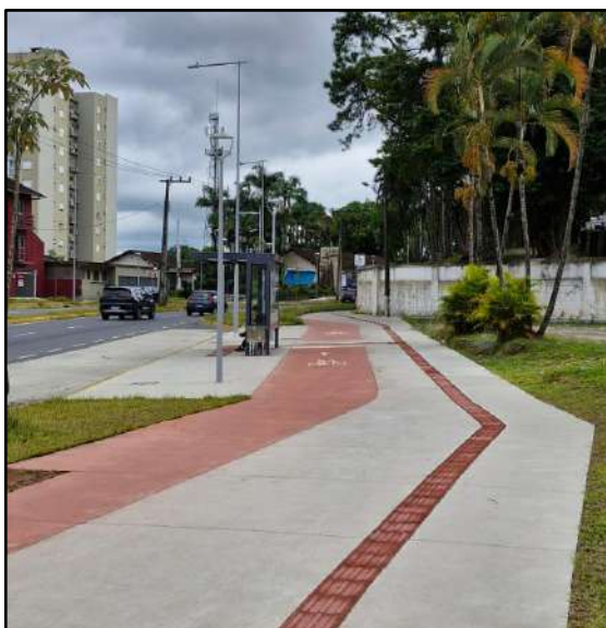
Figura 43: Abrigo de passageiros Rua Ottokar Doerffel. Fonte: Arquivo pessoal, 2025.
