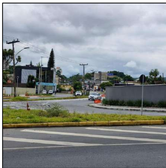
Figura 22 Poste com iluminação na Rua Ottokar Doerffel. Fonte: Arquivo pessoal, 2025.
