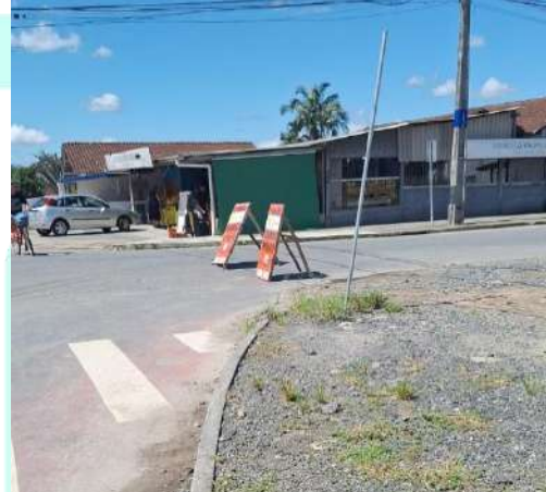
Figura 45 - Vista indicação obras Rua Lagoinha.
