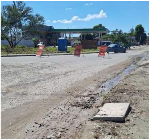
Figura 20 - Vista indicação obras Rua Minas Gerais.
