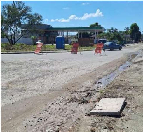
Figura 44 - Vista indicação obras Rua Minas Gerais.
