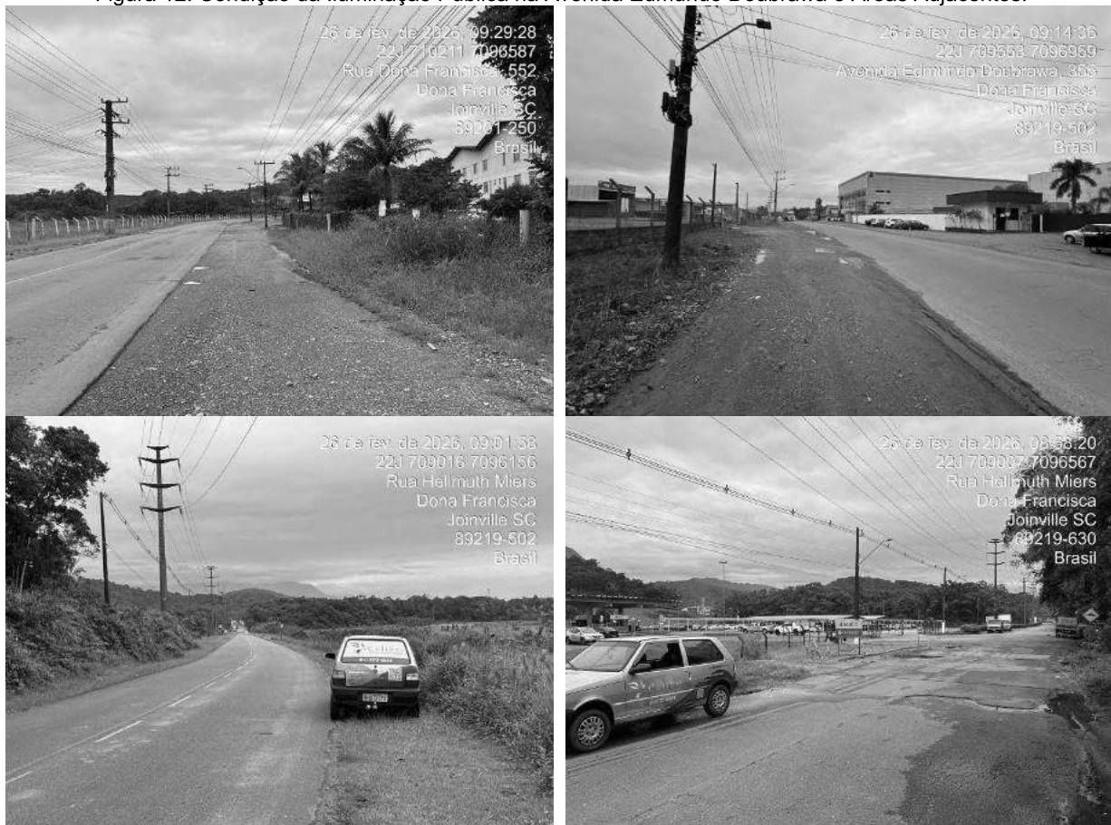
Figura 12. Condição da Iluminação Pública na Avenida Edmundo Doubrawa e Áreas Adjacentes.
