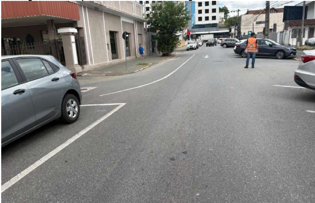
Figura 7 - Trecho pavimentado da Rua Desembargador Nelson Nunes Guimarães
