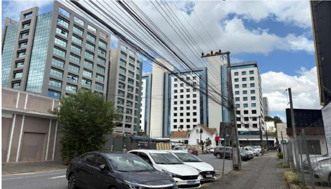
Figura 10 - Rede de abastecimento de energia elétrica
