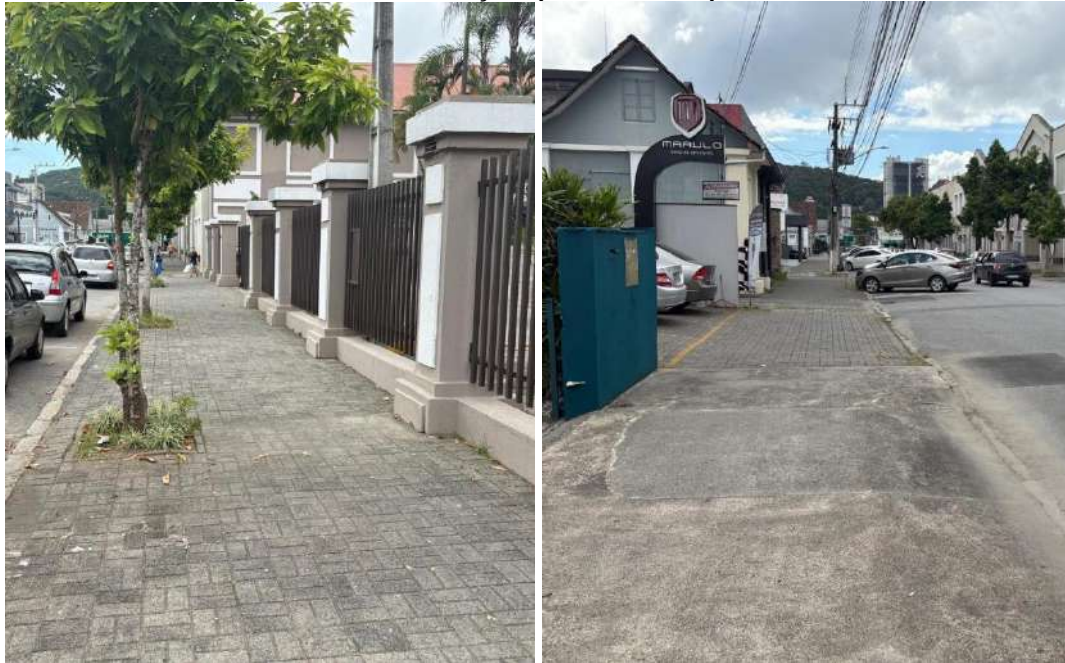
Figura 20 – Vista da calçada próximo ao empreendimento
