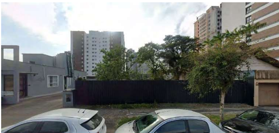
Figura 46: Vista defronte o sítio de locação do empreendimento. Fonte: AS Ambiental, 2025
