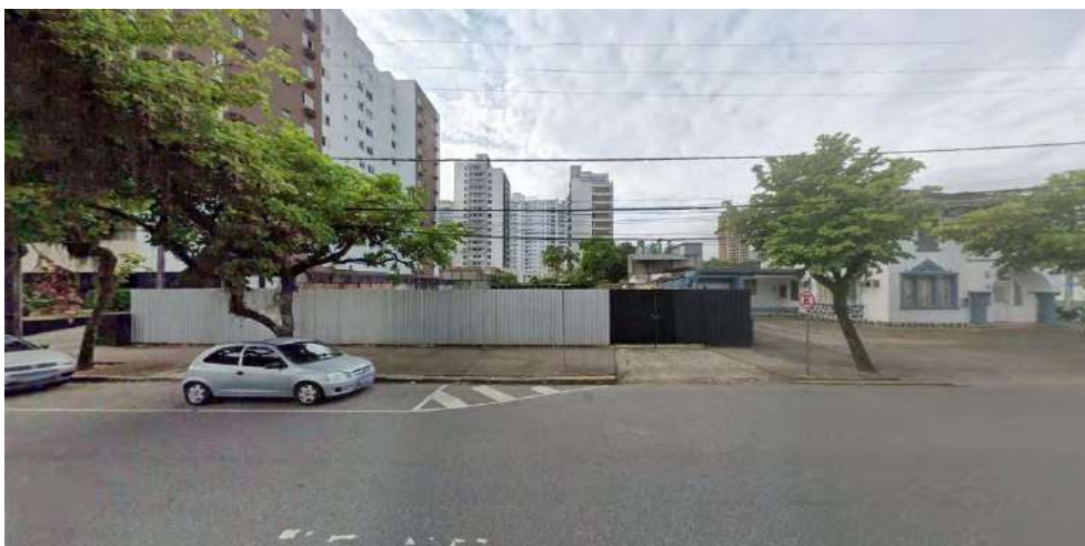
Figura 45: Vista defronte o sítio de locação do empreendimento. Fonte: AS Ambiental, 2025
