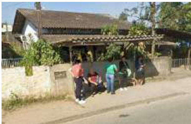
Figura 69 – Abrigo do Ponto de Ônibus na Rua Max Pruner, 1210
