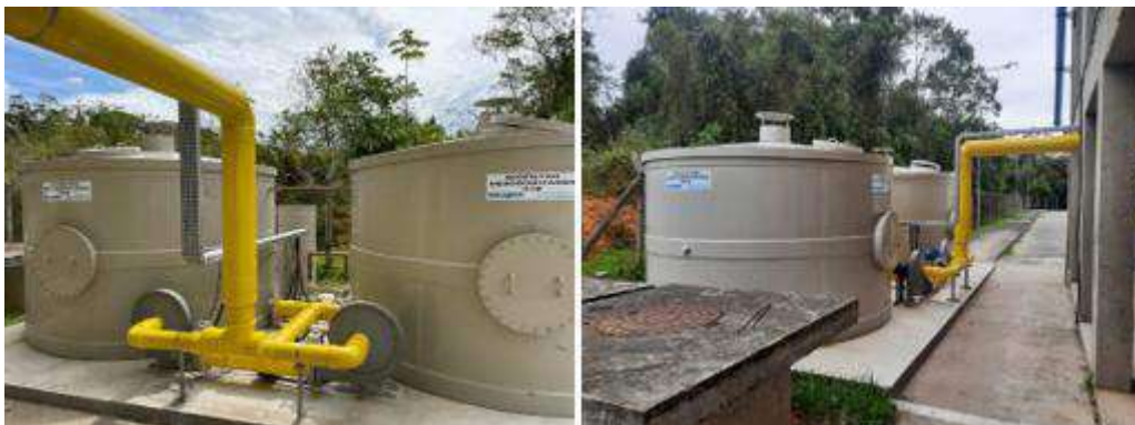
Figura 6 – Coleta, transporte e tratamento de gases odorantes provenientes da Caixa de Recepção.
