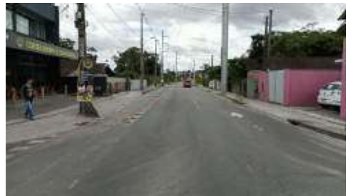
Figura 72 – Rua Eurides Francisco Tomasoni – ETE à esquerda (Ponto 17B)
