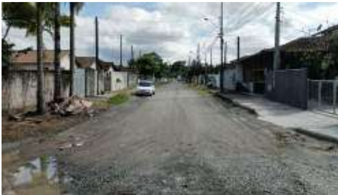
Figura 5 – Rua Dep. Aderbal Tavares Lopes – ETE à direita (Ponto 1C)
