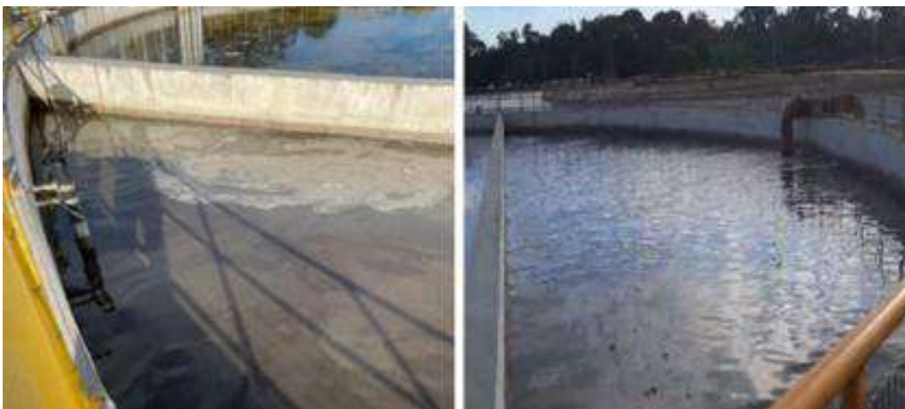
Figura 13 – À esquerda, detalhe da parede transversal de um dos reatores e da sonda de pH na entrada do tanque. À direita, observa-se toda a parede atravessando o reator, bem como a tubulação de alimentação do reator D.
