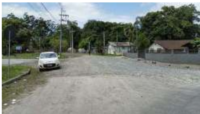
Figura 111 – Rua Rio Velho – ETE à esquerda (Ponto 26C)
