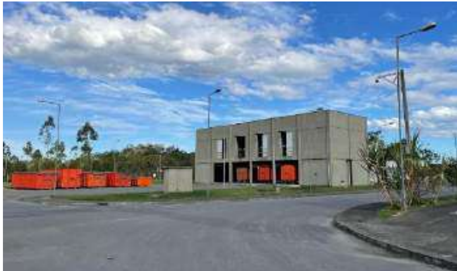
Figura 32 – Estação de Tratamento de Lodo. Vista externa da edificação. Detalhe das 03 caçambas de coleta de torta de lodo (uma para cada prensa em operação) e caçambas reservas na parte externa da ETL.
