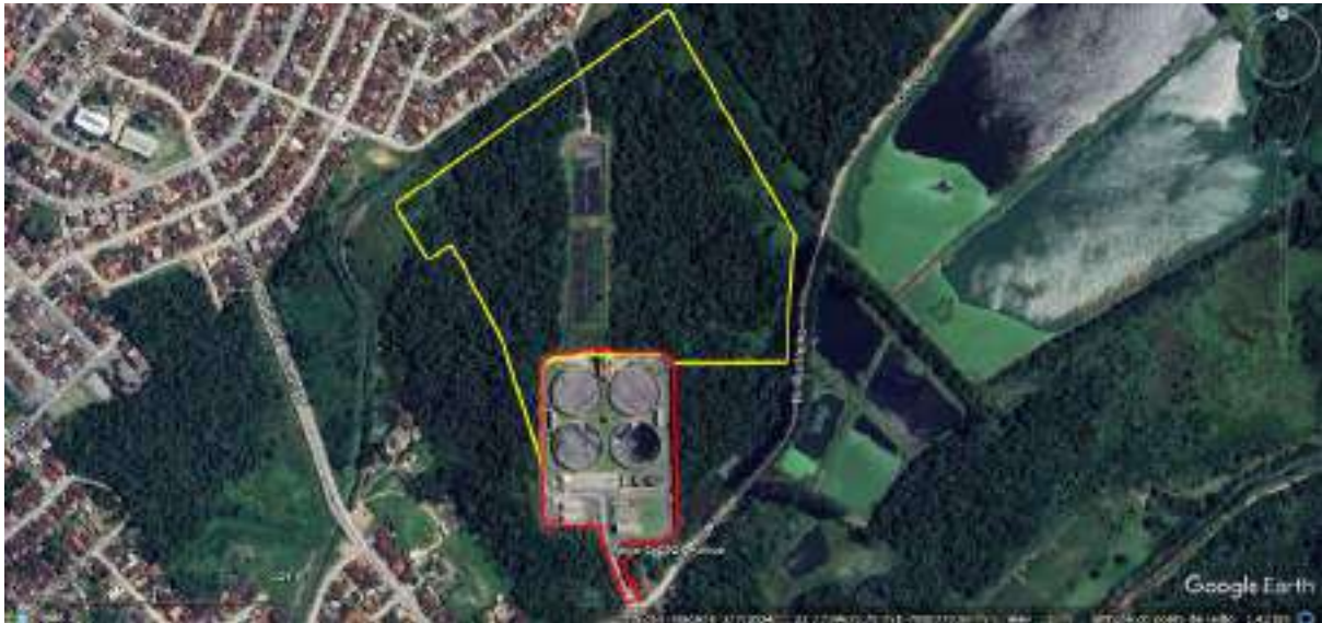
Figura 1 – Localização da área destinada à ampliação (linha amarela) e área da ETE Jarivatuba atual (linha vermelha)
