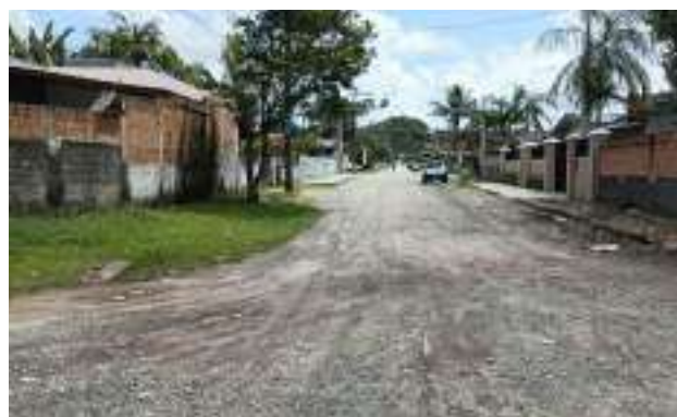
Rua Golda Meir – ETE à direita (Ponto 24D)
