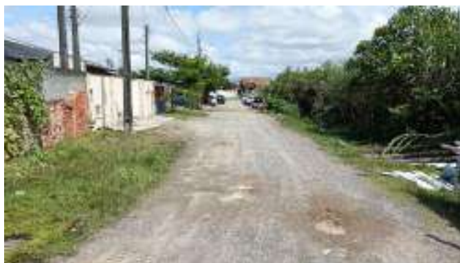
Figura 24 – Rua Sem Nome (Continuação da Doris Nobner Nass) – ETE Atrás (Ponto 6A)
