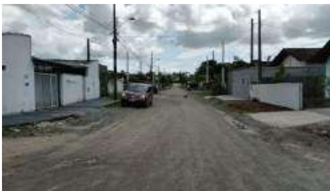
Figura 41 – Rua Alfredo Stringari – ETE à direita (Ponto 10C)
