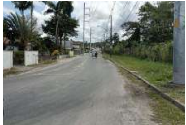
Figura 53 – Rua Rio Velho (ETE Jarivatuba à direita)
