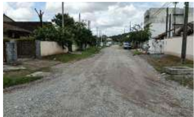
Rua Alfredo Stringari – ETE à esquerda (Ponto 10D)
