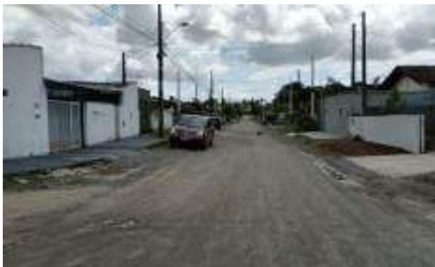
Rua Alfredo Stringari – ETE à direita (Ponto 10C)
