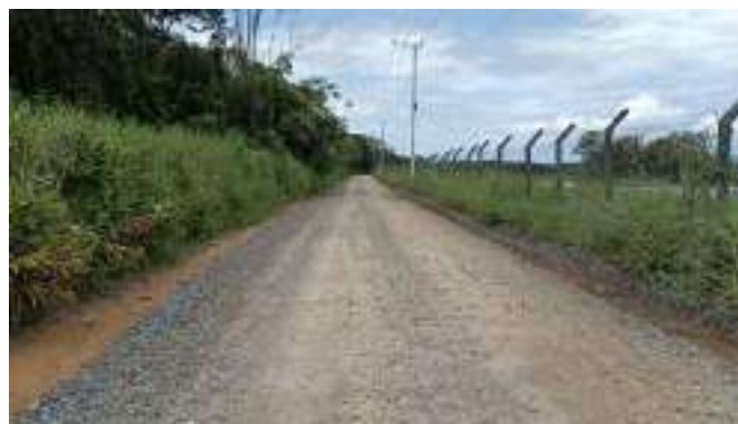
Figura 120 – Rua Rio Velho – ETE à esquerda (Ponto 29B)
