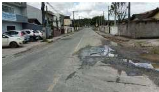
Figura 47 – Rua Max Pruner – ETE à esquerda (Ponto 11D)
