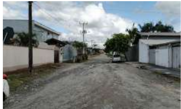
Rua Cidade de Ourinho – ETE Atrás (Ponto 10B)
