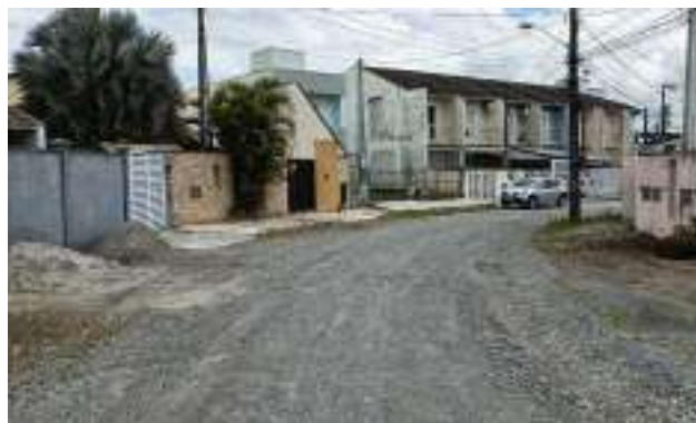
Rua Enéas Marques – ETE Atrás (Ponto 20A)
