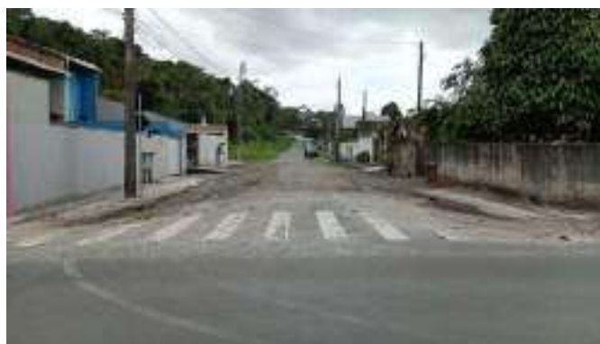
Figura 73 – Rua Dep. Aderbal Tavares Lopes – ETE Atrás (Ponto 17C)
