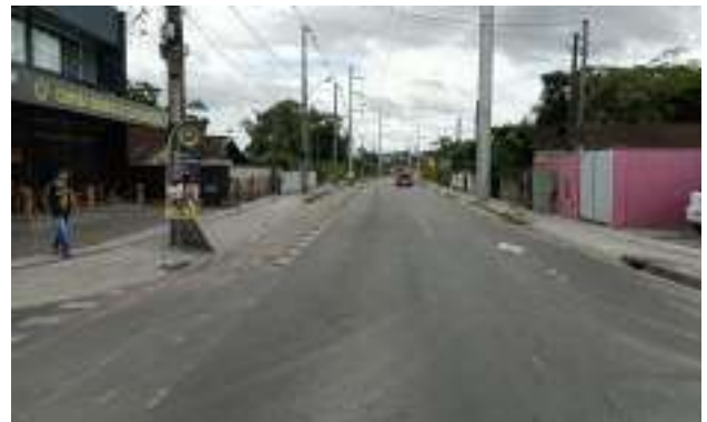
Rua Eurides Francisco Tomasoni – ETE à esquerda (Ponto 17B)
