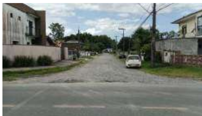
Figura 98 – Rua Min. Marcos Freire – ETE à esquerda (Ponto 23D)
