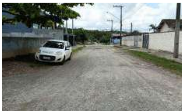
Rua José Clara de Oliveira – ETE à Frente (Ponto 12A)
