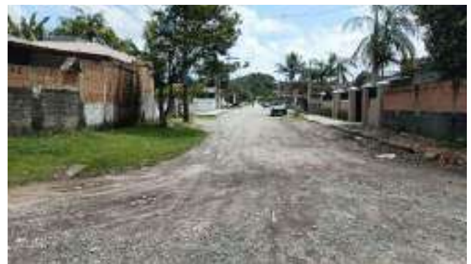
Figura 103 – Rua Golda Meir – ETE à direita (Ponto 24D)
