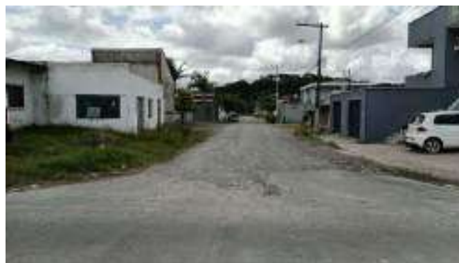
Figura 45 – Rua Cidade de Ourinhos – ETE à Frente (Ponto 11B)
