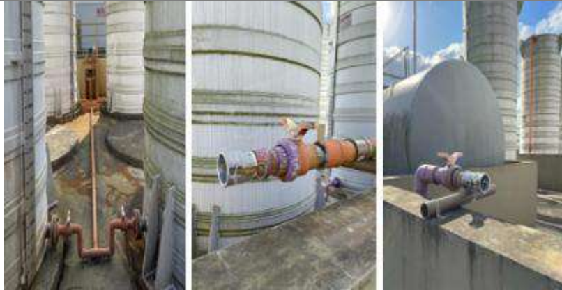
Figura 31 – Tanques de armazenamento de produtos químicos. À esquerda, detalhe da tubulação comunicante entre os tanques de FeCl 3 . Ao centro e à direita, detalhe dos engates rápidos para a alimentação dos tanques de FeCl 3 e NaOH, respectivamente.
