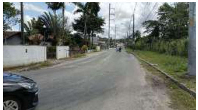
Figura 110 – Rua Rio Velho – ETE à direita (Ponto 26B)
