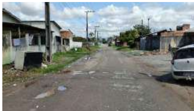
Figura 21 – Rua Cidade de Guarulhos – ETE Atrás (Ponto 5B)
