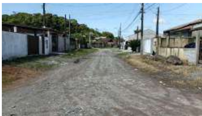
Figura 22 – Rua Dep. Aderbal Tavares Lopes – ETE à esquerda (Ponto 5C)
