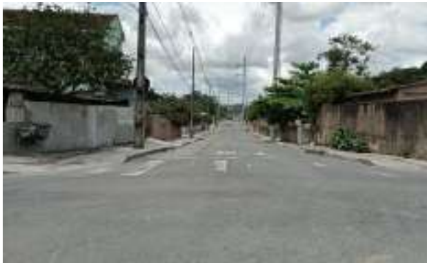
Rua Eurides Francisco Tomasoni – ETE à esquerda (Ponto 15A)
