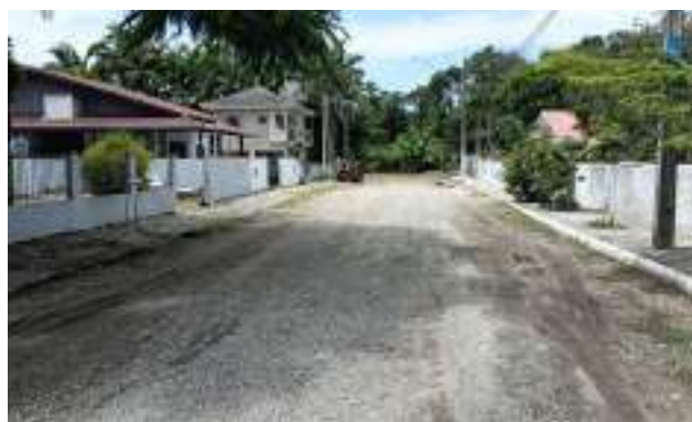
Rua Golda Meir – ETE à esquerda (Ponto 24C)
