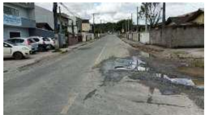
Figura 47 – Rua Max Pruner – ETE à esquerda (Ponto 11D)
