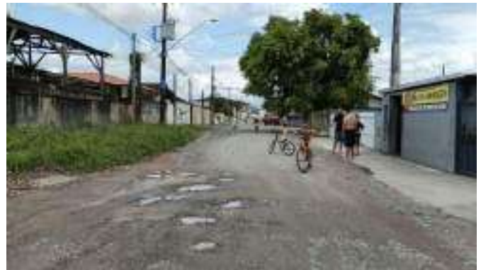
Figura 50 – Rua José Clara de Oliveira – ETE Atrás (Ponto 12B)
