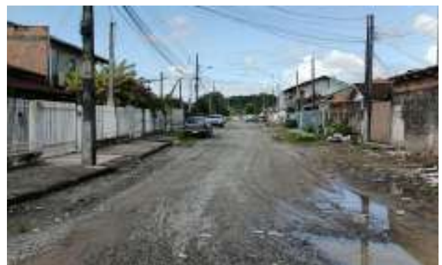
Rua Dep. Aderbal Tavares Lopes – ETE à esquerda (Ponto 1D)
