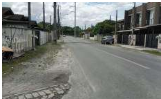
Rua Atila Urban – ETE à Frente (Ponto 23B)
