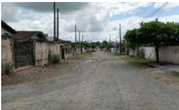
Rua Dep. Aderbal Tavares Lopes – ETE à direita (Ponto 13C)
