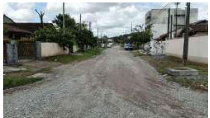
Figura 42 – Rua Alfredo Stringari – ETE à esquerda (Ponto 10D)
