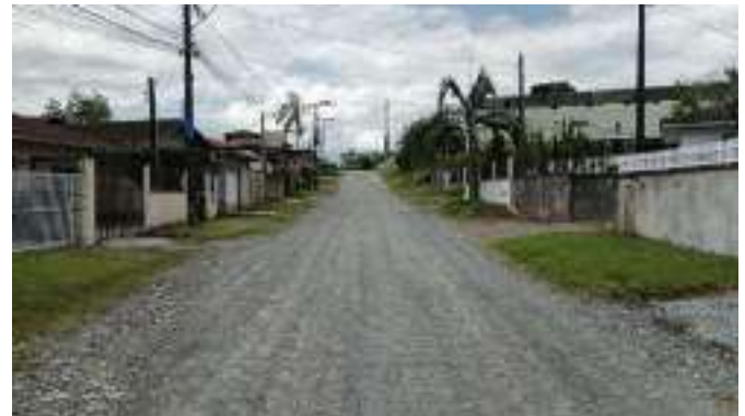
Figura 84 – Rua Enéas Marques – ETE à Frente (Ponto 20B)
