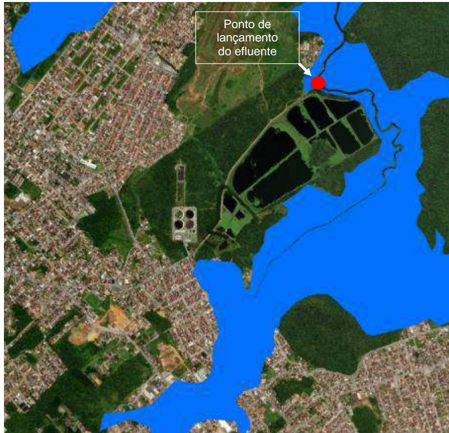
Figura 48 – Mancha de Inundação próxima a área do empreendimento e ponto de lançamento do efluente tratado no Rio Velho
