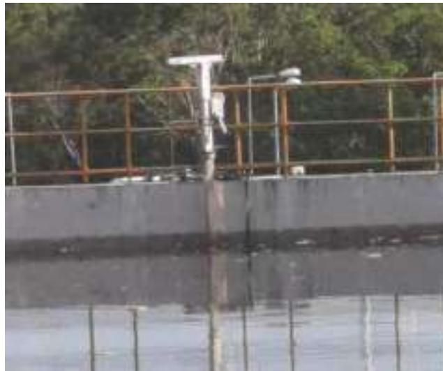
Figura 17 – Guia de recolhimento de um dos misturadores de parede do reator B. O outro misturador fica exatamente no local de onde foi tirada a foto.
