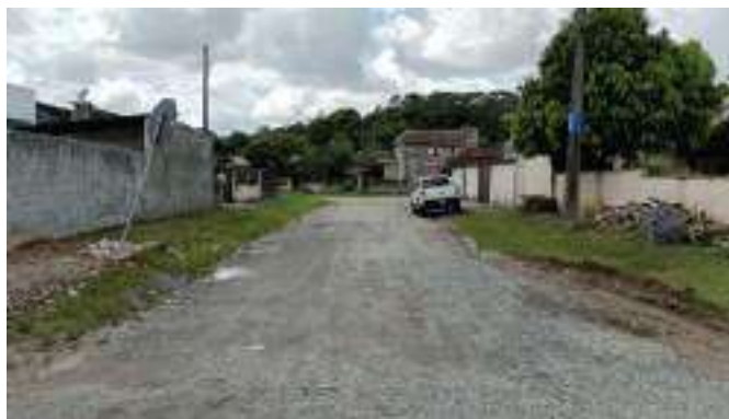
Figura 39 – Rua Cidade de Ourinho – ETE  Frente (Ponto 10A)
