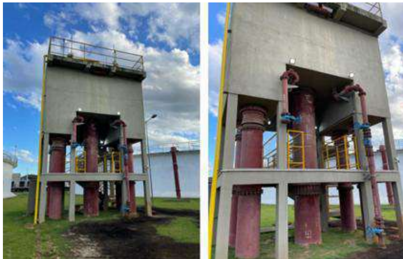
Figura 9 – Torre de Distribuição.
