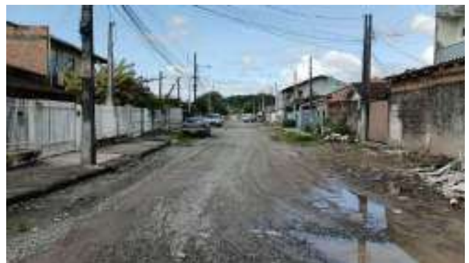
Figura 6 – Rua Dep. Aderbal Tavares Lopes – ETE à esquerda (Ponto 1D)
