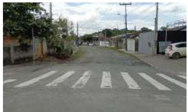
Rua Alfredo Stringari – ETE à Frente (Ponto 17D)
