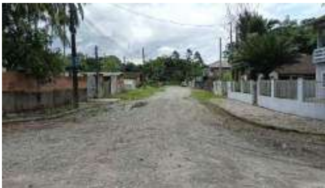
Figura 100 – Rua Hildebrando Soares – ETE à Frente (Ponto 24A)
