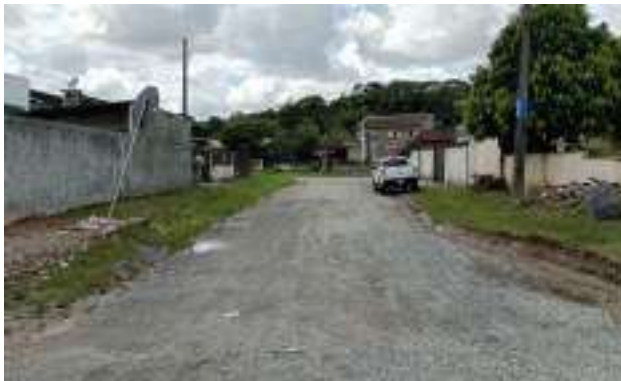
Rua Cidade de Ourinho – ETE à Frente (Ponto 10A)
