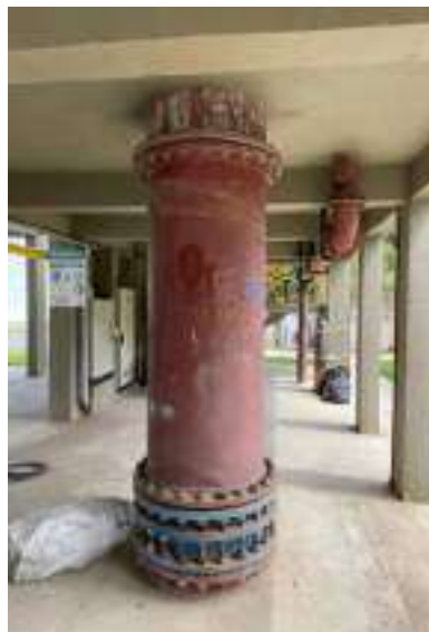
Figura 4 – Entrada da linha de recalque da EEE Florianópolis na ETE Jarivatuba, recalcando o esgoto para a Caixa de Recepção
