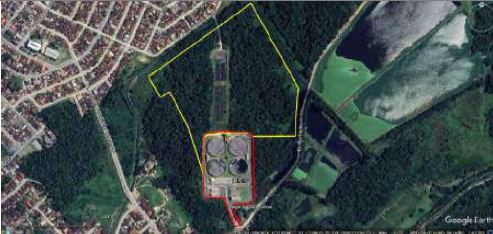
Figura 1 – Localização da área destinada à ampliação (linha amarela) e área da ETE Jarivatuba atual (linha vermelha)
