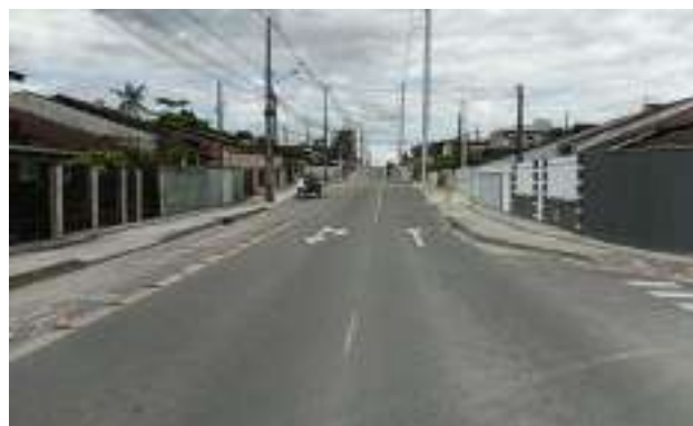
Rua Elza de Oliveira – ETE à esquerda (Ponto 18B)
