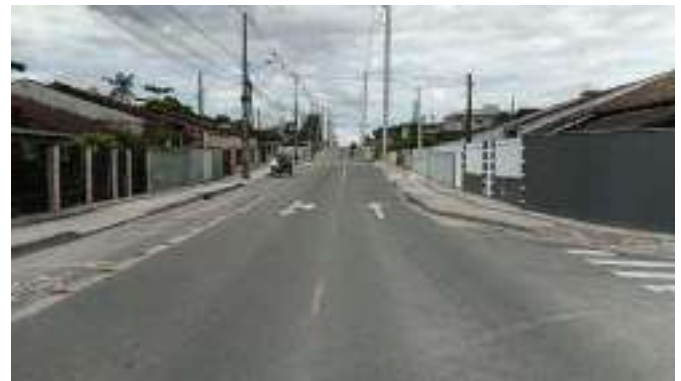
Figura 77 – Rua Elza de Oliveira – ETE à esquerda (Ponto 18B)
