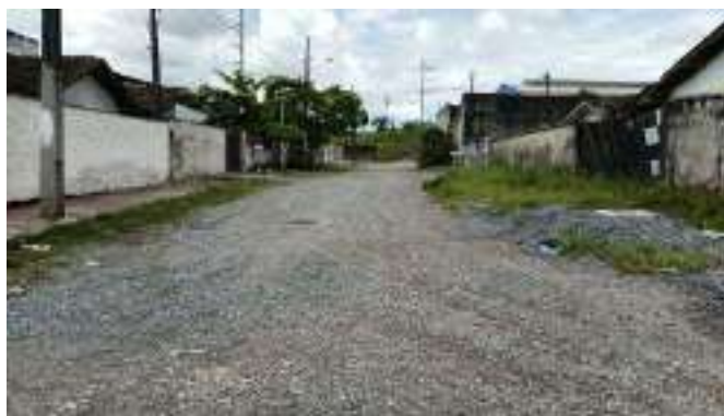
Figura 51 – Rua Amélia Zucco – ETE à esquerda (Ponto 12C)
