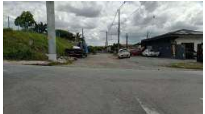
Figura 64 – Rua Eurides Francisco Tomasoni – ETE à direita (Ponto 15B)
