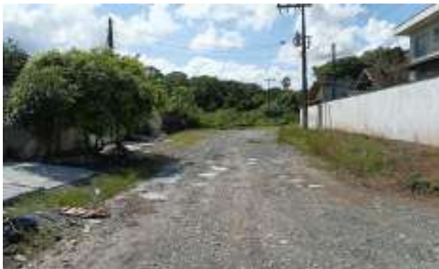
Rua Cidade de Guarulhos – ETE a Frente (Ponto 5A)
