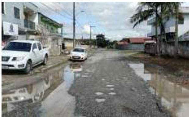
Rua Cidade de Guarulhos – ETE Atrás (Ponto 1A)
