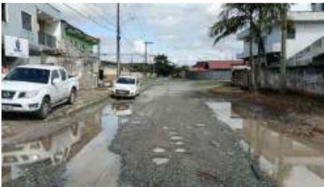
Figura 3 – Rua Cidade de Guarulhos – ETE Atrás (Ponto 1A)
