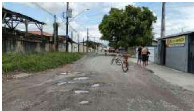
Figura 50 – Rua José Clara de Oliveira – ETE Atrás (Ponto 12B)
