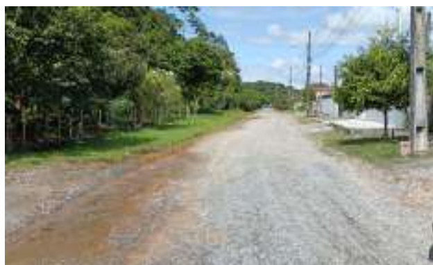
Rua Dóris Dobner Nass – ETE à esquerda (Ponto 7A)
