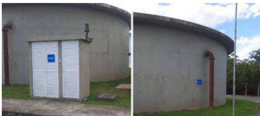
Figura 27 – Saída de água superficial dos adensadores por gravidade.
