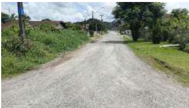
Figura 107 – Rua Min. Marcos Freire – ETE à direita (Ponto 25C)
