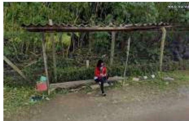
Figura 70 – Abrigo do Ponto de Ônibus na Rua Rio Velho frente ao nº 908
