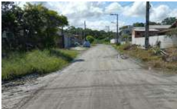
Rua Cidade de Guarulhos – ETE à Frente (Ponto 4A)
