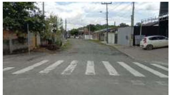
Figura 74 – Rua Dep. Aderbal Tavares Lopes – ETE à Frente (Ponto 17D)
