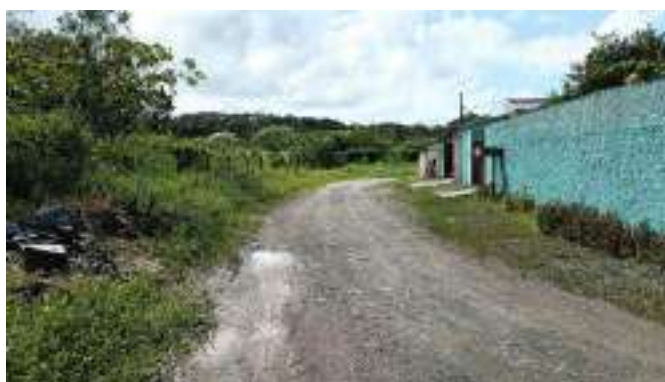
Figura 13 – Rua Sem Nome (Chega na Rua Maria Chaves da Silva) – ETE à Frente (Ponto 3C)
