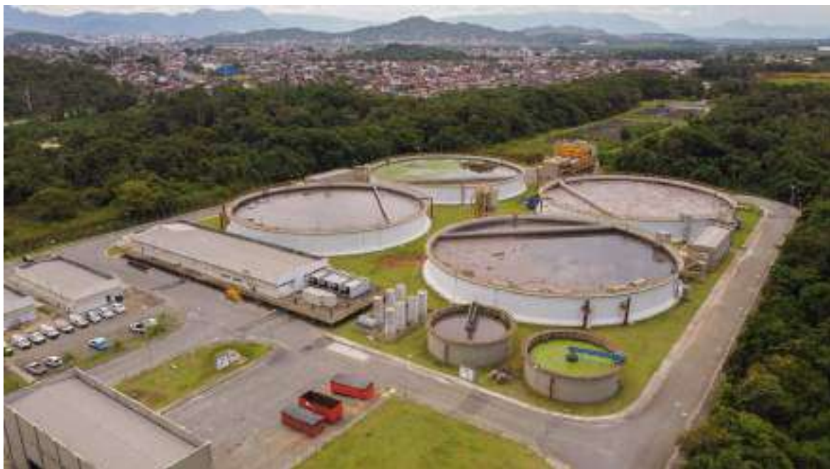
Figura 3 – Vista aérea da ETE Jarivatuba em operação
