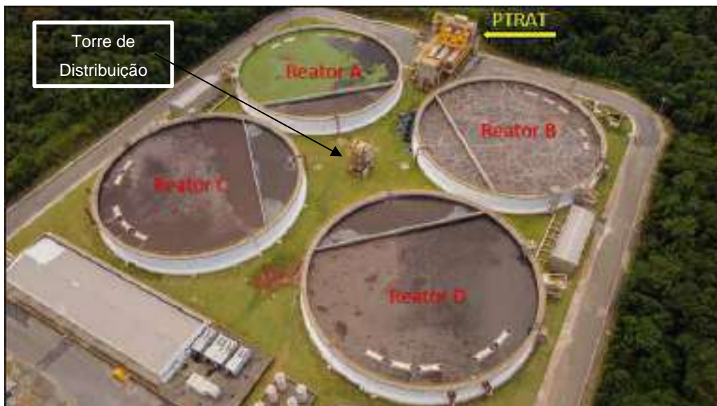
Figura 11 – Distribuição dos Reatores a partir da Torre de Distribuição localizada no centro
