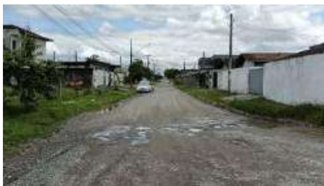
Figura 59 – Rua José Clara de Oliveira – ETE Atrás (Ponto 14A)
