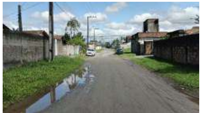
Figura 16 – Rua Cidade de Guarulhos – ETE Atrás (Ponto 4B)
