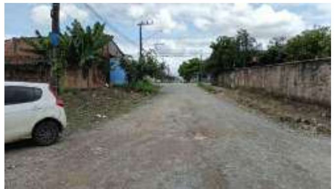
Figura 55 – Rua José Clara de Oliveira – ETE Atrás (Ponto 13B)
