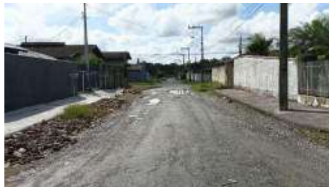
Figura 4 – Rua Cidade de Guarulhos – ETE Frente (Ponto 1B)
