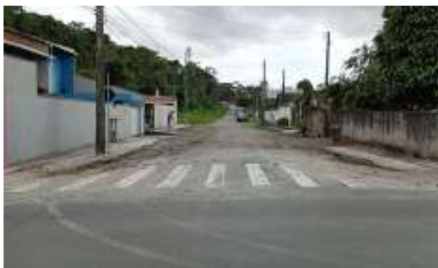
Rua Alfredo Stringari – ETE Atrás (Ponto 17C)
