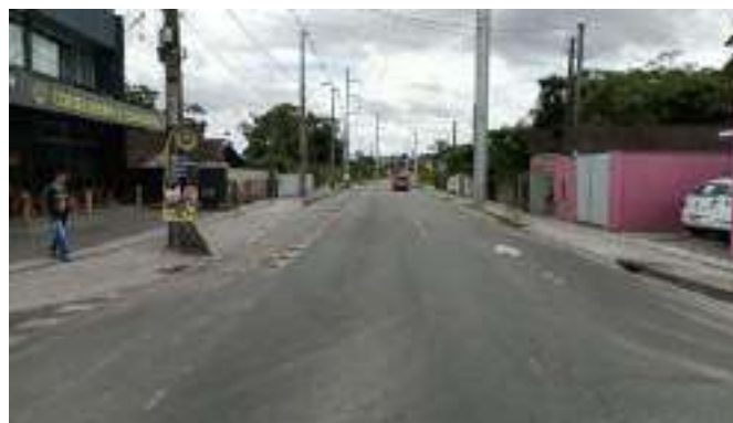
Figura 72 – Rua Eurides Francisco Tomasoni – ETE à esquerda (Ponto 17B)
