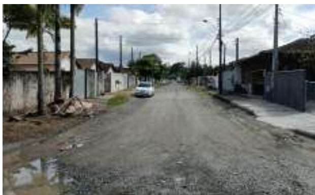
Rua Dep. Aderbal Tavares Lopes – ETE à direita (Ponto 1C)
