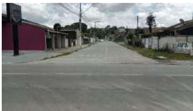
Figura 97 – Rua Min. Marcos Freire – ETE à direita (Ponto 23C)
