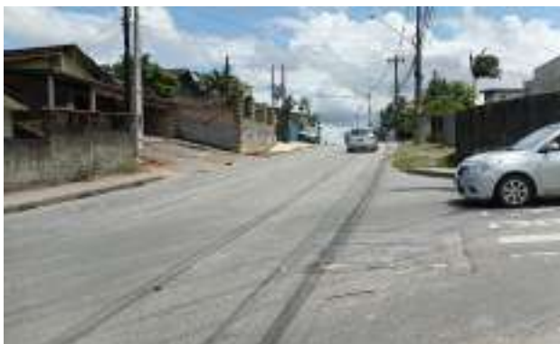
Rua Rio Velho – ETE Atrás (Ponto 21C)
