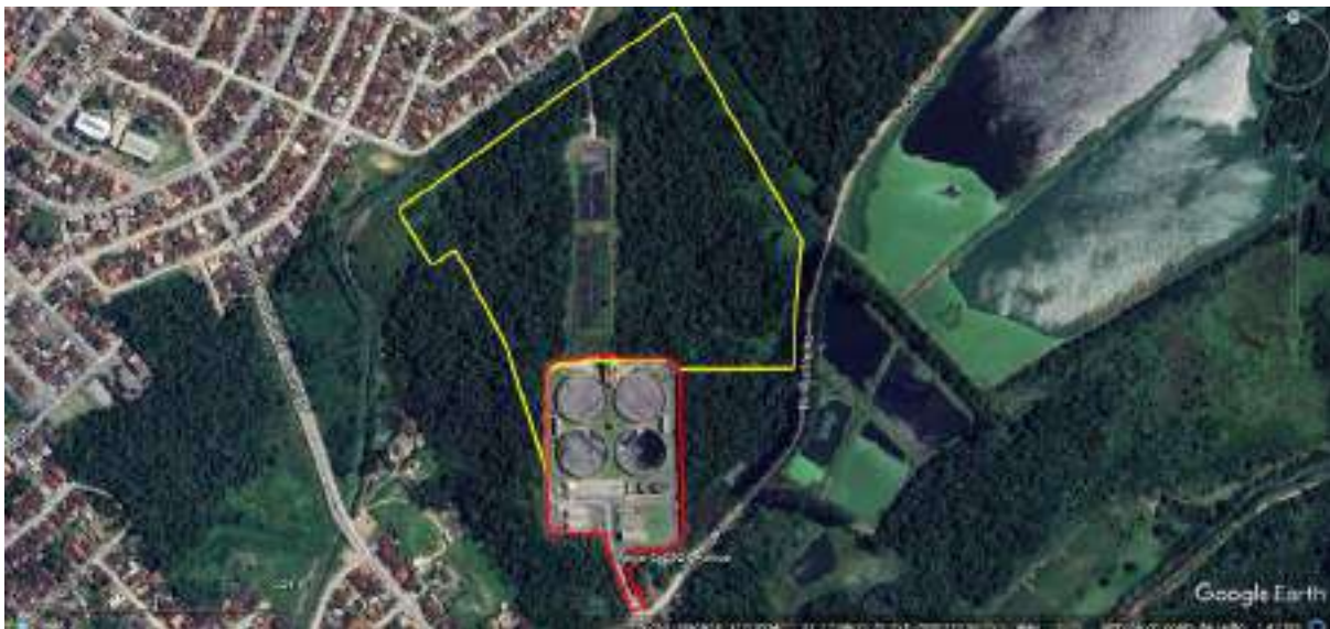
Figura 1 – Localização da área destinada à ampliação (linha amarela) e área da ETE Jarivatuba atual (linha vermelha)
