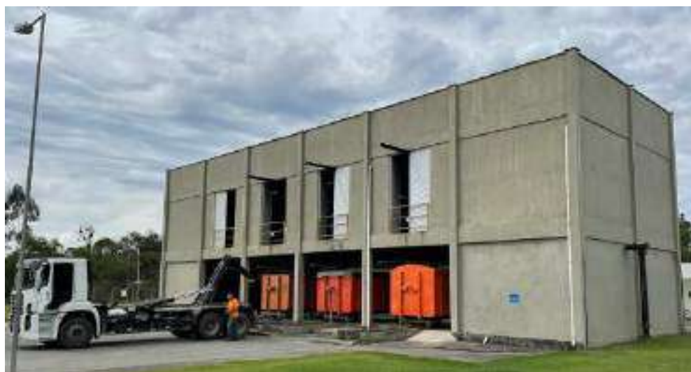
Figura 39 – ETL vista externa. Caminhão disposto para operação de retirada de uma das caçambas de lodo e transporte ao aterro sanitário.
