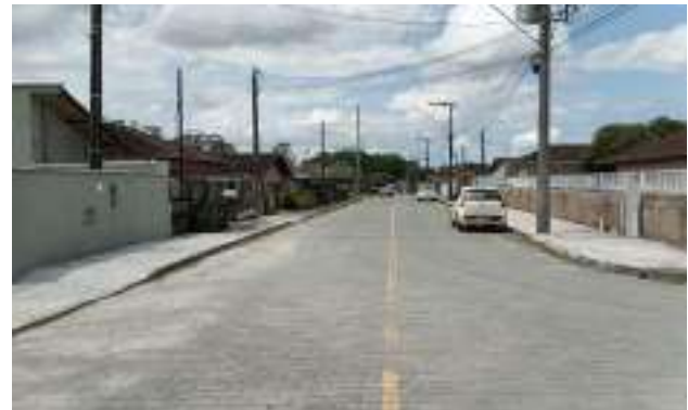
Rua Min. Marcos Freire – ETE à esquerda (Ponto 22B)
