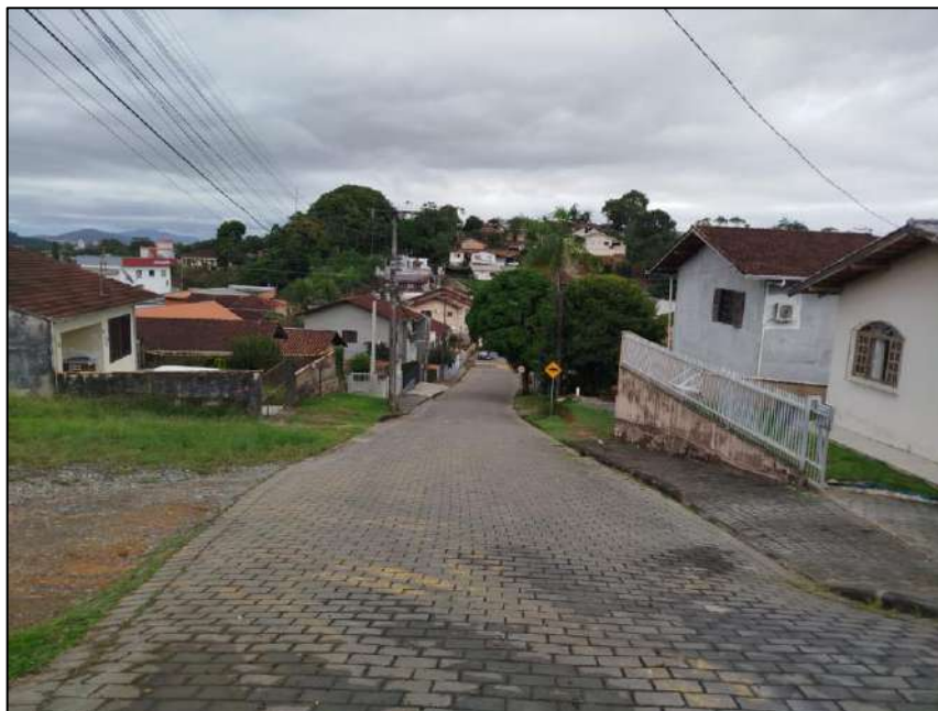
Rua Olindo J. Dias, com alguns trechos sem calçada.
