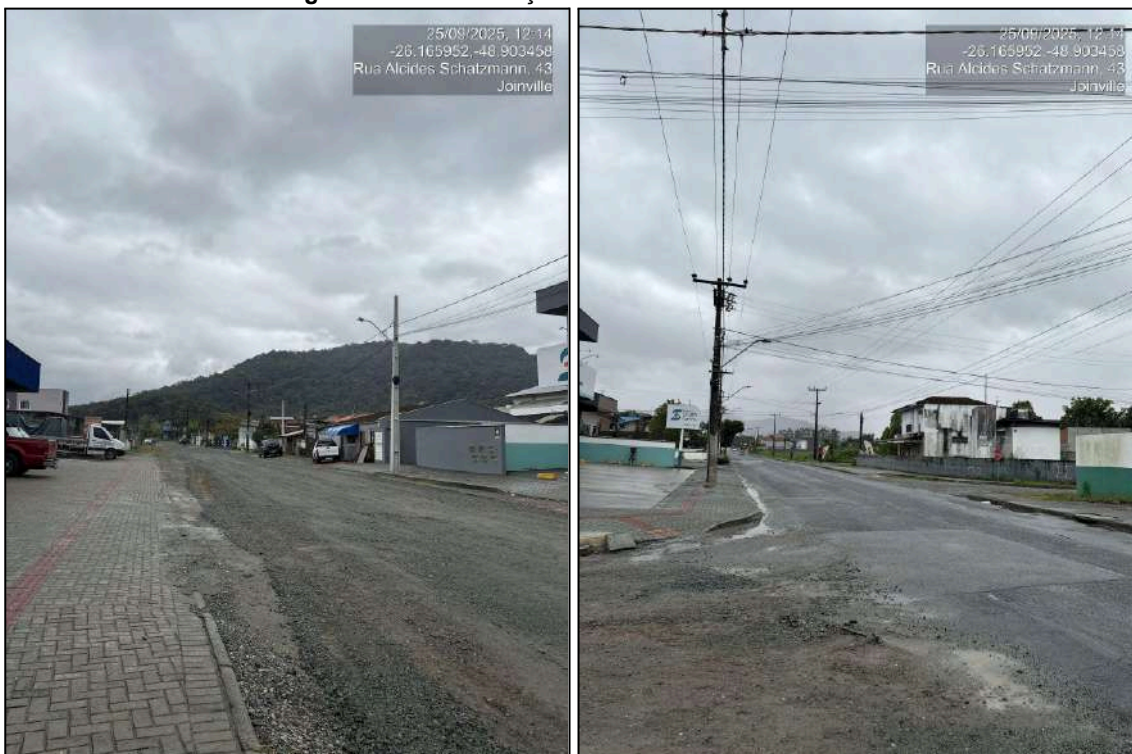
Figura 10 - Pavimentação da rua Alcides Schatzmann
