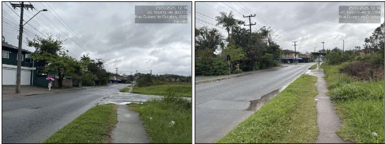
Figura 12 - Pavimentação da calçada da Rua Quinze de Outubro, em frente ao empreendimento
