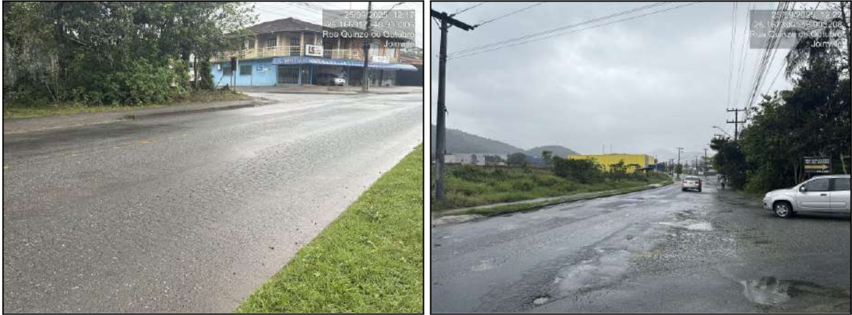
Figura 11 - Pavimentação da rua Quinze de Outubro
