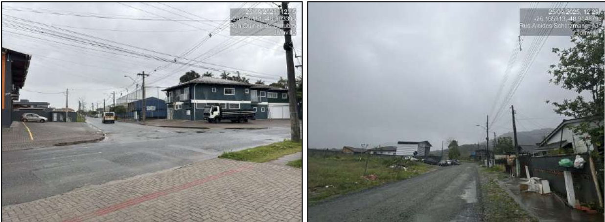
Figura 29 - Estado de conservação das calçadas vizinhas
