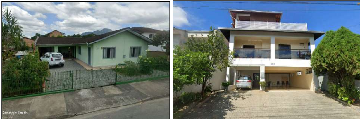
Figura 8 - Residências unifamiliares localizadas na área de influência do empreendimento
