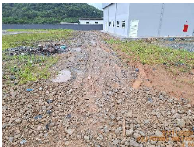
Figura 1.52: Local de implantação da estrutura E26, Rua dos Suíços, área interna do imóvel.
