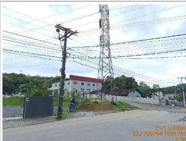
Figura 1: Início da LD a partir da LI 138kV Tigre – Joinville, início do pavimento apresenta boas condições.
