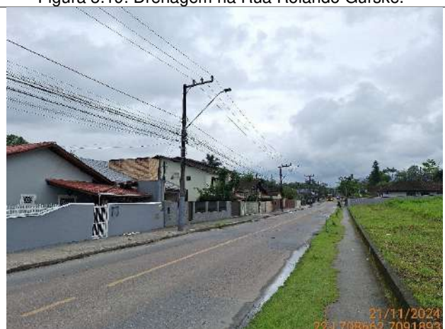
Figura 3.21: Pequeno acúmulo de água na Rua dos Suíços.
