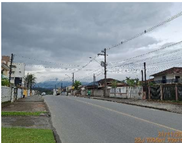
Figura 4.5: Vista da Rua Rolando Gurske, via e calçadas mais amplas.
