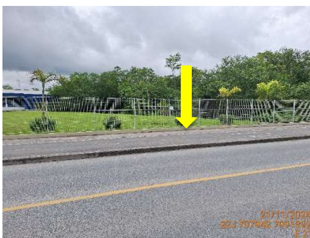
Figura 1.41: Local de implantação da estrutura E21, Rua dos Suíços.
