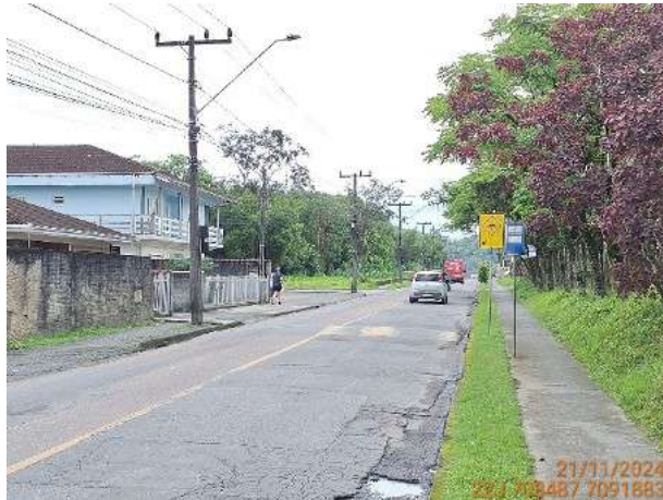
Figura 9: Vista da Rua dos Suíços, presença de placas de trânsito.
