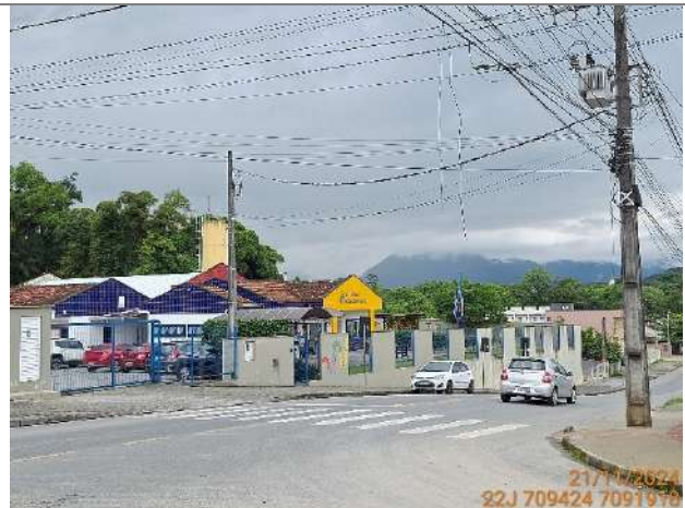
Figura 3.2: Vias presentes na ADA com cabeamento e postes implantados.
