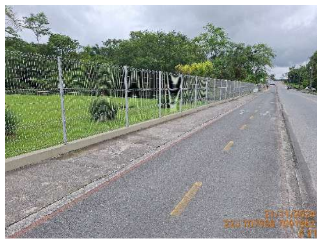
Figura 1.42: Local de implantação da estrutura E21, Rua dos Suíços.
