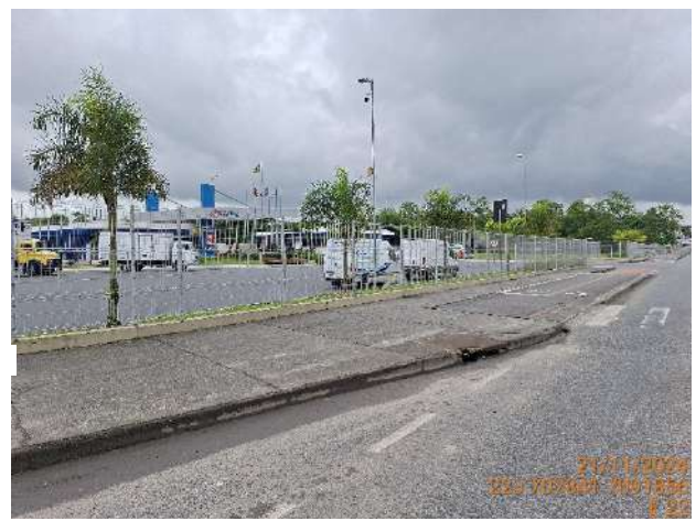
Figura 1.45: Local de implantação da estrutura E22, Rua dos Suíços.
