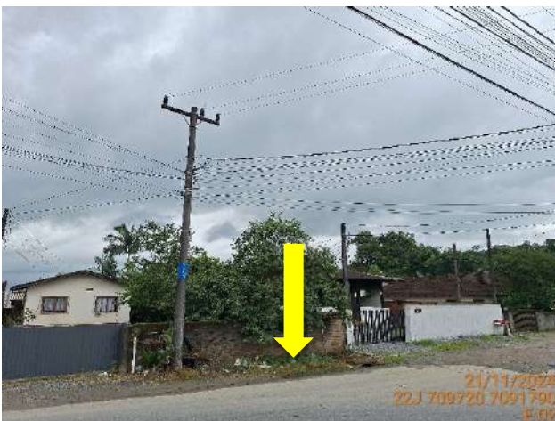
Figura 1.3: Local de implantação da estrutura E02, Rua Sebastião Jonck.
