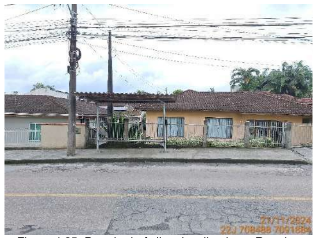
Figura 4.25: Parada de ônibus localizada na Rua dos Suíços.
