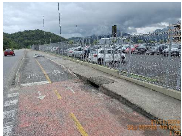
Figura 1.47 Local de implantação da estrutura E23, Rua dos Suíços.
