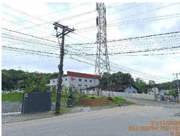
Figura 3.6: Início da LD a partir da LI 138kV Tigre – Joinville, início do pavimento apresenta boas condições.
