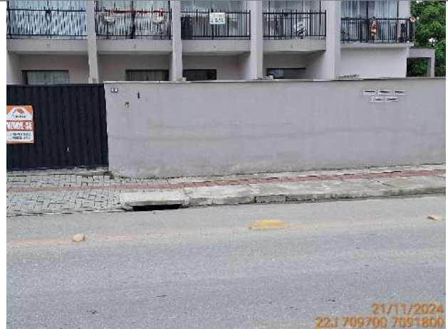
Figura 3.17: Drenagem na Rua Maria de Lourdes Bachtold.
