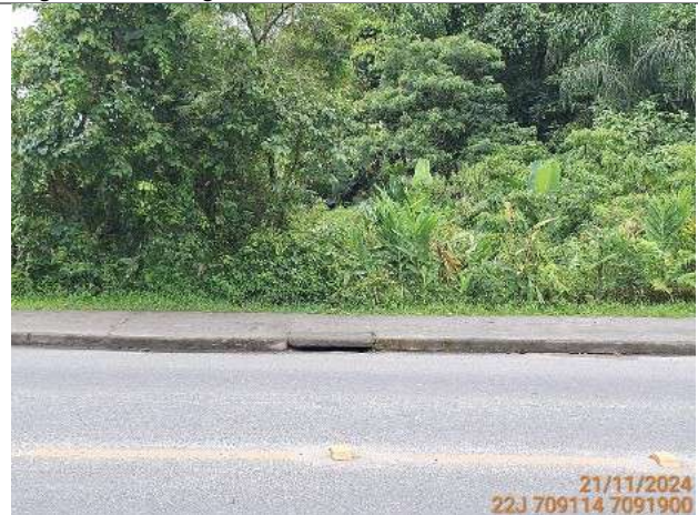
Figura 4: Drenagem na Rua Rolando Gurske.
