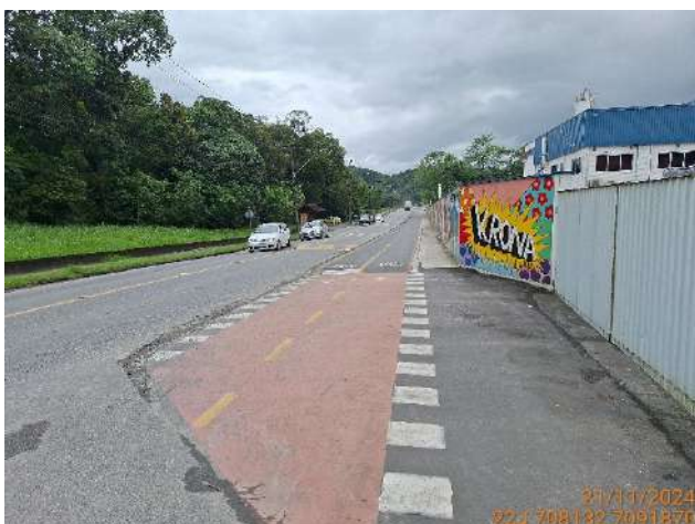
Figura 4.19: Início da via compartilhada, com sinalização no chão, na Rua dos Suíços.
