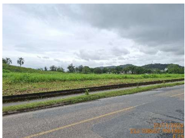
Figura 1.30: Local de implantação da estrutura E15, Rua dos Suíços.
