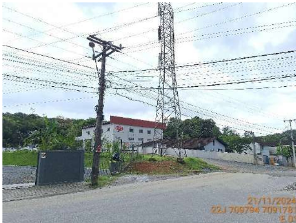
Figura 4.1: Início da LD a partir da LI 138kV Tigre – Joinville, início do pavimento.
