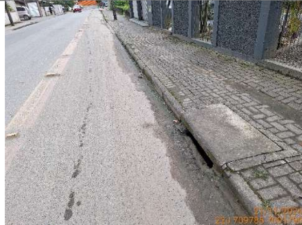
Figura 3.16: Drenagem na Rua Sebastião Jonck.
