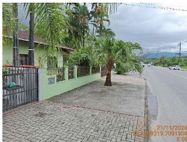
Figura 1.18: Local de implantação da estrutura E09, Rua Rolando Gurske.
