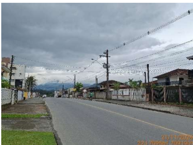
Figura 3.10: Vista da Rua Rolando Gurske, pavimento apresenta boas condições.
