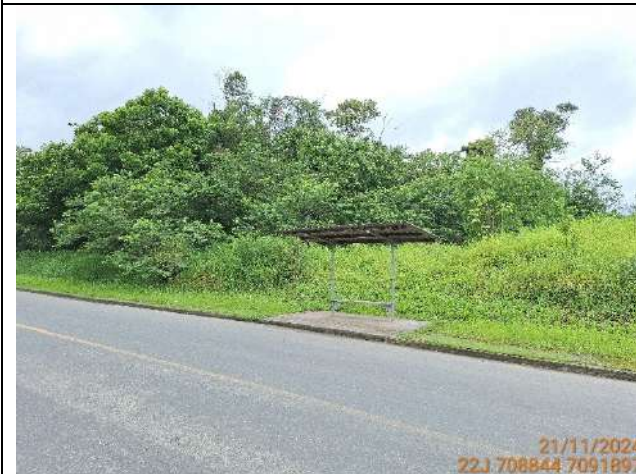
Figura 4: Parada de ônibus localizada na Rua Rolando Gurske.
