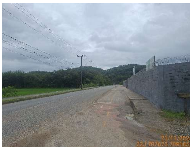
Figura 3.15: Vista da via nas proximidades do imóvel onde a SE será implantada, pavimento apresenta boas condições.
