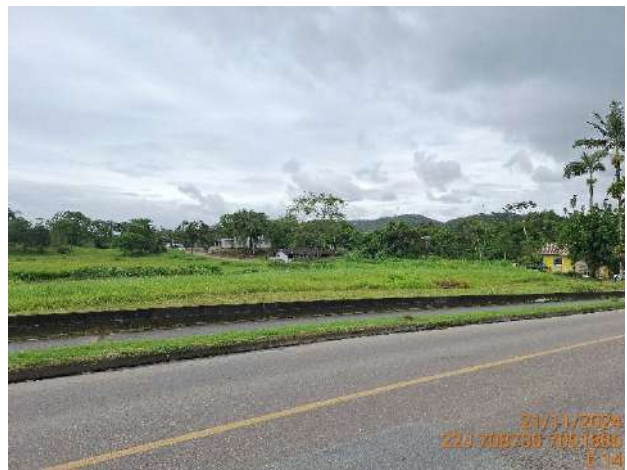
Figura 1.28: Local de implantação da estrutura E14, Rua dos Suíços.
