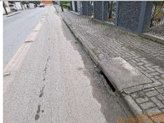
Figura 1: Drenagem na Rua Sebastião Jonck.
