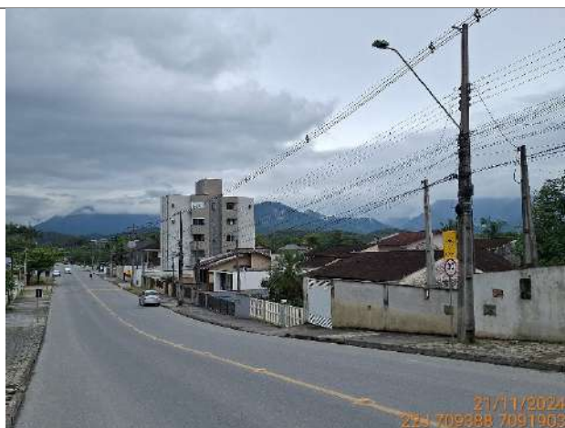
Figura 3.26: Vista da Rua Rolando Gurske, evidência de iluminação pública.
