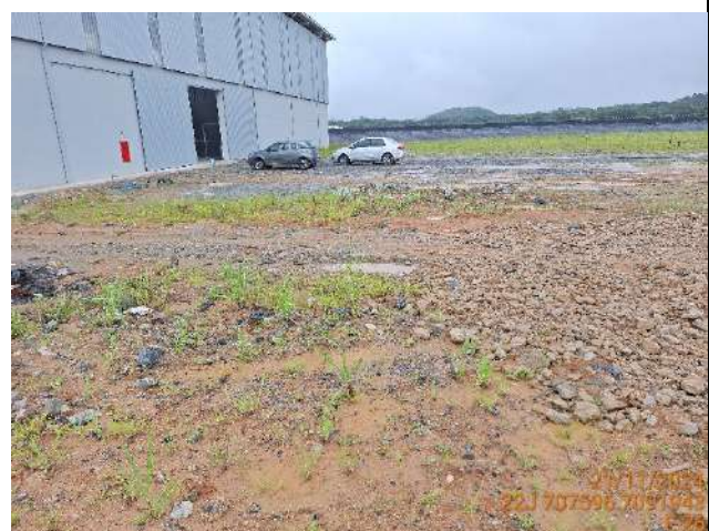
Figura 1.53: Local de implantação da estrutura E26, Rua dos Suíços.
