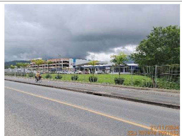
Figura 8: Vista da Rua dos Suíços, pavimento apresenta boas condições.
