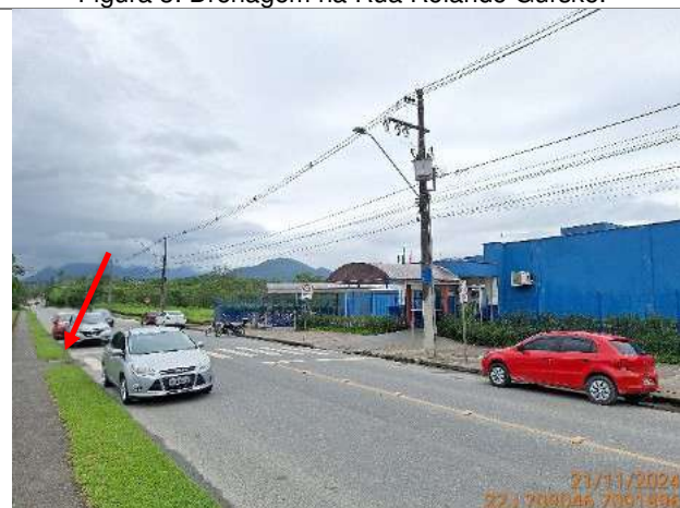
Figura 5: Drenagem na Rua Rolando Gurske.
