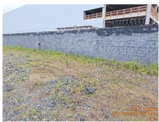
Figura 1.51: Local de implantação da estrutura E25, Rua dos Suíços.
