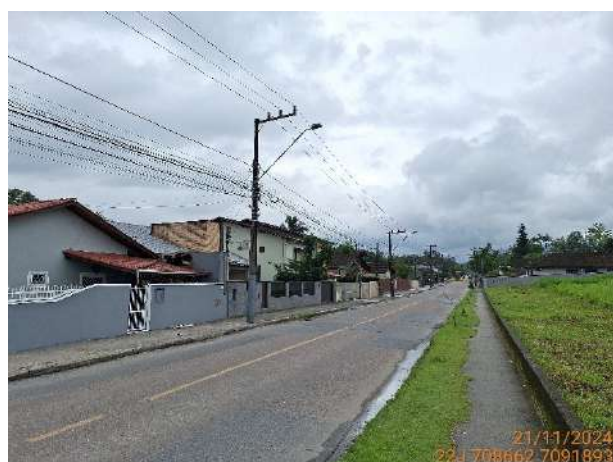
Figura 3.12: Vista da Rua dos Suíços, pavimento apresenta boas condições, porém com acúmulo de água.
