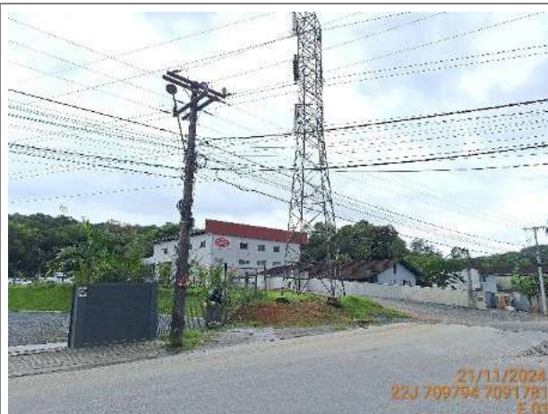
Figura 1: Início da LD a partir da LI 138kV Tigre – Joinville, início do pavimento.
