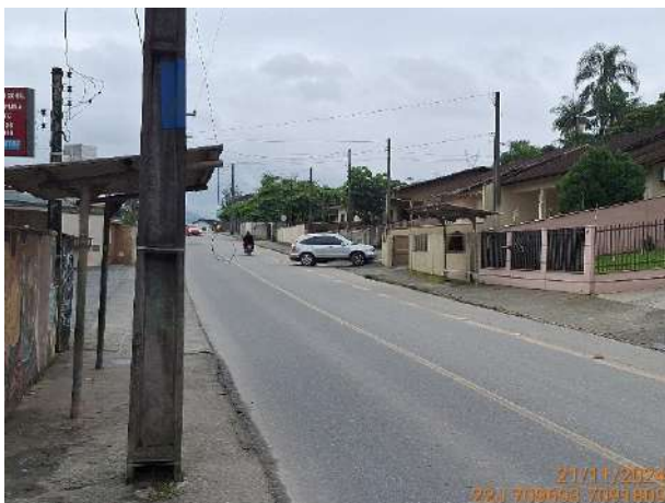
Figura 3.8: Vista da Rua Maria de Lourdes Bachtold, área residencial, pavimento apresenta boas condições.
