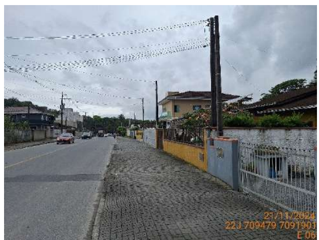
Figura 1.12: Local de implantação da estrutura E06, Rua Rolando Gurske,
