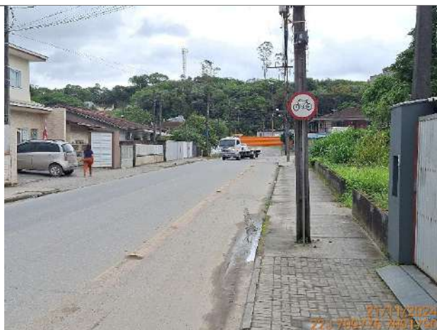
Figura 3.24: Vista da Rua Sebastião Jonck com a presença de iluminação pública.
