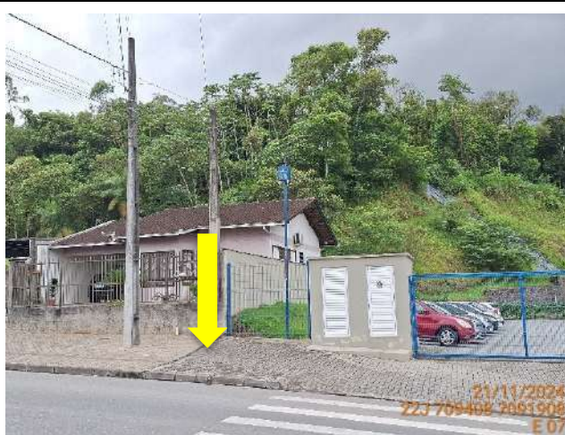
Figura 1.13: Local de implantação da estrutura E07, Rua Rolando Gurske.
