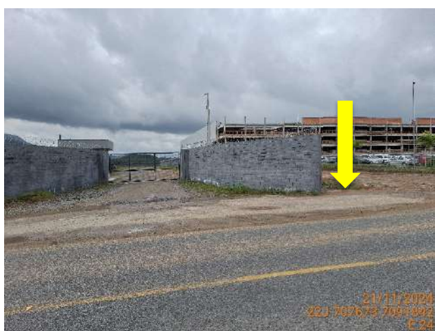
Figura 1.48: Local de implantação da estrutura E24, Rua dos Suíços.
