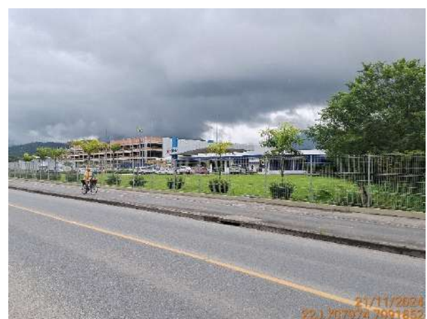
Figura 3.13: Vista da Rua dos Suíços, pavimento apresenta boas condições.
