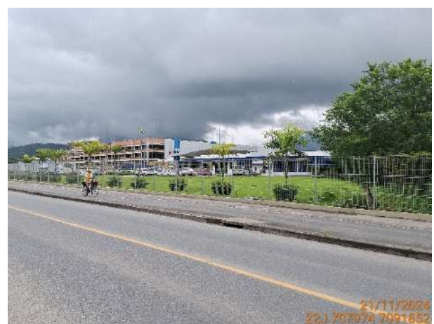
Figura 4.8: Vista da Rua dos Suíços, pavimento apresenta boas condições.
