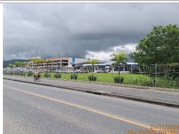
Figura 7: Drenagem na Rua dos Suíços.
