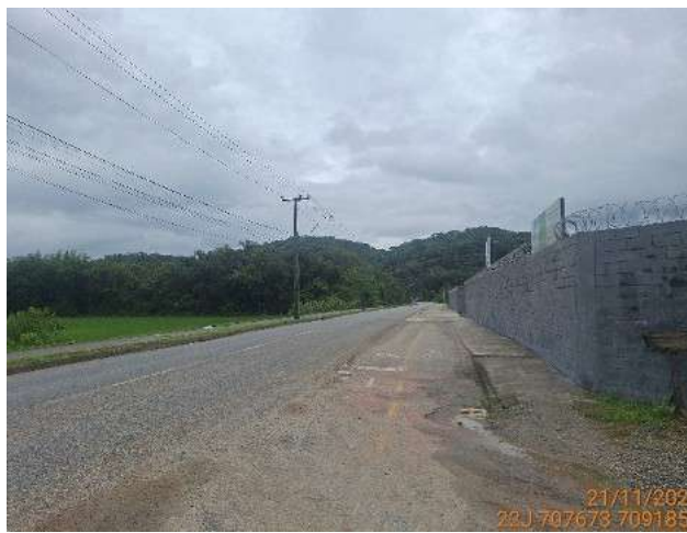
Figura 10: Vista da via nas proximidades do imóvel onde a SE será implantada, pavimento apresenta boas condições.
