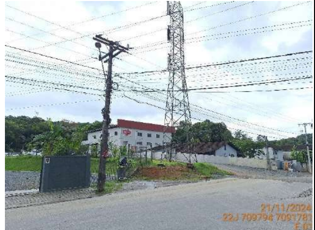
Figura 1.2: Local de implantação da estrutura E01, Rua Sebastião Jonck.
