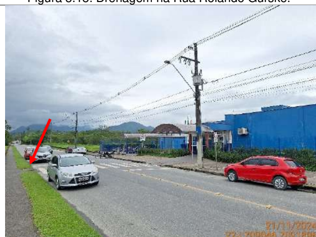
Figura 3.20: Drenagem na Rua Rolando Gurske.
