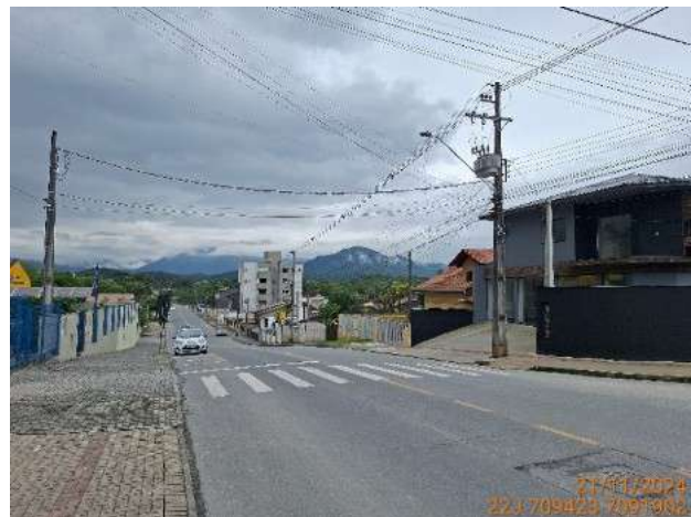
Figura 6: Vista da Rua Rolando Gurske, proximidade com instituição de ensino, apresenta recorte no pavimento.
