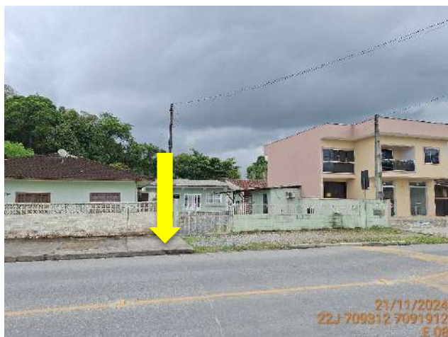
Figura 1.15: Local de implantação da estrutura E08, Rua Rolando Gurske.
