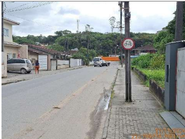
Figura 3.1: Vias presentes na ADA com cabeamento e postes implantados.
