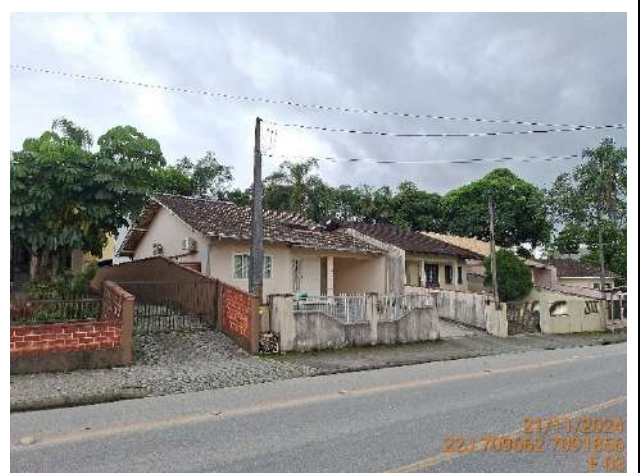
Figura 1.6: Local de implantação da estrutura E03, Rua Maria de Lourdes Bachtold.
