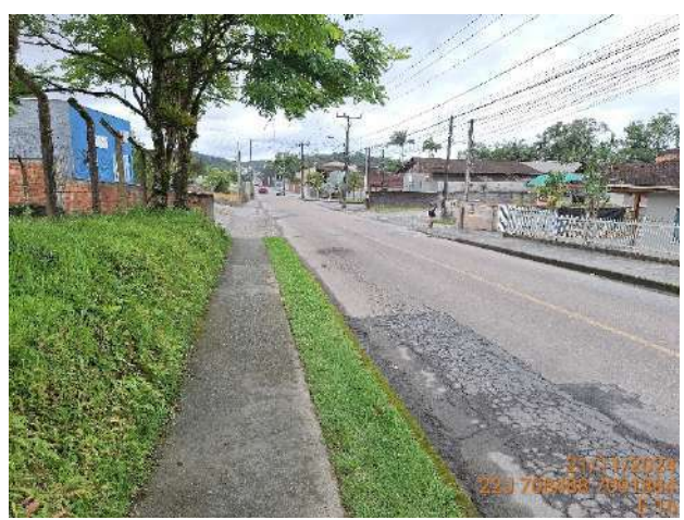
Figura 1.32: Local de implantação da estrutura E16, Rua dos Suíços.
