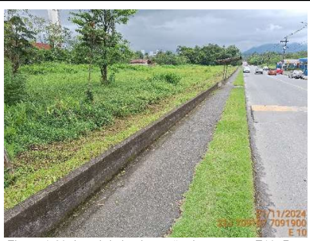
Figura 1.20: Local de implantação da estrutura E10, Rua Rolando Gurske.
