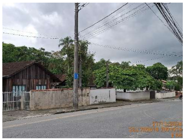
Figura 1.8: Local de implantação da estrutura E04, Rua Maria de Lourdes Bachtold.
