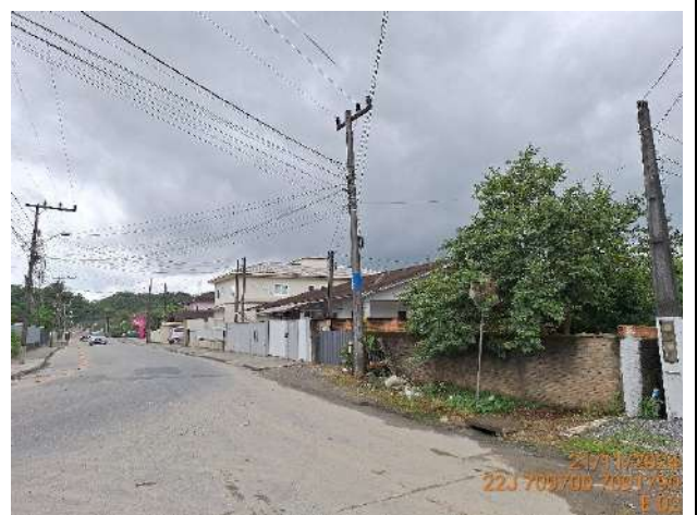
Figura 1.4: Local de implantação da estrutura E02, Rua Sebastião Jonck.
