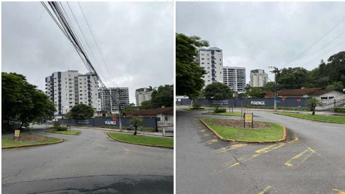
Figura 18 - Vista das Sinalizações do Trevo das Ruas Desembargador Nelson Nunes Guimarães e Oscar Antônio Schneider
