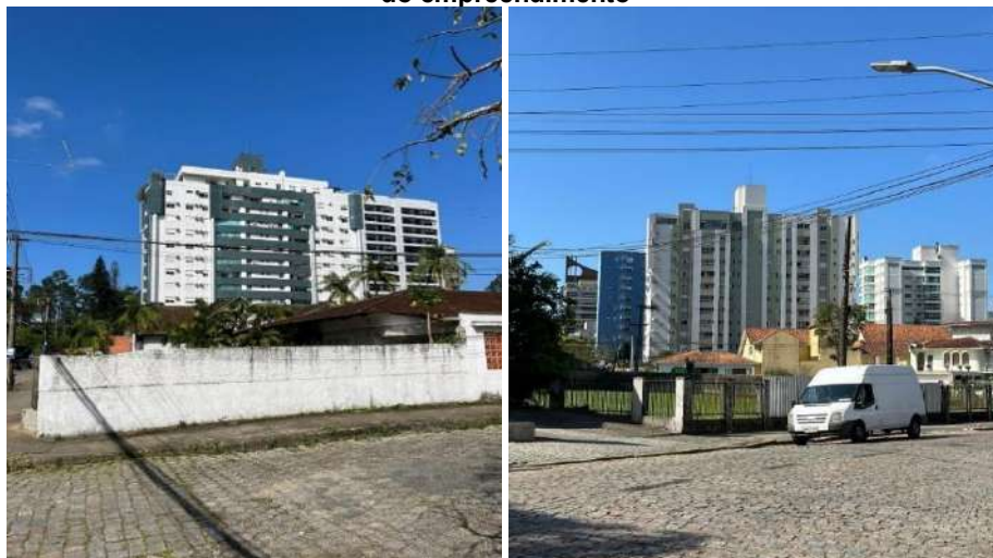
Figura 6 – Condomínios residenciais multifamiliares localizadas no entorno do imóvel e na área de influência do empreendimento
