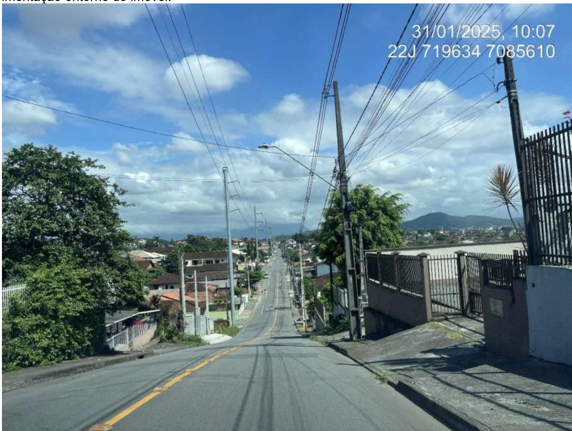
Pavimentação entorno do imóvel.
