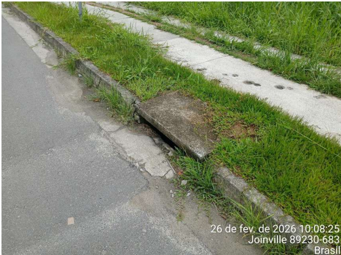
Figura 32: Boca de lobo, em frente ao local de estudo.
