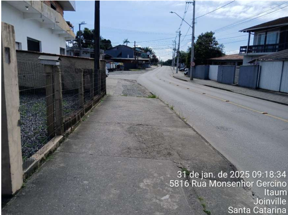
Pavimentação entorno do imóvel.
