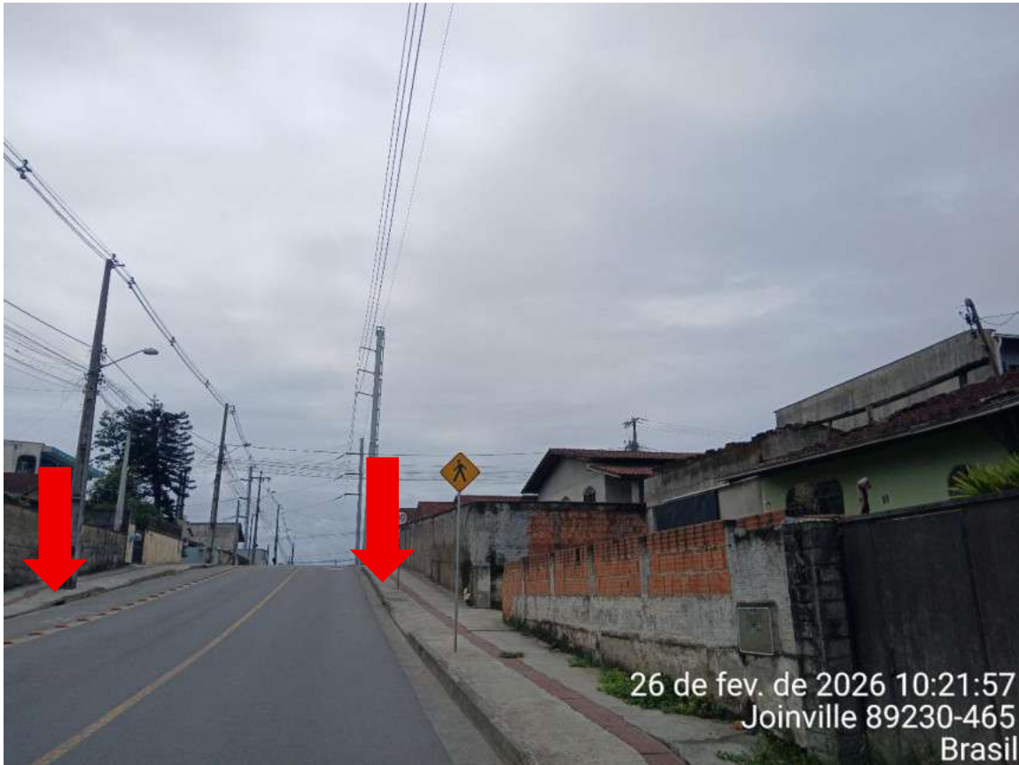
Figura 36: Bocas de lobo, Rua Eurides Francisco Tomasoni. Vista sentido sul.
