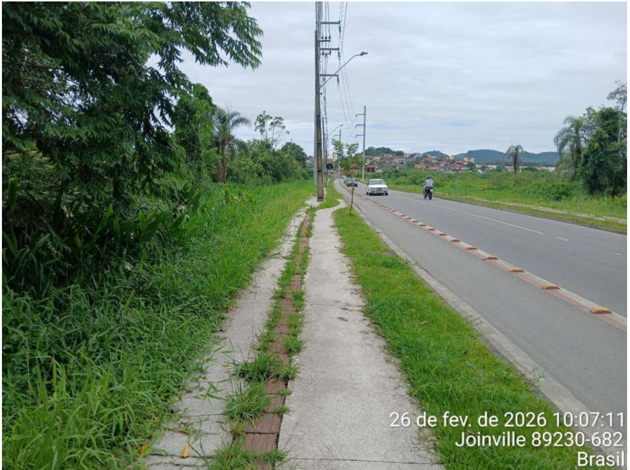
Figura 44: Calçada em frente ao imóvel em estudo.
