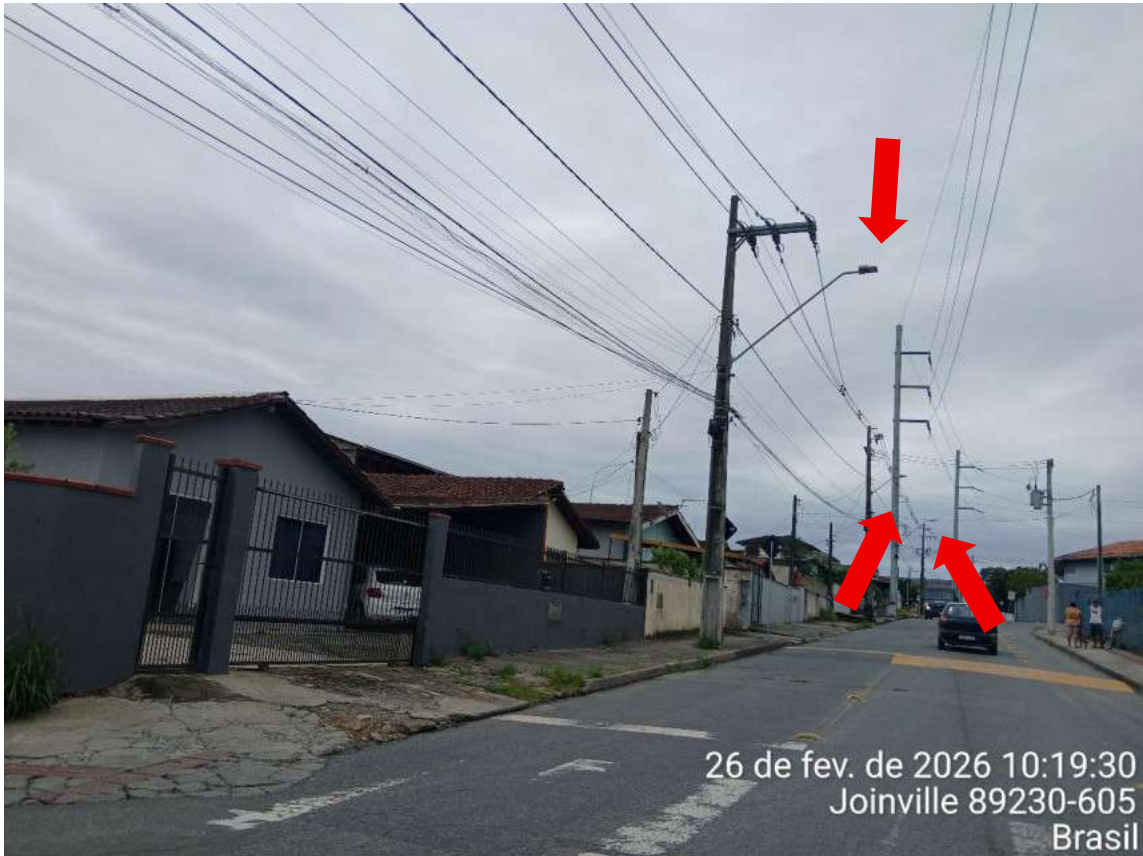
Figura 40: Iluminação Pública, Rua Max Pruner. Vista sentido Sul.
