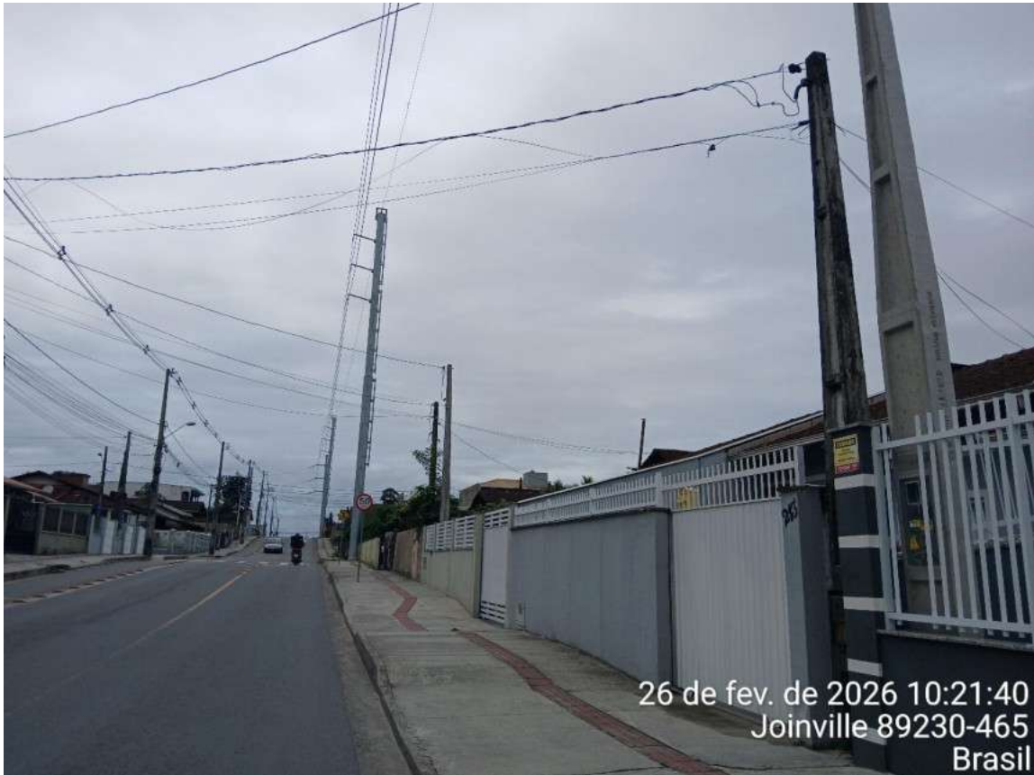
Figura 70: Aspecto da calçada, entorno do imóvel.
