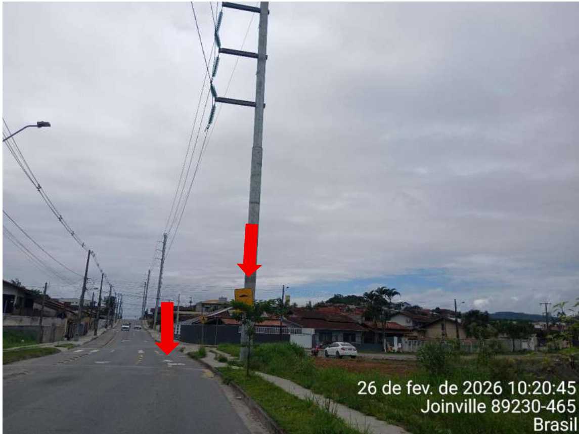
Figura 59: Rua Eurides Francisco Tomasoni, próximo ao imóvel. Vista sentido sul.
