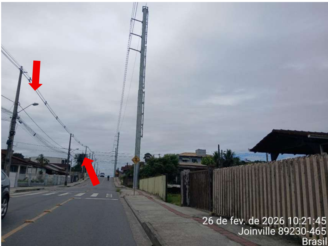
Figura 41: Iluminação Pública, Rua Eurides Francisco Tomasoni. Vista sentido sul.
