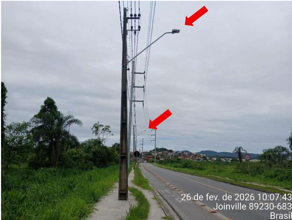
Figura 38: Iluminação Pública, em frente ao imóvel, Rua Eurides Francisco Tomasoni. Vista sentido sul.
