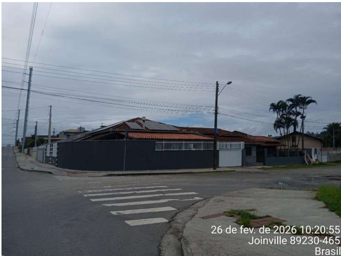
Figura 69: Aspecto da calçada, entorno do imóvel.
