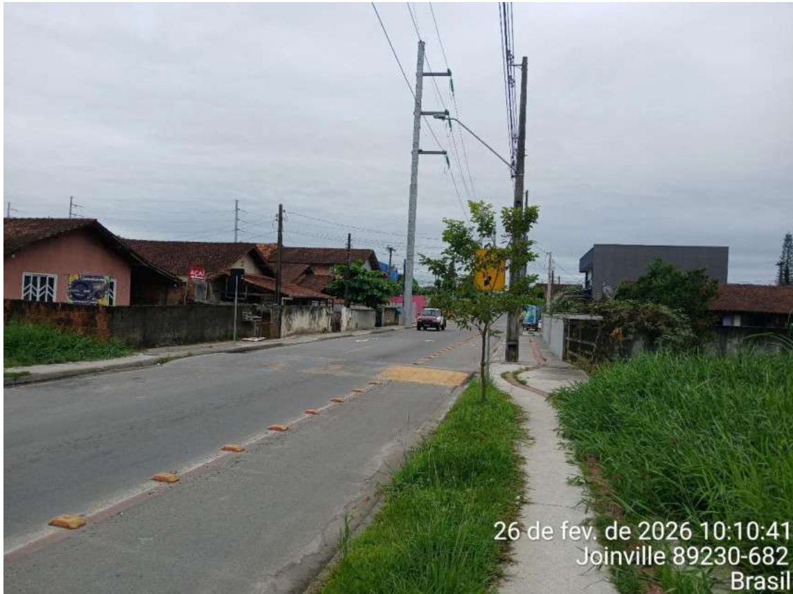
Figura 68: Aspecto da calçada, em frente ao imóvel e entorno.
