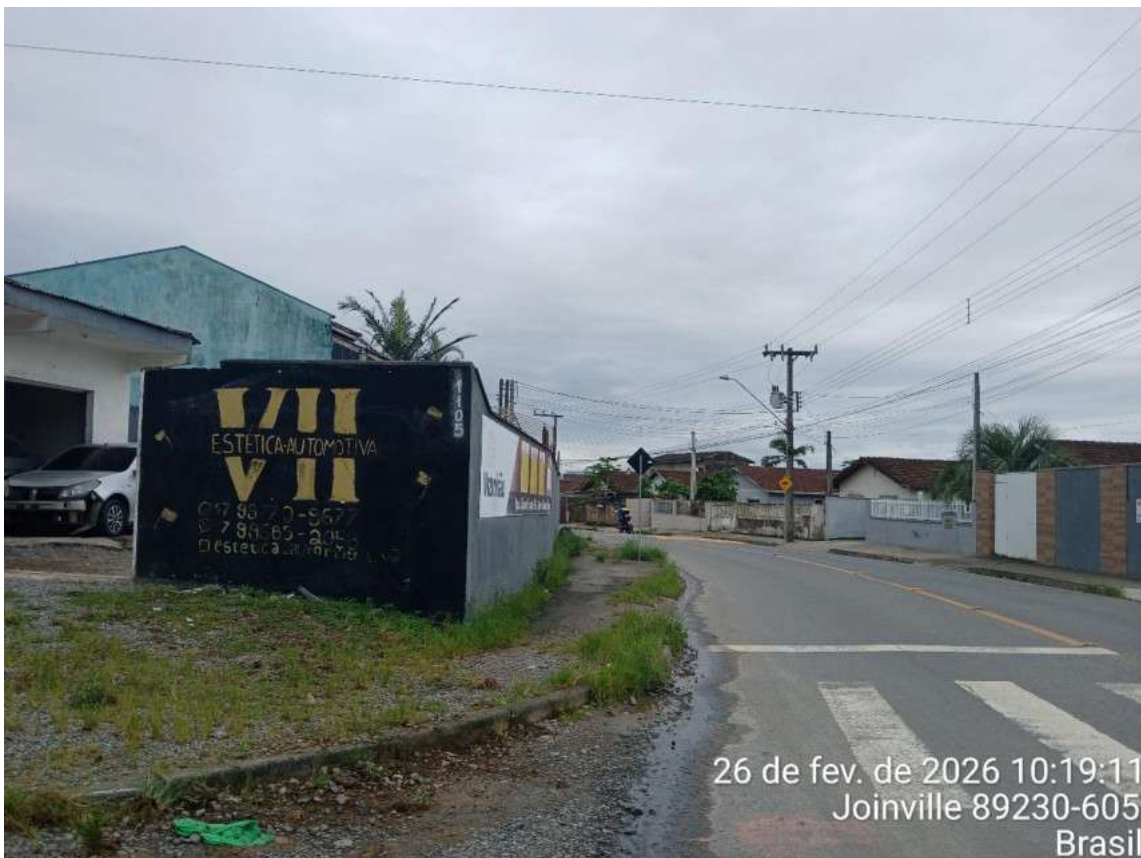
Figura 29: Aspecto da calçada, entorno do imóvel.
