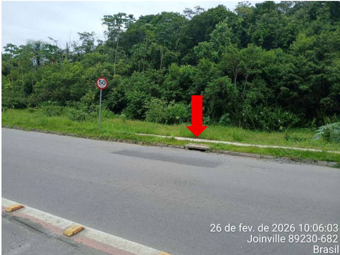
Figura 31: Boca de lobo, em frente ao local de estudo.
