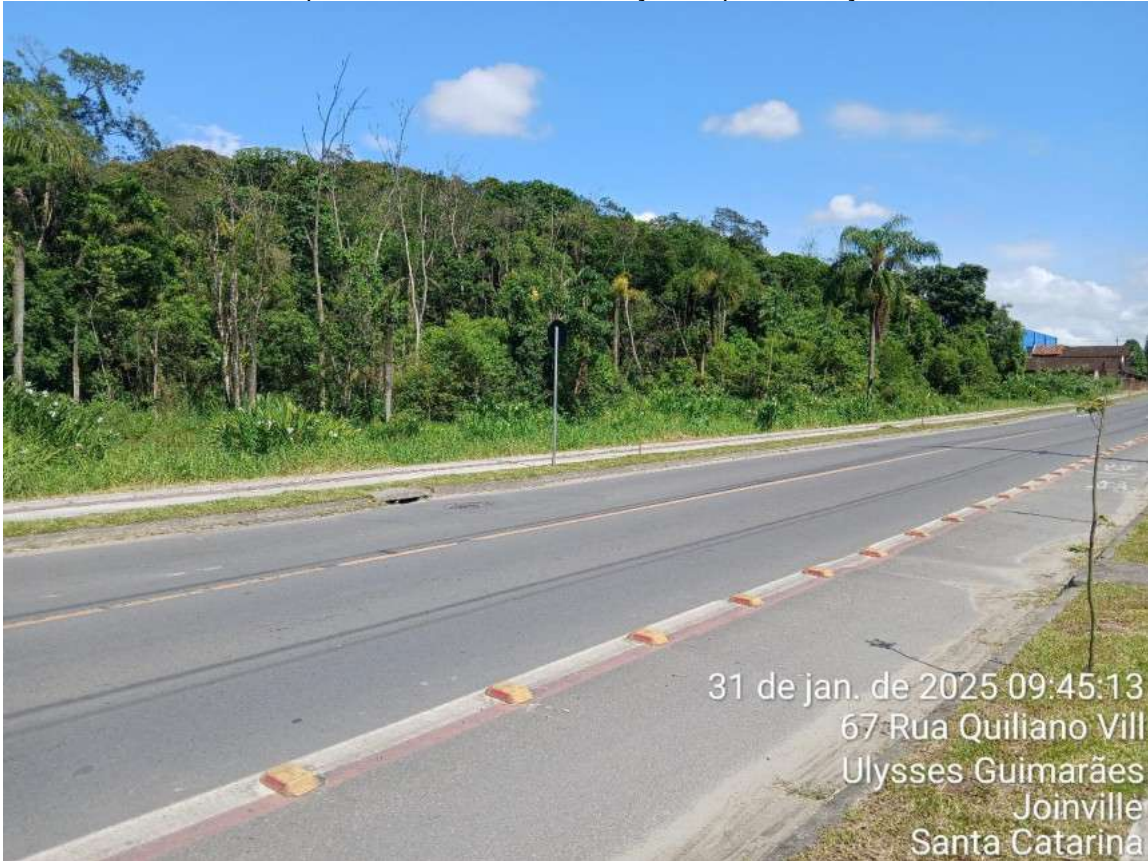
Pavimentação em frente ao imóvel.
