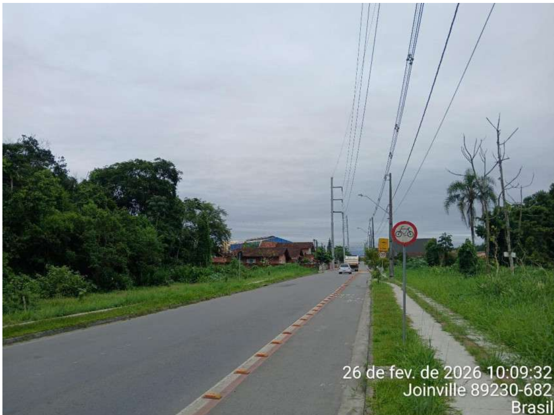
Figura 66: Ciclofaixa na Rua Eurides Francisco Tomasoni, em frente ao imóvel. Vista sentido norte.
