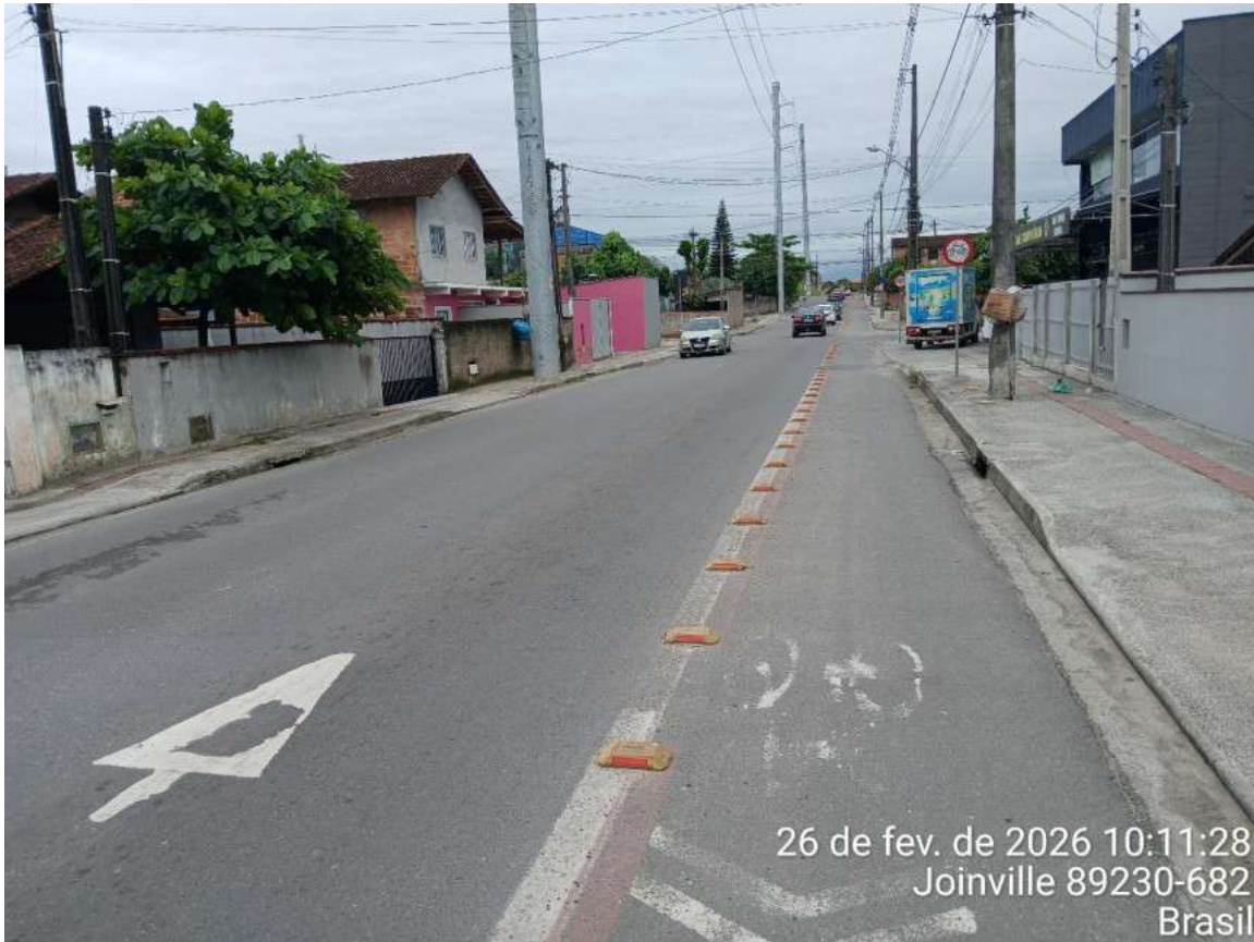
Figura 24: Aspecto da calçada na Rua Eurides Francisco Tomasoni, entorno do imóvel.
