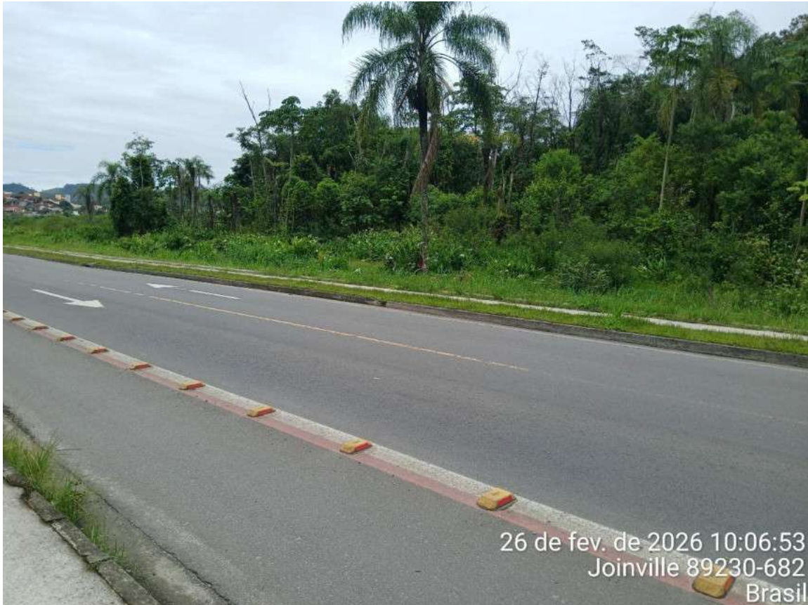
Figura 8: Rua Eurides Francisco Tomasoni, em frente ao imóvel. Vista sentido sul.
