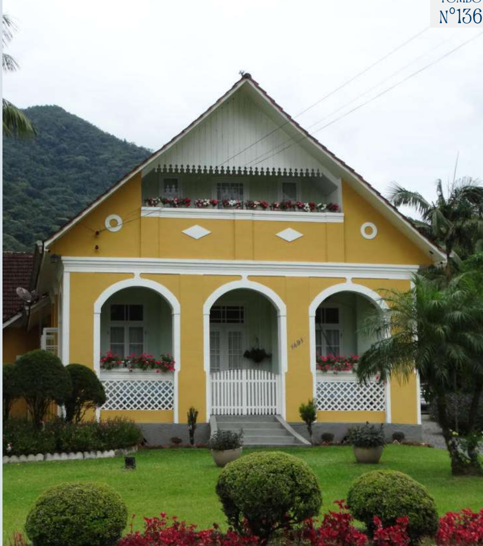
Figura 264: Fotografia da edificação CPC\SECULT, 2024
