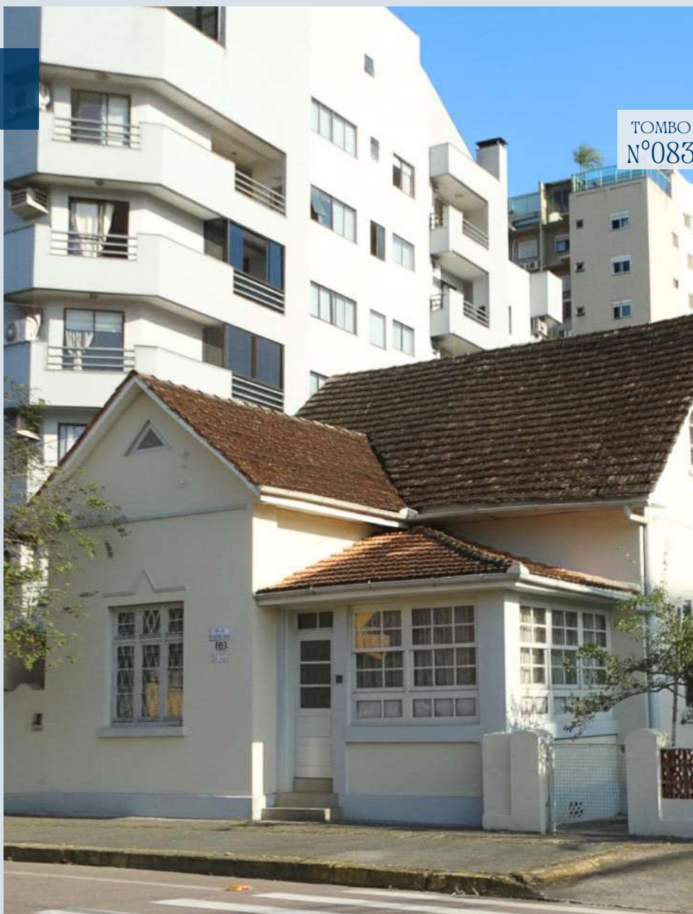
Figura 158: Fotografia da edificação CPC\SECULT, 2024
