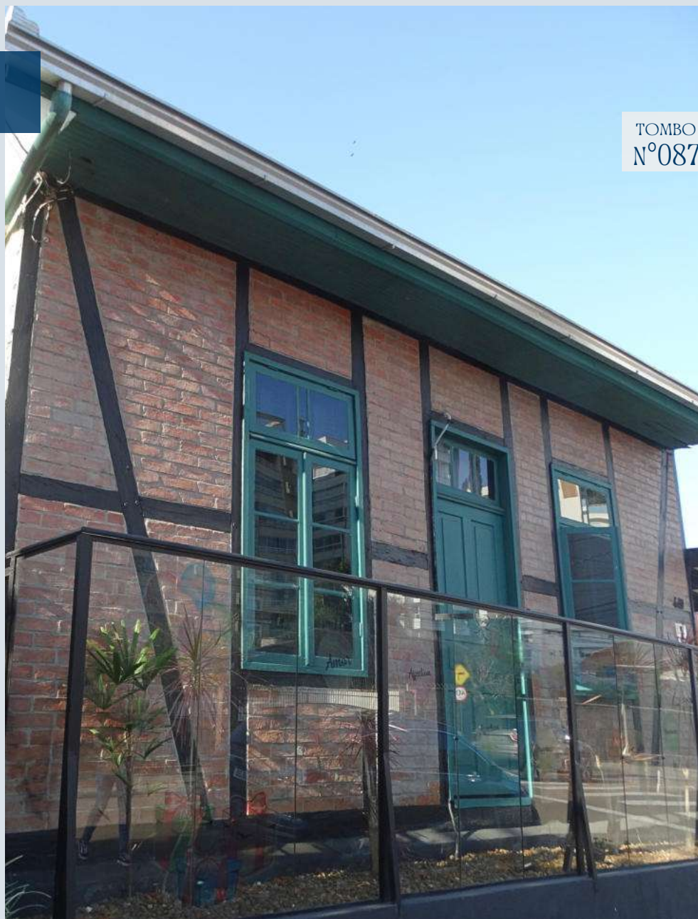
Figura 166: Fotografia da edificação CPC\SECULT, 2025
