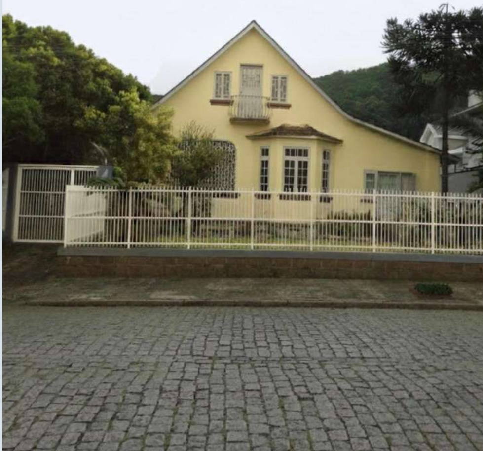
Figura 216: Fotografia da edificação CPC\SECULT, 2024
