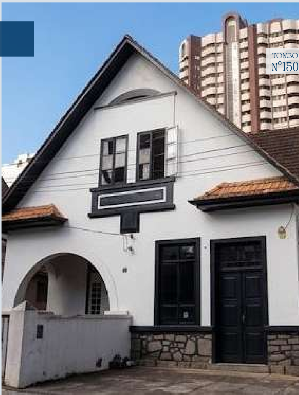
Figura 290: Fotografia da edificação CPC\SECULT, 2025. Atualmente se encontra desocupada e descaracterizada
