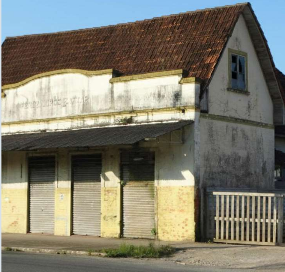
Figura 188: Fotografia da edificação CPC\SECULT, 2024
