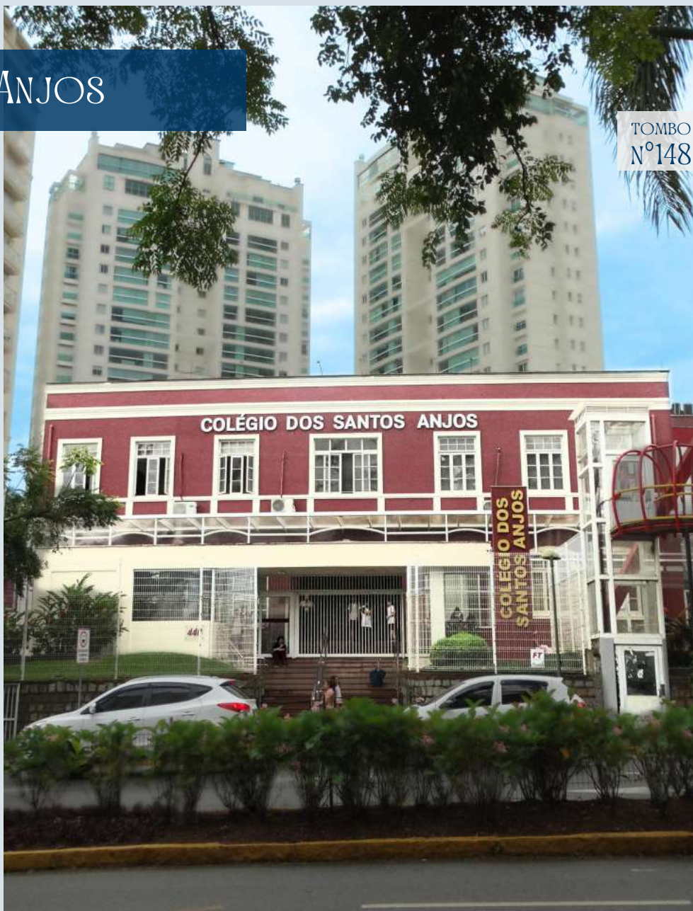
Figura 286: Fotografia da edificação CPC\SECULT, 2024
