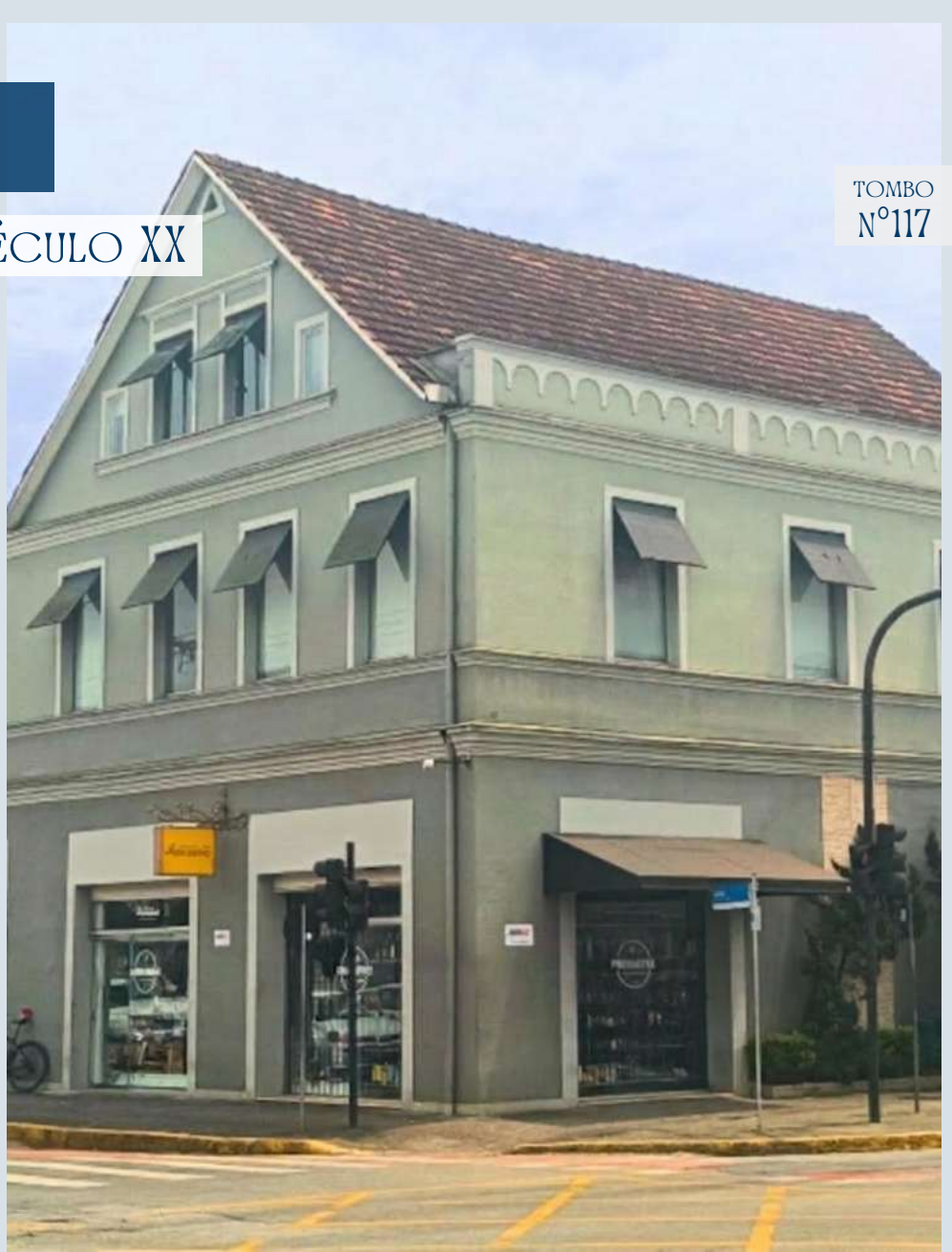
Figura 226: Fotografia da edificação CPC\SECULT, 2025
