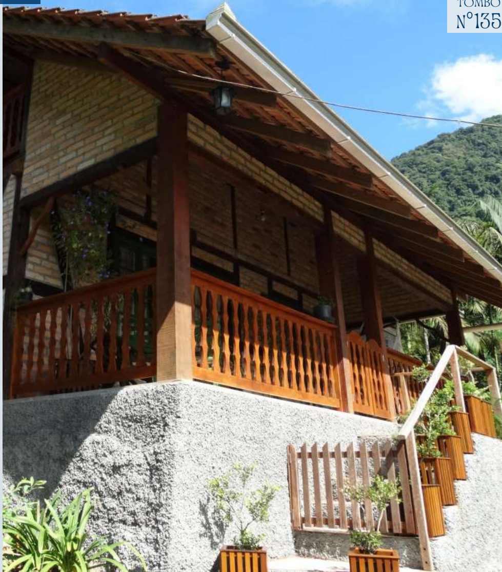
Figura 262: Fotografia da edificação CPC\SECULT, 2023
