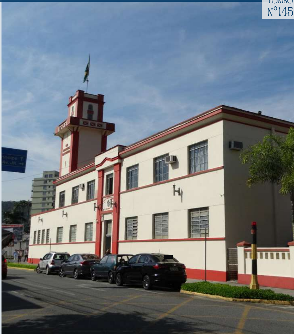
Figura 282: Fotografia da edificação CPC\SECULT, 2025
