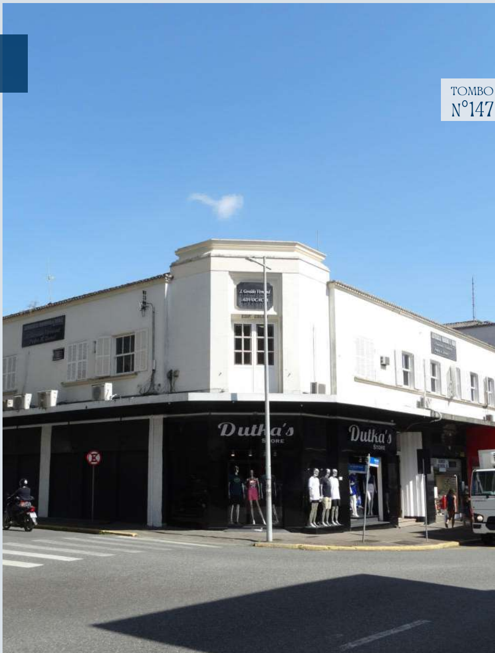
Figura 284: Fotografia da edificação CPC\SECULT, 2024
