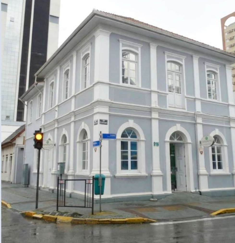
Figura 224: Fotografia da edificação CPC\SECULT, 2024
