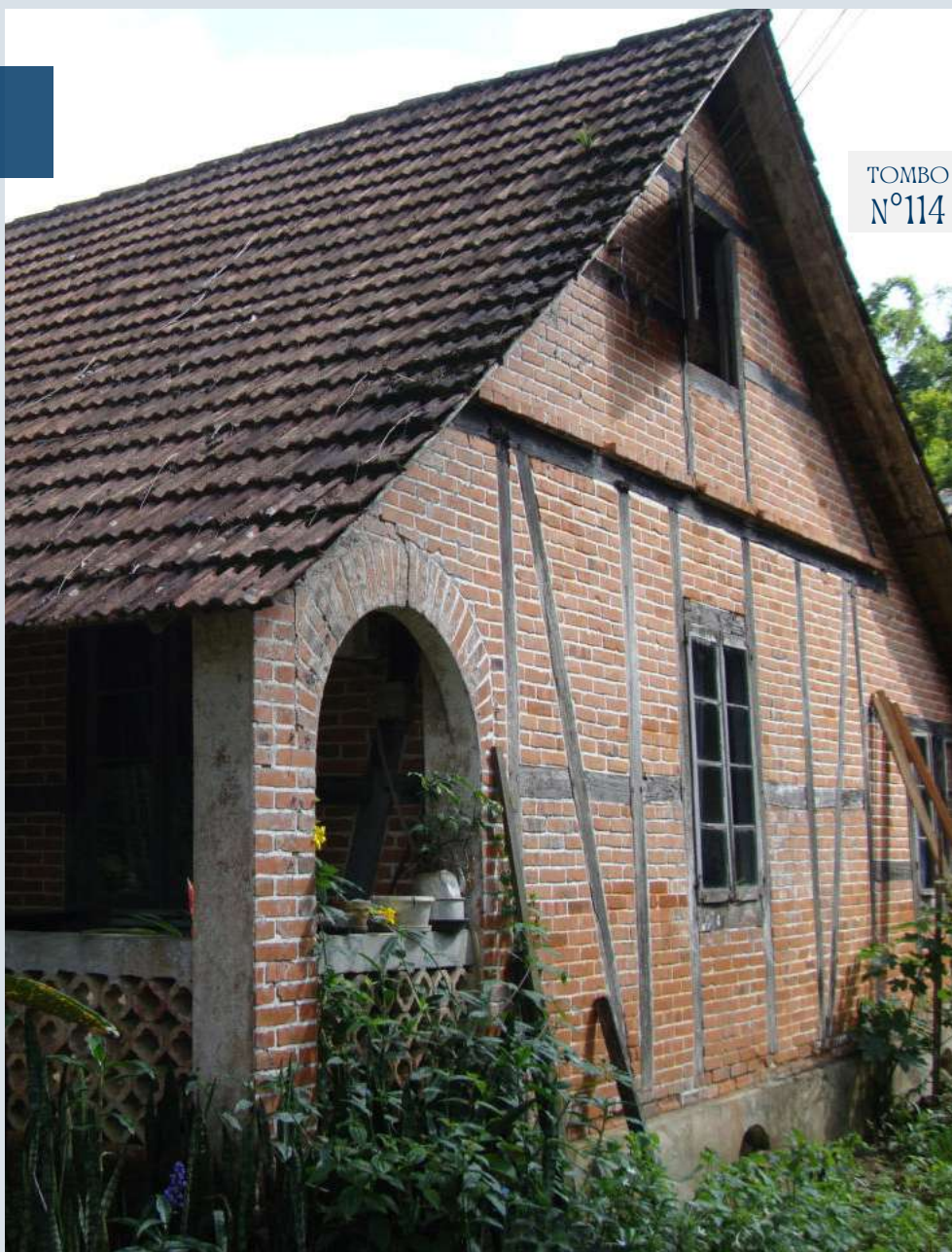
Figura 220: Fotografia da edificação CPC\SECULT, 2024
