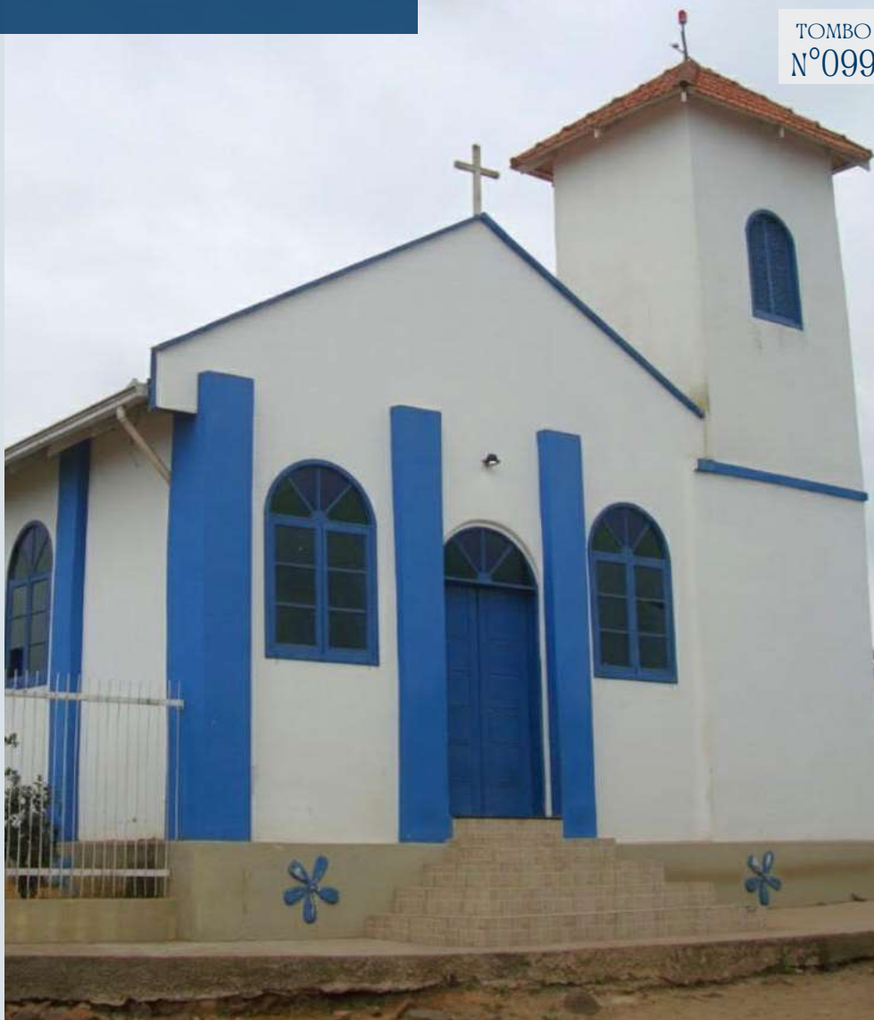
Figura 190: Fotografia da edificação CPC\SECULT, 2023
