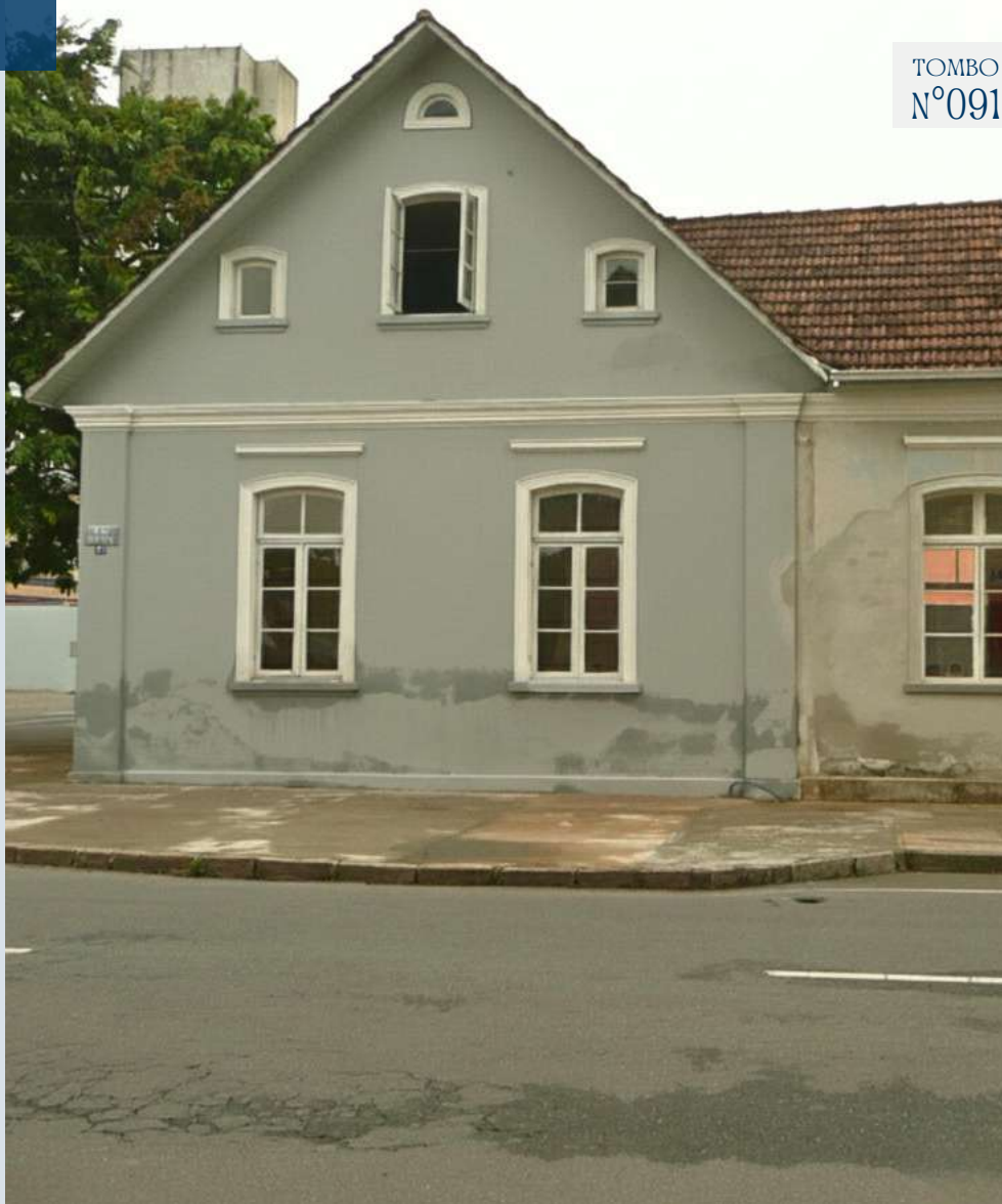
Figura 174: Fotografia da edificação CPC\SECULT, 2024
