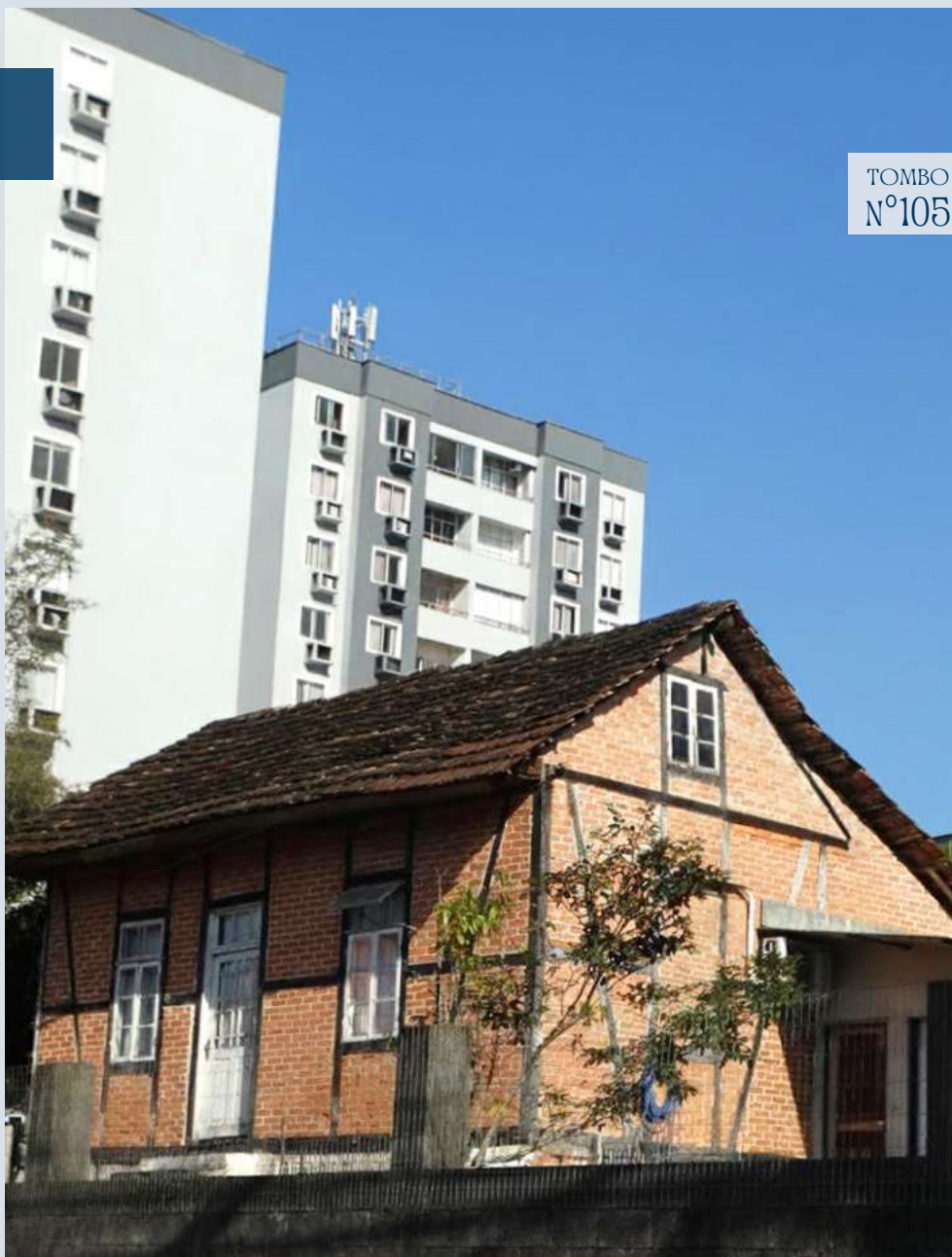
Figura 202: Fotografia da edificação CPC\SECULT, 2024
