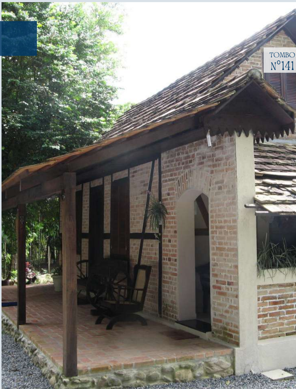
Figura 274: Fotografia da edificação CPC\SECULT, 2023
