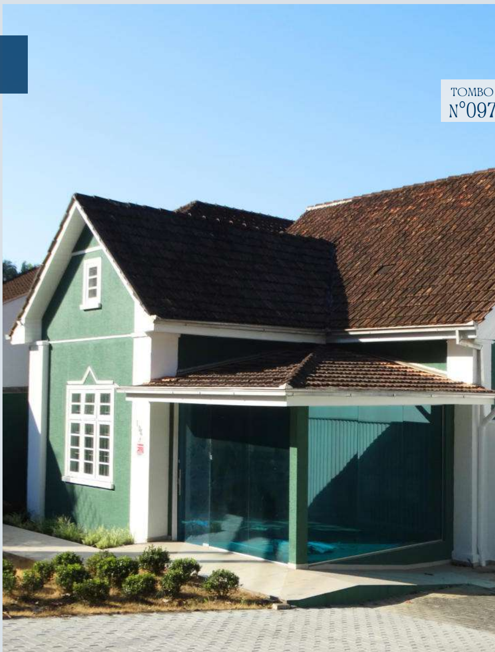
Figura 186: Fotografia da edificação CPC\SECULT, 2024
