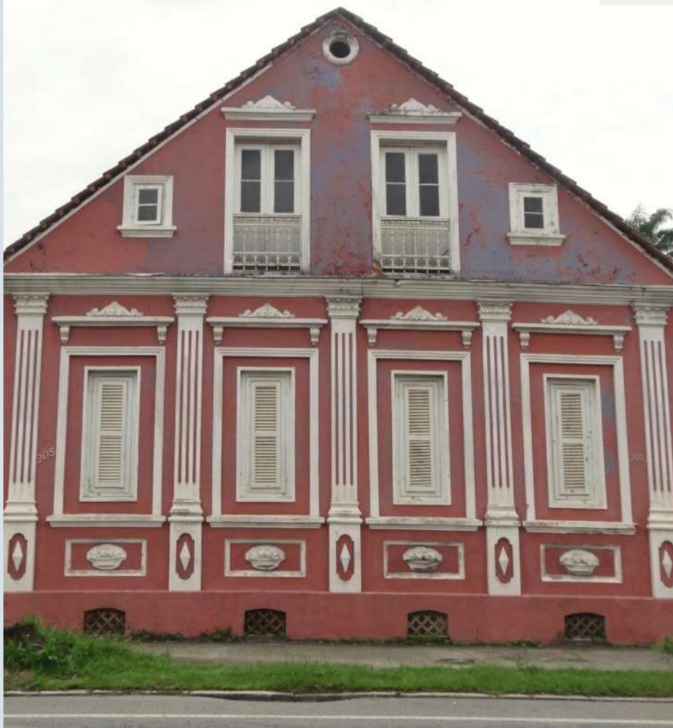
Figura 145: Fotografia da edificação CPC\SECULT, 2024
