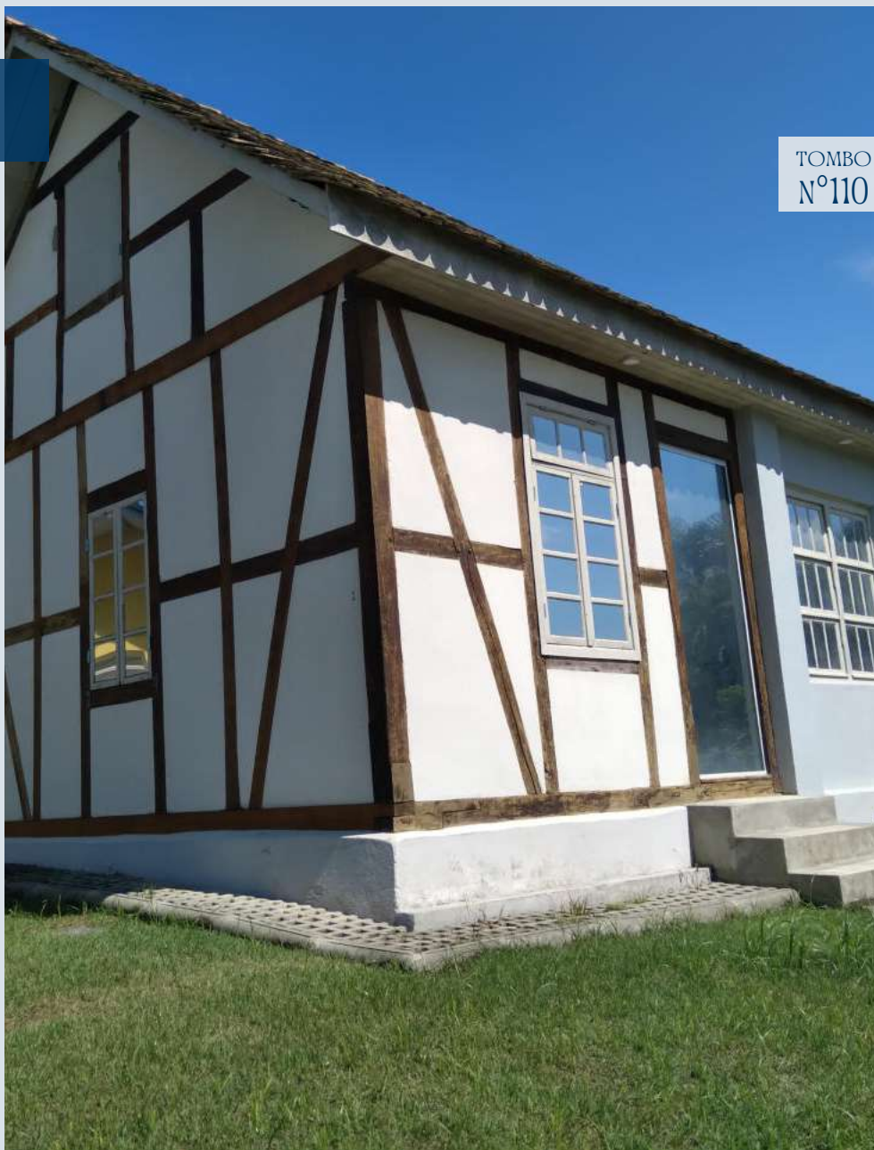
Figura 212: Fotografia da edificação CPC\SECULT, 2024
