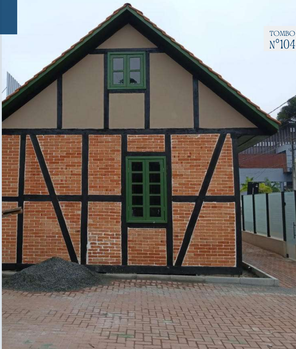
Figura 200: Fotografia da edificação CPC\SECULT, 2024
