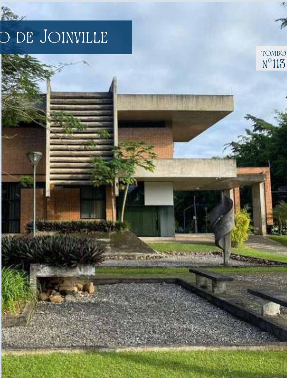
Figura 218: Fotografia da edificação CPC\SECULT, 2025
