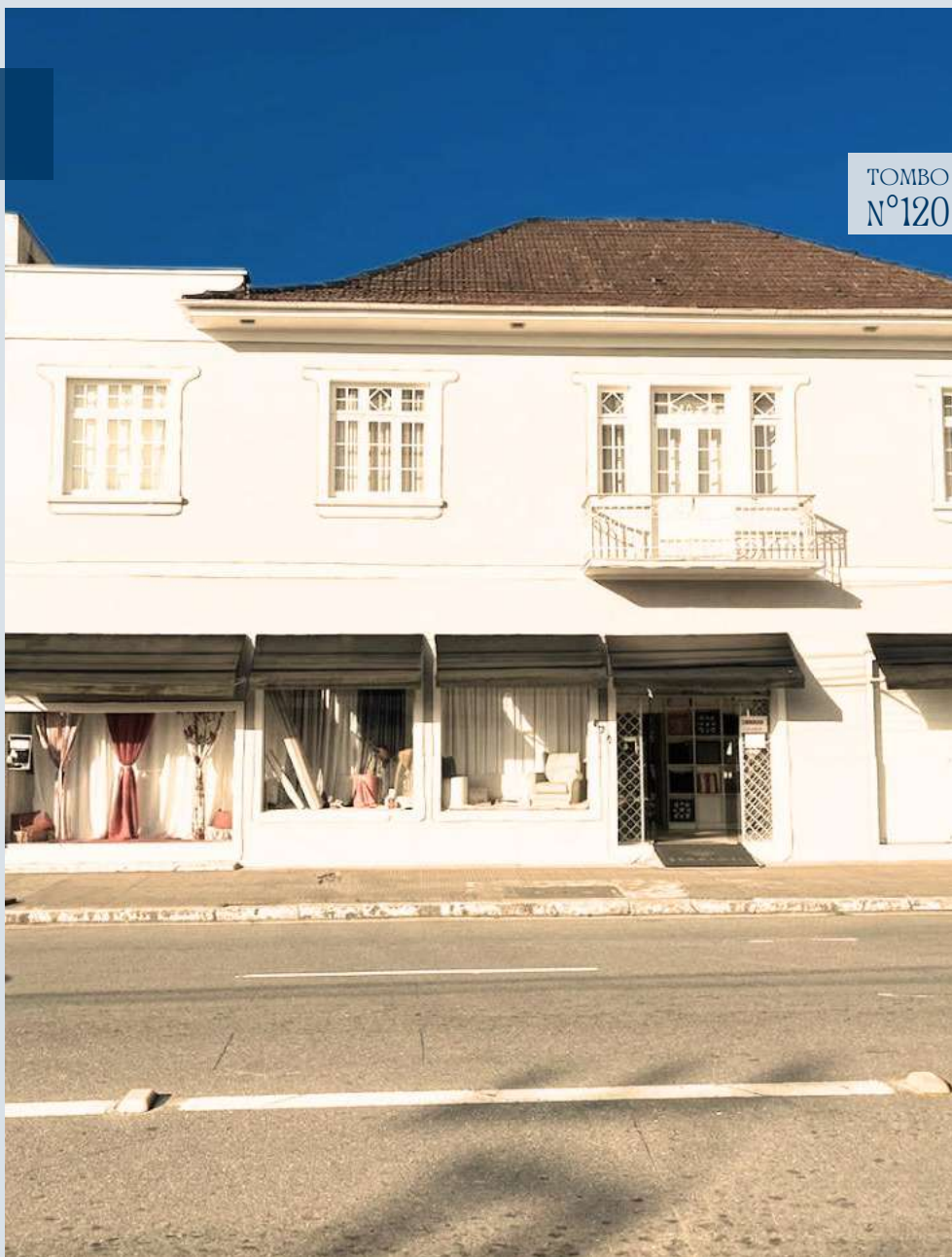
Figura 232: Fotografia da edificação CPC\SECULT, 2024
