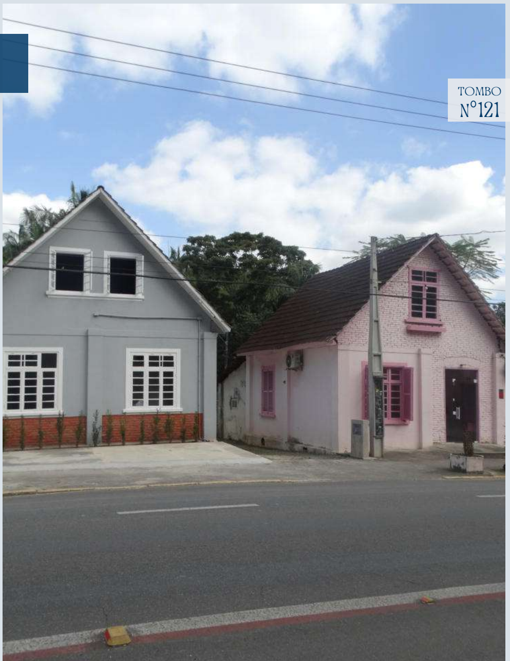
Figura 234: Fotografia da edificação CPC\SECULT, 2023
