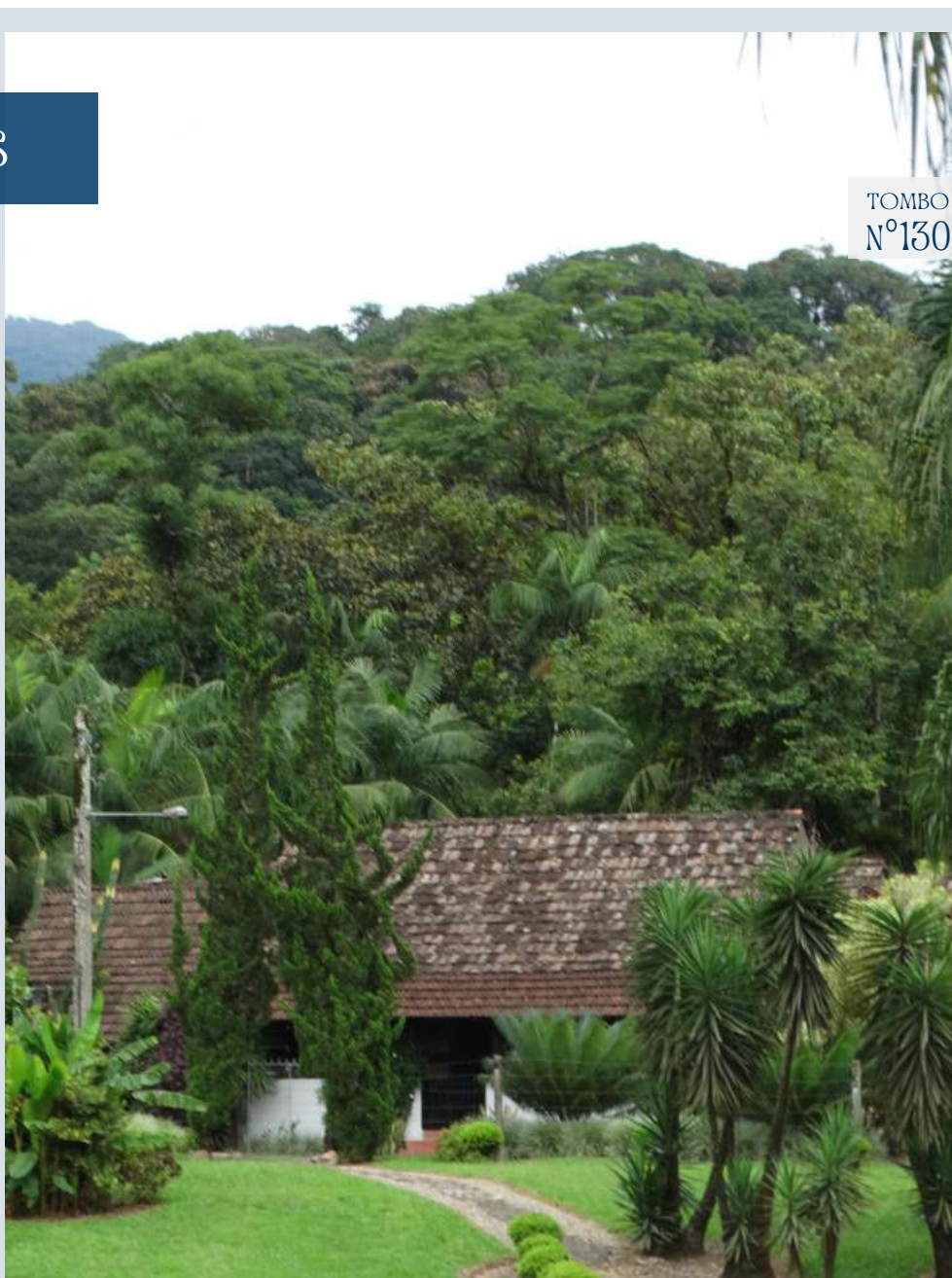
Figura 252: Fotografia da edificação CPC\SECULT, 2023
