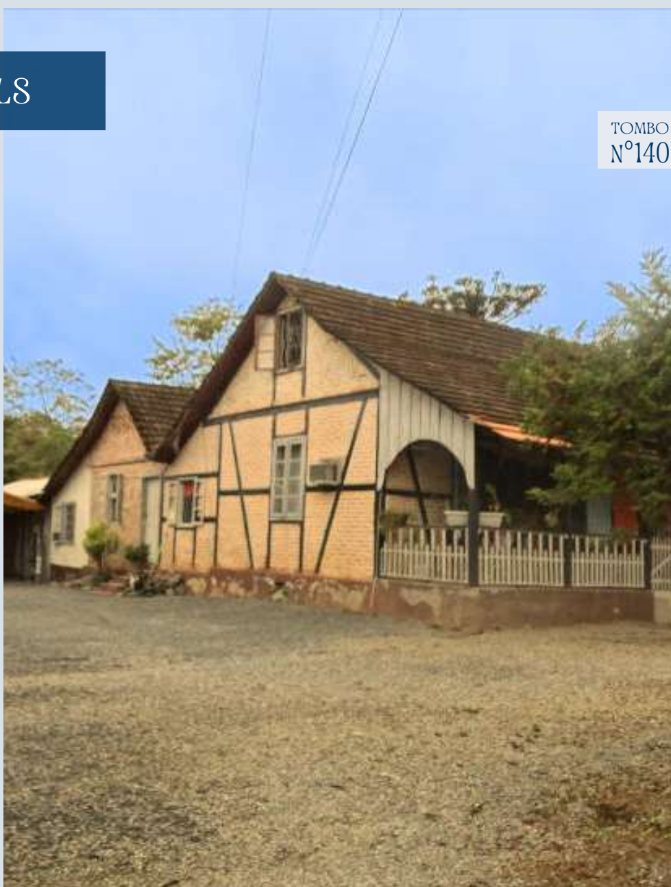
Figura 272: Fotografia da edificação CPC\SECULT, 2024
