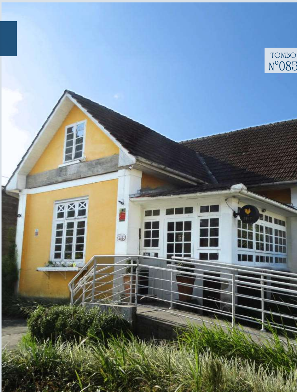
Figura 162: Fotografia da edificação CPC\SECULT, 2024
