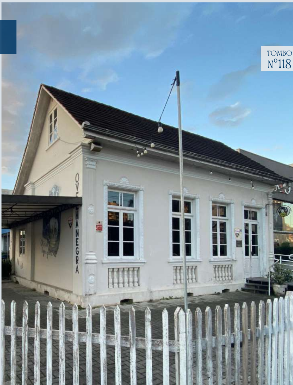
Figura 228: Fotografia da edificação CPC\SECULT, 2024
