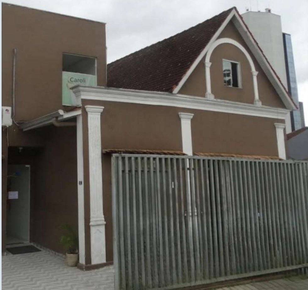
Figura 149: Fotografia da edificação CPC\SECULT, 2024
