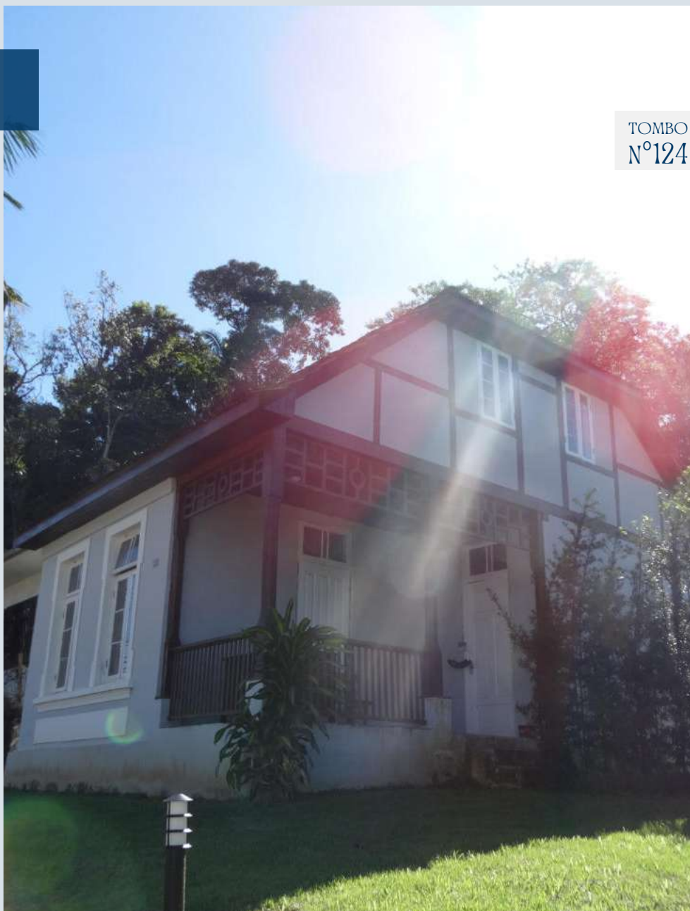
Figura 240: Fotografia da edificação CPC\SECULT, 2024
