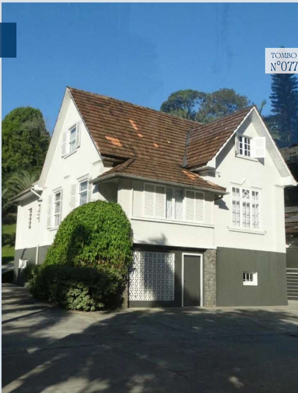
Figura 147: Fotografia da edificação CPC\SECULT, 2024
