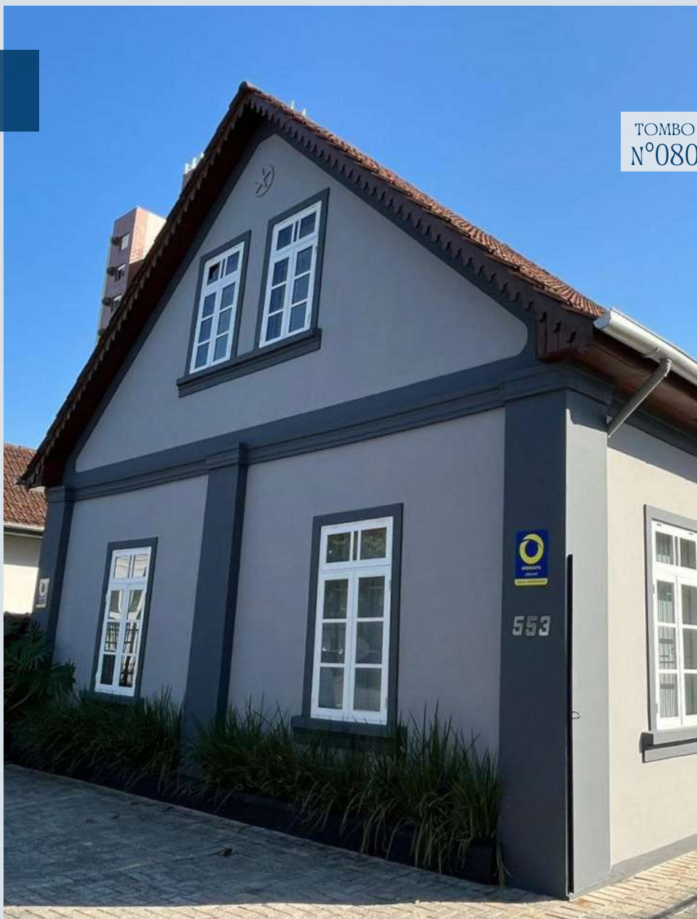
Figura 152: Fotografia da edificação CPC\SECULT, 2024
