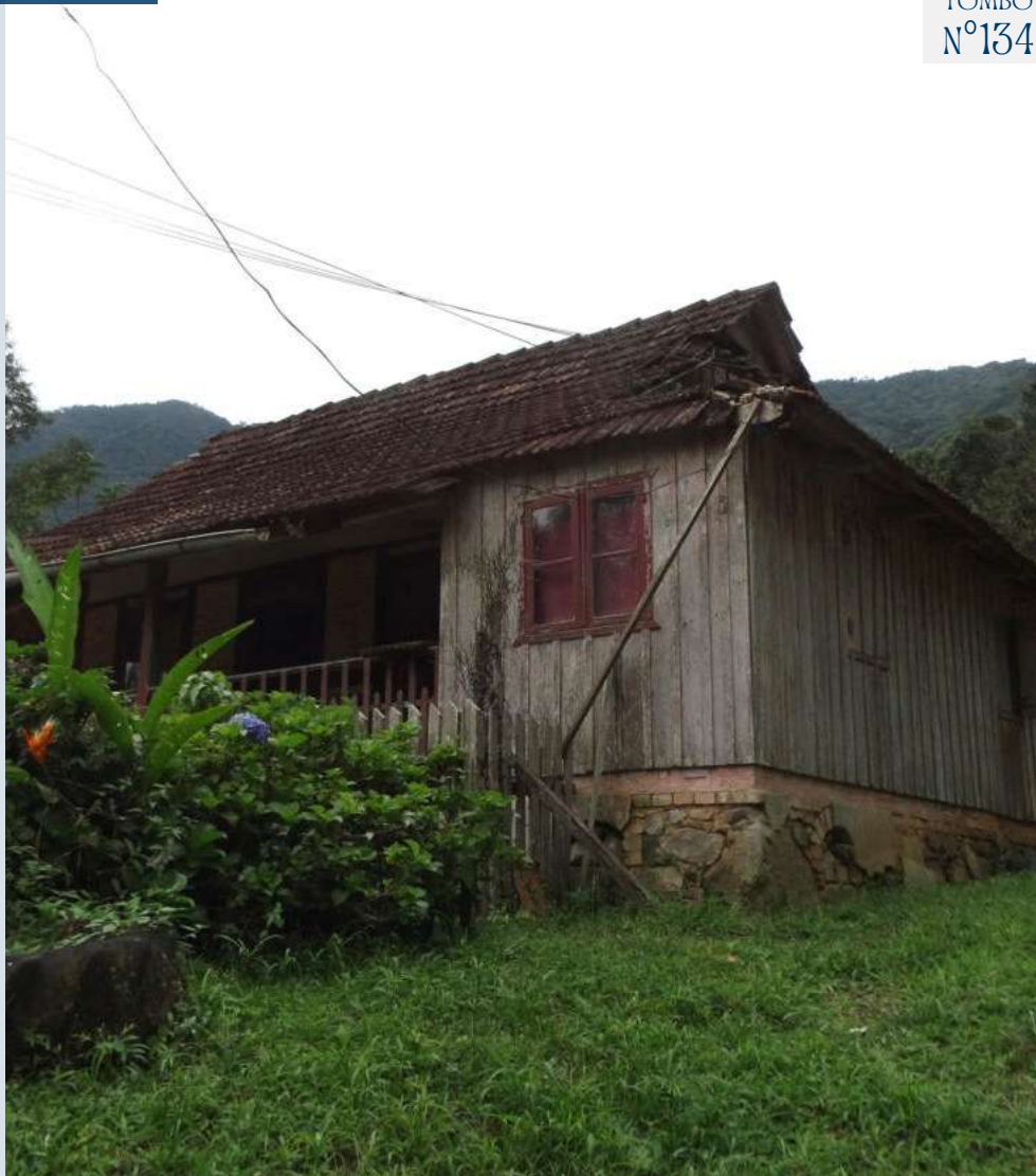
Figura 260: Fotografia da edificação CPC\SECULT, 2024
