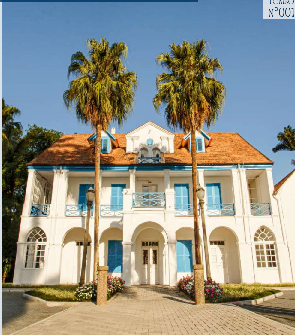
Figura 2: Fotografia da edificação CPC/SECULT, 2024
