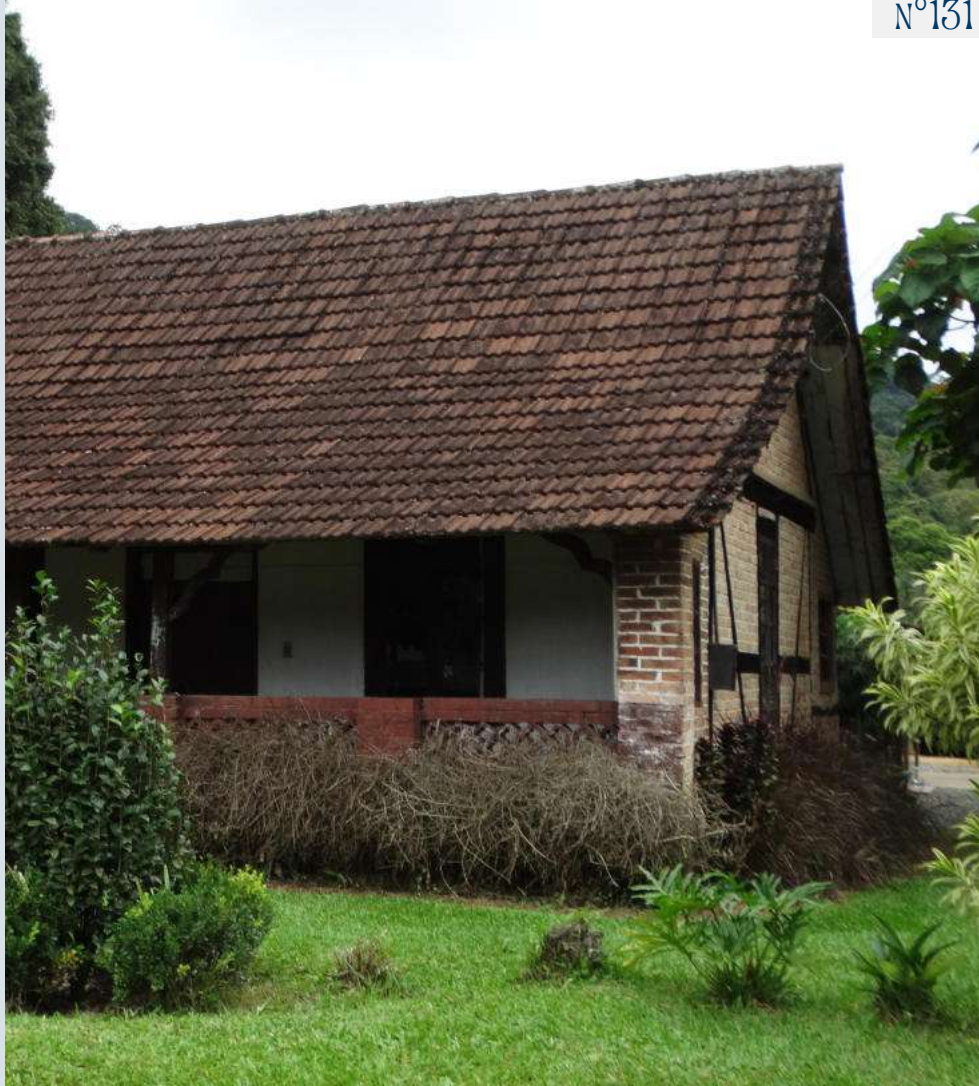
Figura 254: Fotografia da edificação CPC\SECULT, 2023
