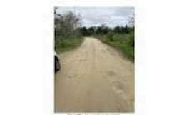
Figura 2 - Rua de terra em área urbana
