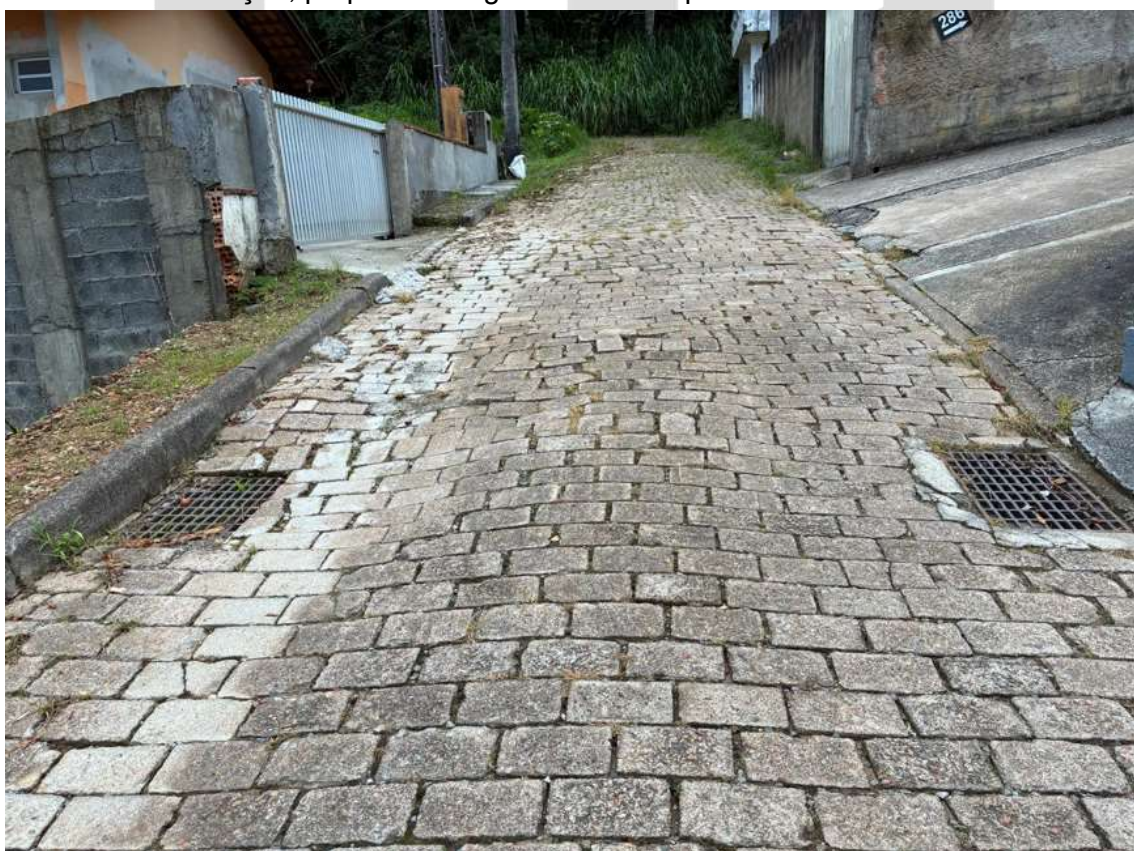
Imagem 16: Final da Rua Otto Eduardo Lepper, a via encontra-se em boas condições de conservação, pequenas irregularidades no pavimento em 22/02/2026
