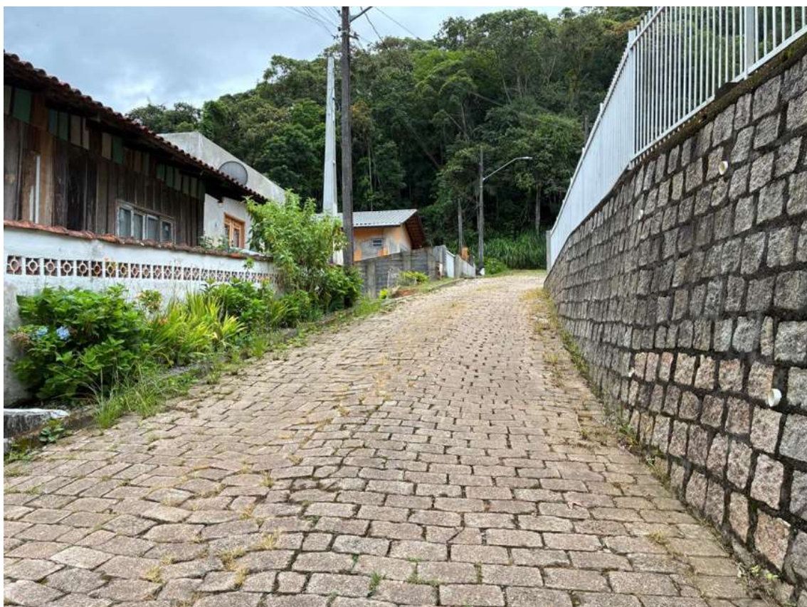
Imagem 15: Rua Otto Eduardo Lepper, a via encontra-se em boas condições de conservação, pequenas irregularidades no pavimento em 22/02/2026
