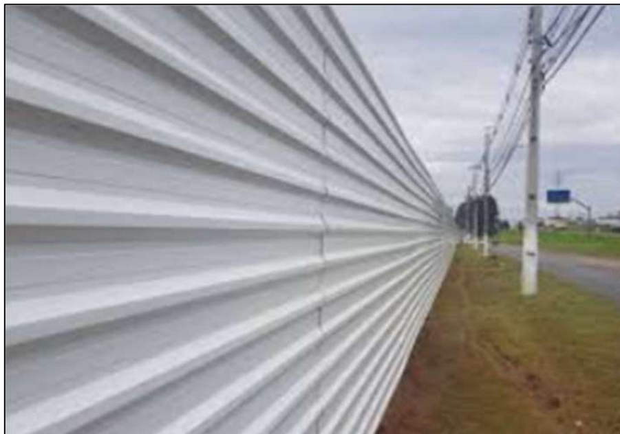
Figura 9: Imagem ilustrativa do cercamento metálico da obra.
