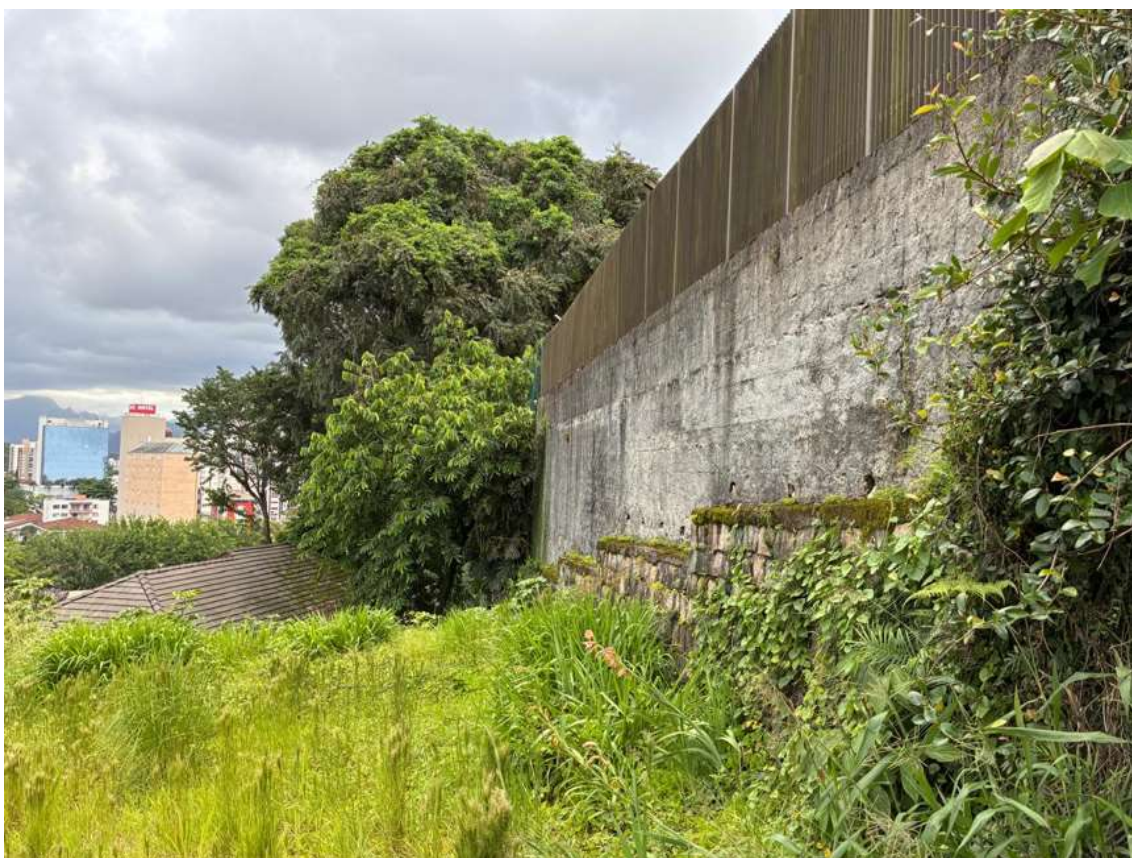
Imagem 19: Muro divisa lado direito em boas condições em 22/02/2026.
