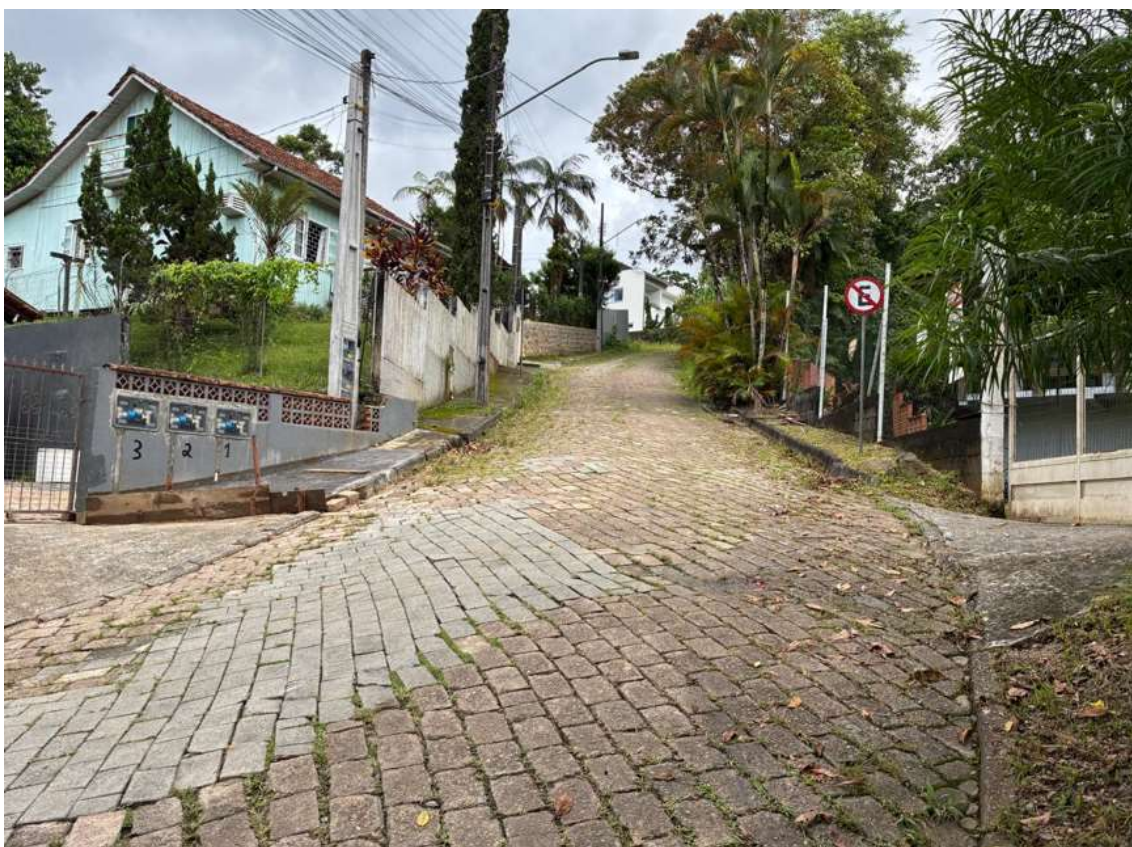
Imagem 9: Rua Otto Eduardo Lepper, a via encontra-se em boas condições de conservação em 22/02/2026.
