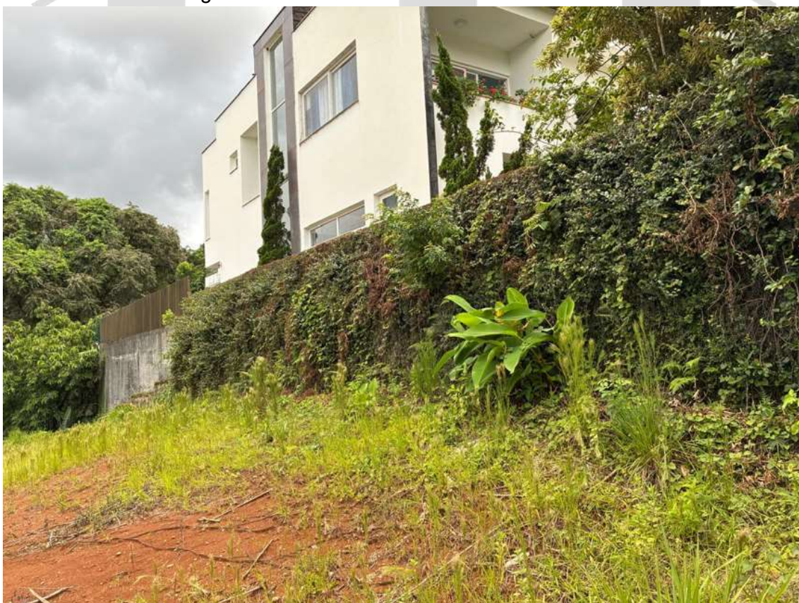
Imagem 18: Muro divisa lado direito em boas condições em 22/02/2026.
