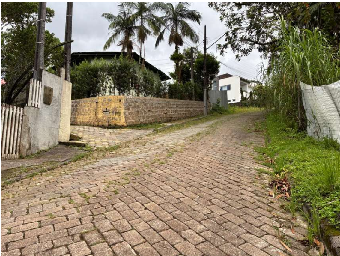
Imagem 11: Rua Otto Eduardo Lepper, a via encontra-se em boas condições de conservação, calçada inexistente em alguns trechos em 22/02/2026.
