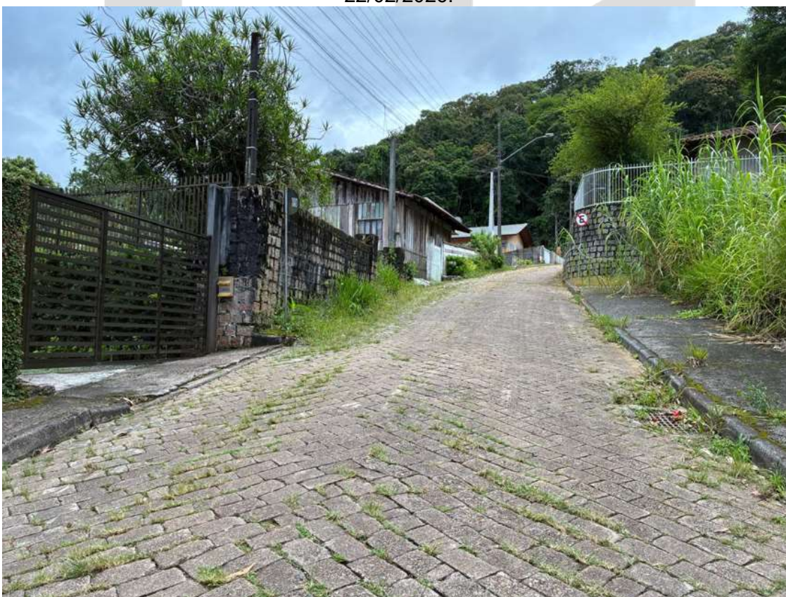
Imagem 14: Rua Otto Eduardo Lepper, a via encontra-se em boas condições de conservação em 22/02/2026.
