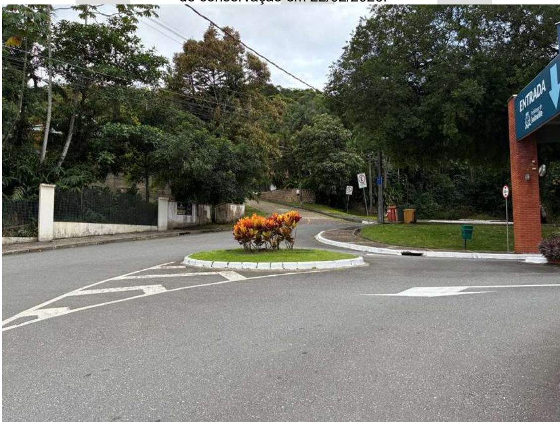
Imagem 4: Interseção entre as Ruas Otto Eduardo Lepper e Leopoldo Lepper, encontra-se em boas condições de conservação em 22/02/2026.
