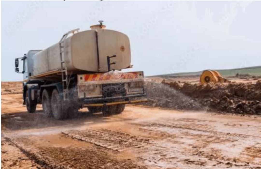
Figura 10: Imagem ilustrativa de umectação por caminhão pipa.
