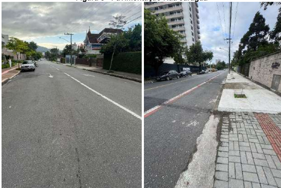
Figura 8 - Pavimentação Rua Jaraguá
