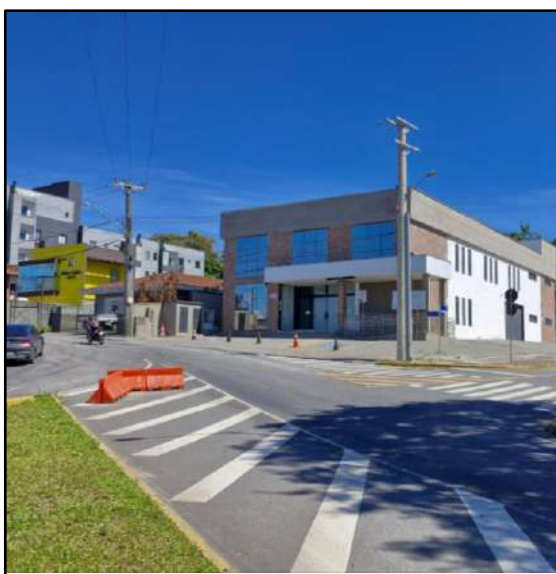
Figura 36: Faixa zebra no encontro da Rua Ottokar Doerffel com a Rua Marajó. Fonte: Arquivo pessoal, 2026.
