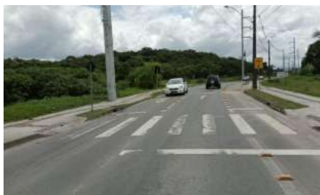
Figura 191 – Rua Elza de Oliveira – ETE à direita (Ponto 18A)
