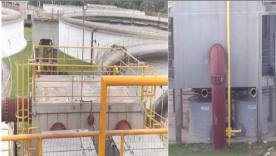
Figura 8 – Caixa de Reunião de Efluente dos PTRATs
