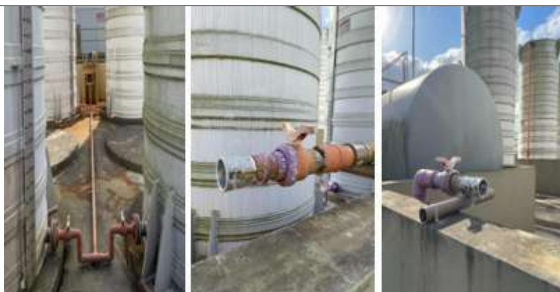
Figura 31 – Tanques de armazenamento de produtos químicos. À esquerda, detalhe da tubulação comunicante entre os tanques de \text{FeCl}_3 . Ao centro e à direita, detalhe dos engates rápidos para a alimentação dos tanques de \text{FeCl}_3 e \text{NaOH} , respectivamente.
