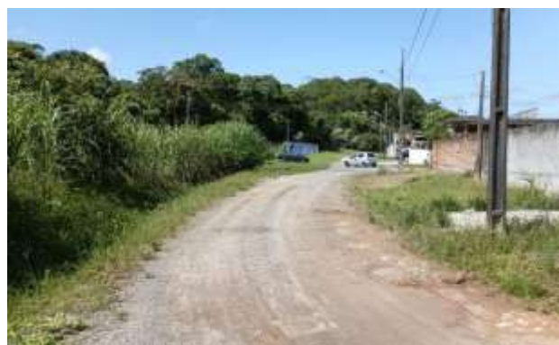
Figura 140 – Rua Dóris Dobner Nass – ETE à Frente (Ponto 6B)
