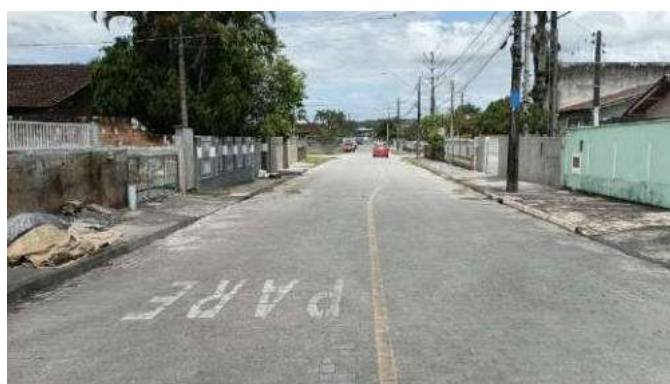
Figura 93 – Rua Gerhard Fischer – ETE Atrás (Ponto 22C)
