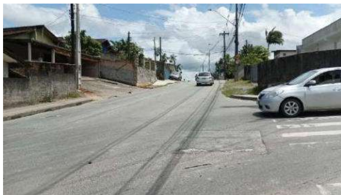
Figura 88 – Rua Rio Velho – ETE Atrás (Ponto 21C)
