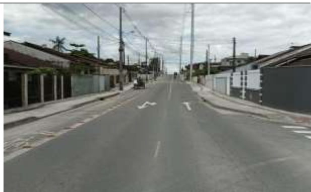
Figura 79 – Rua Elza de Oliveira próximo a Rua Renato Caetano da Silva Filho (Ponto 18B do Anexo II)
