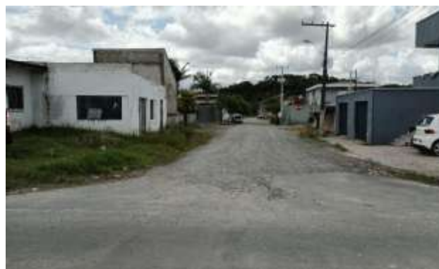
Figura 160 – Rua Cidade de Ourinho – ETE à Frente (Ponto 11B)
