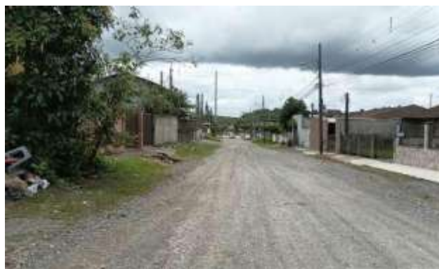
Figura 183 – Rua Dep. Aderbal Tavares Lopes – ETE à direita (Ponto 16A)
