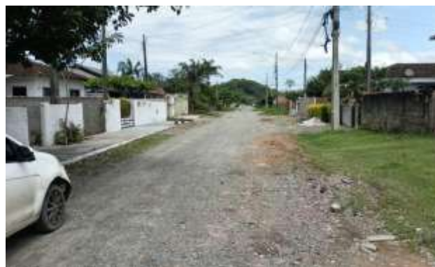
Figura 216 – Rua Hildebrando Soares – ETE Atrás (Ponto 24B)
