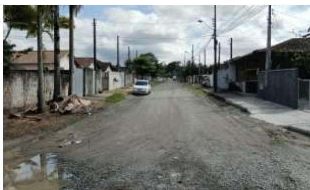
Figura 120 – Rua Dep. Aderbal Tavares Lopes – ETE à direita (Ponto 1C)
