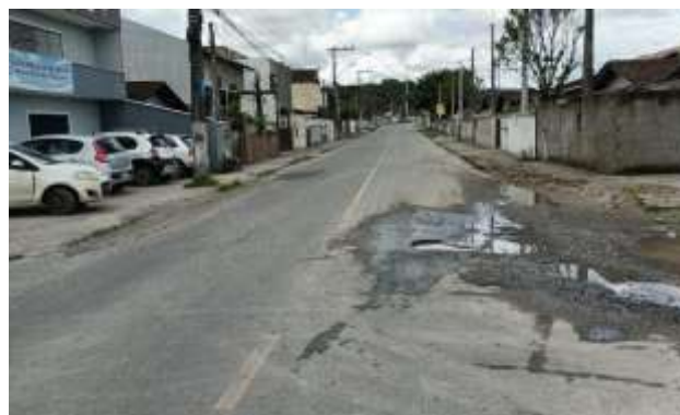
Figura 162 – Rua Max Pruner – ETE à esquerda (Ponto 11D)
