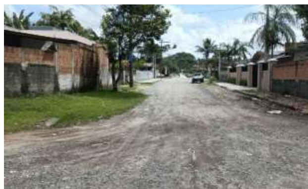
Figura 218 – Rua Gilda Meir – ETE à direita (Ponto 24D)
