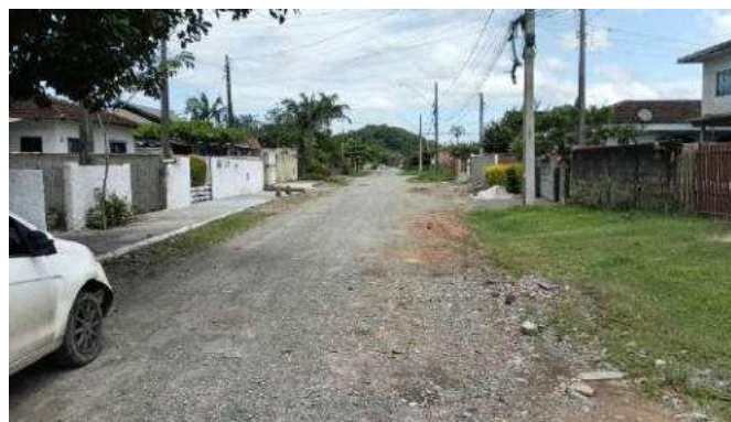
Figura 101 – Rua Hildebrando Soares – ETE Atrás (Ponto 24B)
