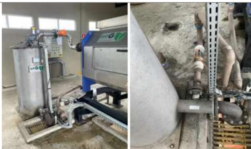
Figura 36 – Tanque de mistura de lodo e polímero preparado no piso superior da ETL, ao lado das Prensas Parafuso. Detalhe das tubulações de lodo e de polímero (PVC) que alimentam o tanque de mistura, e da tubulação de saída do tanque, para alimentação das prensas.
