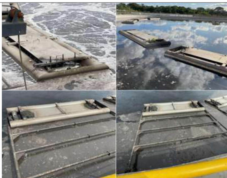
Figura 18 – Vertedores flutuantes para coleta do efluente clarificado dos reatores. A primeira foto à esquerda, detalhe de um vertedor flutuante estando o reator no período de aeração. Em cima, na direita, detalhe da disposição dos 5 vertedores durante o período de parada da aeração.
