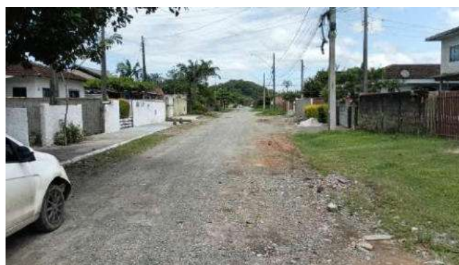
Figura 101 – Rua Hildebrando Soares – ETE Atrás (Ponto 24B)
