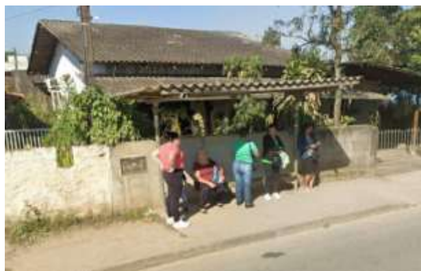
Figura 80 – Abrigo do Ponto de Ônibus na Rua Max Pruner, 1210
