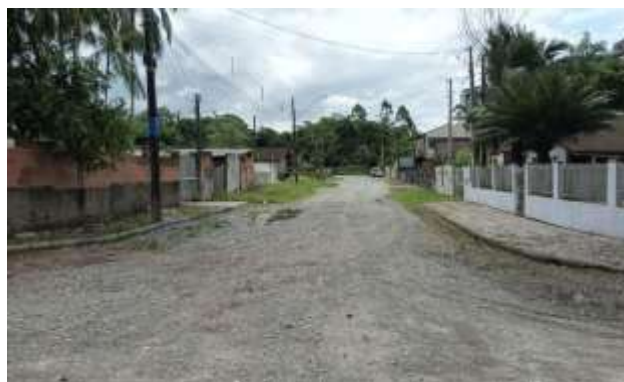
Figura 215 – Rua Hildebrando Soares – ETE à Frente (Ponto 24A)
