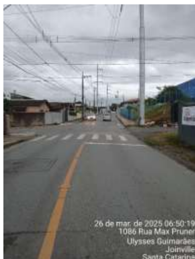
Figura 66 – Sinalização Horizontal (faixa de pedestre e faixa contínua e amarela) na Rua Max Pruner (Sentido DC)
