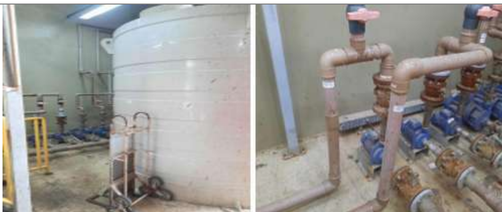
Figura 33 – ETL, piso inferior. À esquerda, reservatório de água. À direita, bombas para lavagem das prensas
