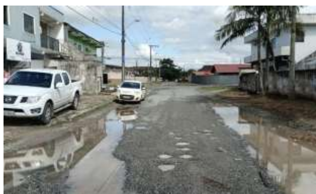
Figura 118 – Rua Cidade de Guarulhos – ETE Atrás (Ponto 1A)
