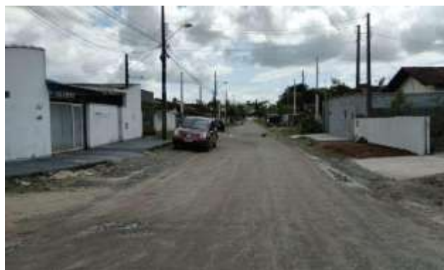
Figura 156 – Rua Alfredo Stringari – ETE à direita (Ponto 10C)
