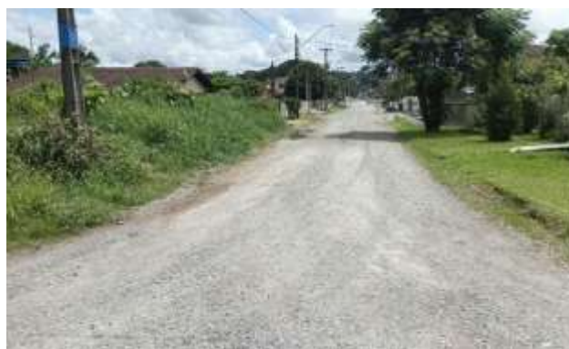
Figura 222 – Rua Min. Marcos Freire – ETE à direita (Ponto 25C)
