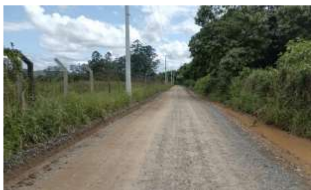
Figura 234 – Rua Rio Velho – ETE à direita (Ponto 29A)
