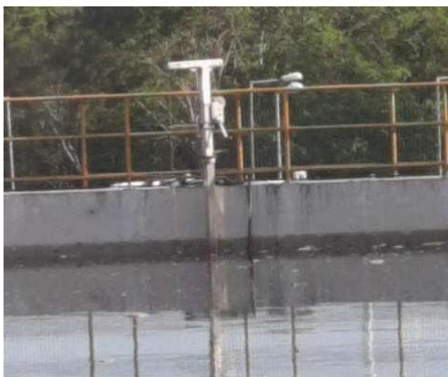
Figura 17 – Guia de recolhimento de um dos misturadores de parede do reator B. O outro misturador fica exatamente no local de onde foi tirada a foto.
