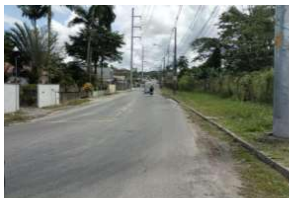
Figura 56 – Rua Rio Velho (ETE Jarivatuba à direita)
