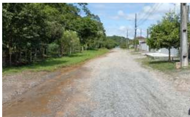
Figura 142 – Rua Dóris Dobner Nass – ETE à esquerda (Ponto 7A)
