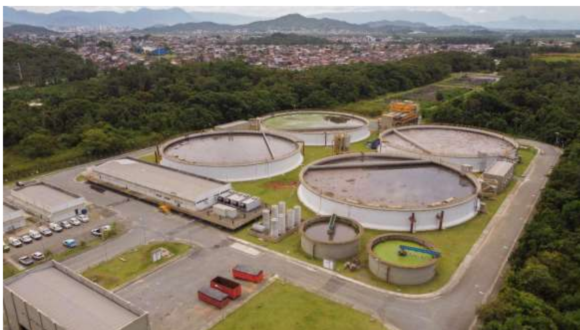
Figura 3 – Vista aérea da ETE Jarivatuba em operação
