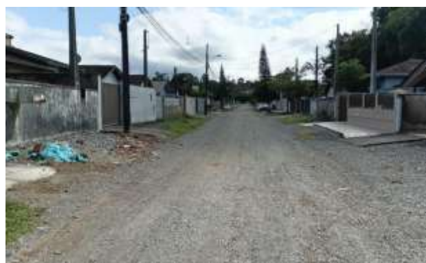
Figura 124 – Rua Alfredo Stringari – ETE à direita (Ponto 2B)
