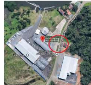
Figura 4 - Ponto 2: Estrada Cubatão Grande nº 1897.
