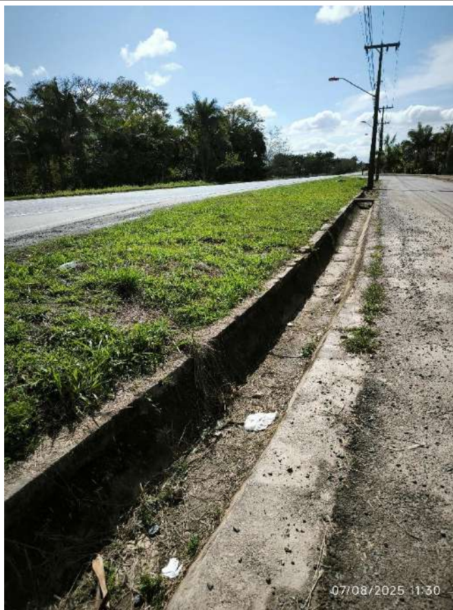
Figura 13: Captação de Drenagem Pluvial, em frente ao local de estudo, vista sentido pista Norte.
