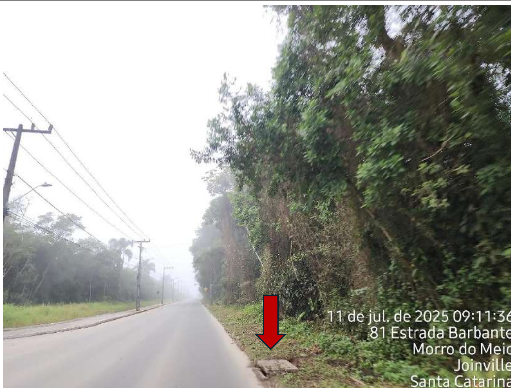
Figura 17: Boca de lobo existente, Estrada Barbante.
