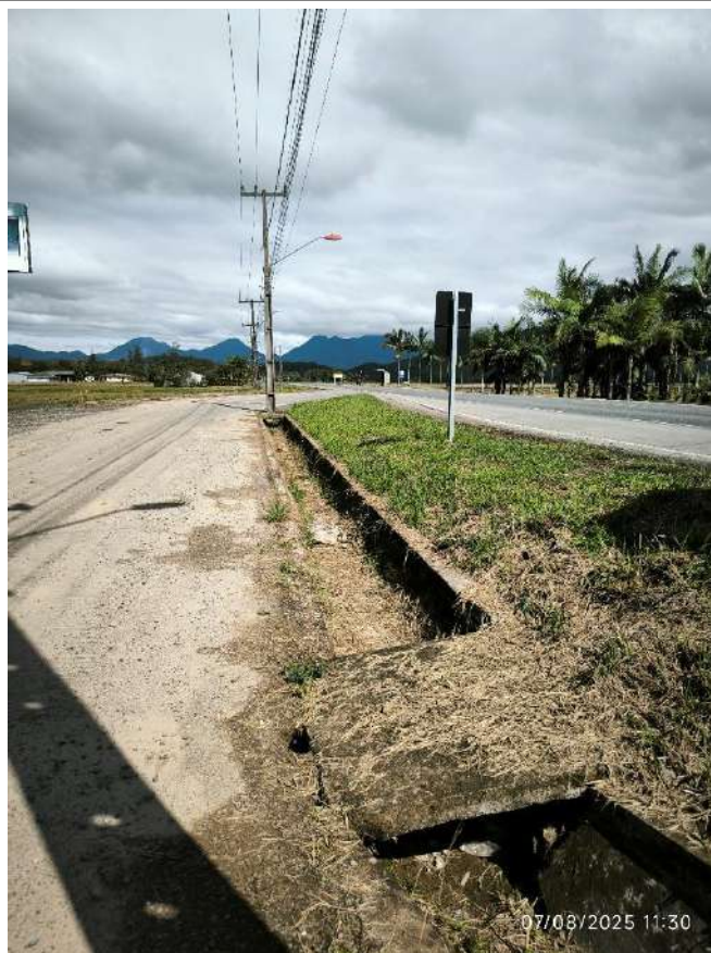
Figura 14: Captação de Drenagem Pluvial, em frente ao local de estudo, vista sentido Pista Sul.
