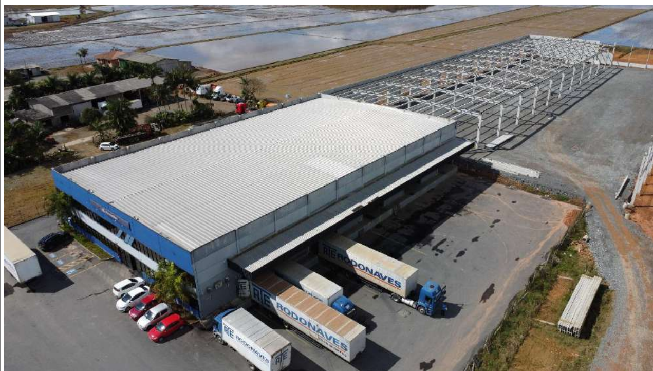
Figura 78: Imagem aérea do empreendimento existente no imóvel.
