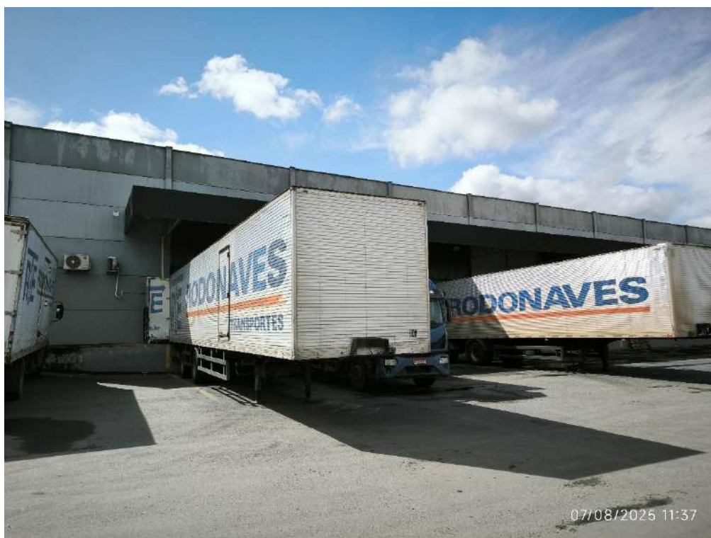
Figura 28: Área de carga e descarga
