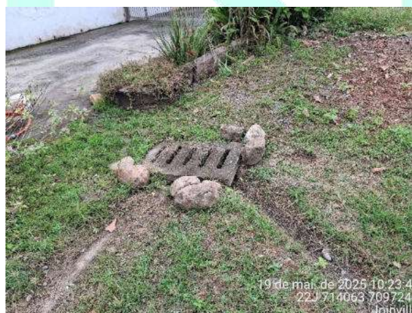
Figura 14 - Boca de lobo com grelha concreto na Estrada da Ilha (sentido Centro).
