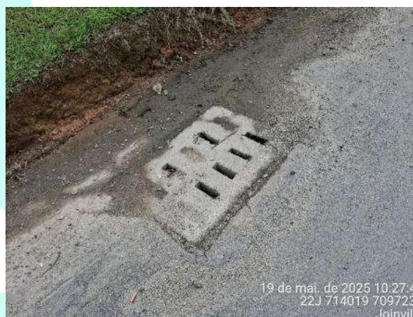
Figura 15 - Boca de lobo com grelha concreto na Estrada da Ilha (sentido Centro).
