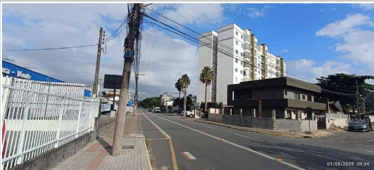
Figura 23: Aspecto das calçadas, Rua Carlos Benack.
