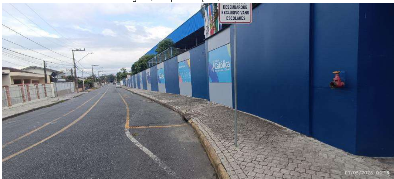
Figura 58: Aspecto calçada, Rua Guaramirim.
