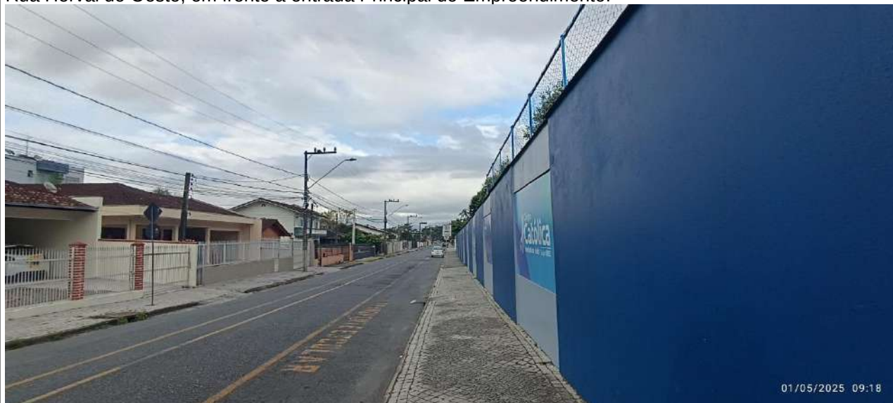
Rua Guaramirim, sentido Rua Dona Francisca.
