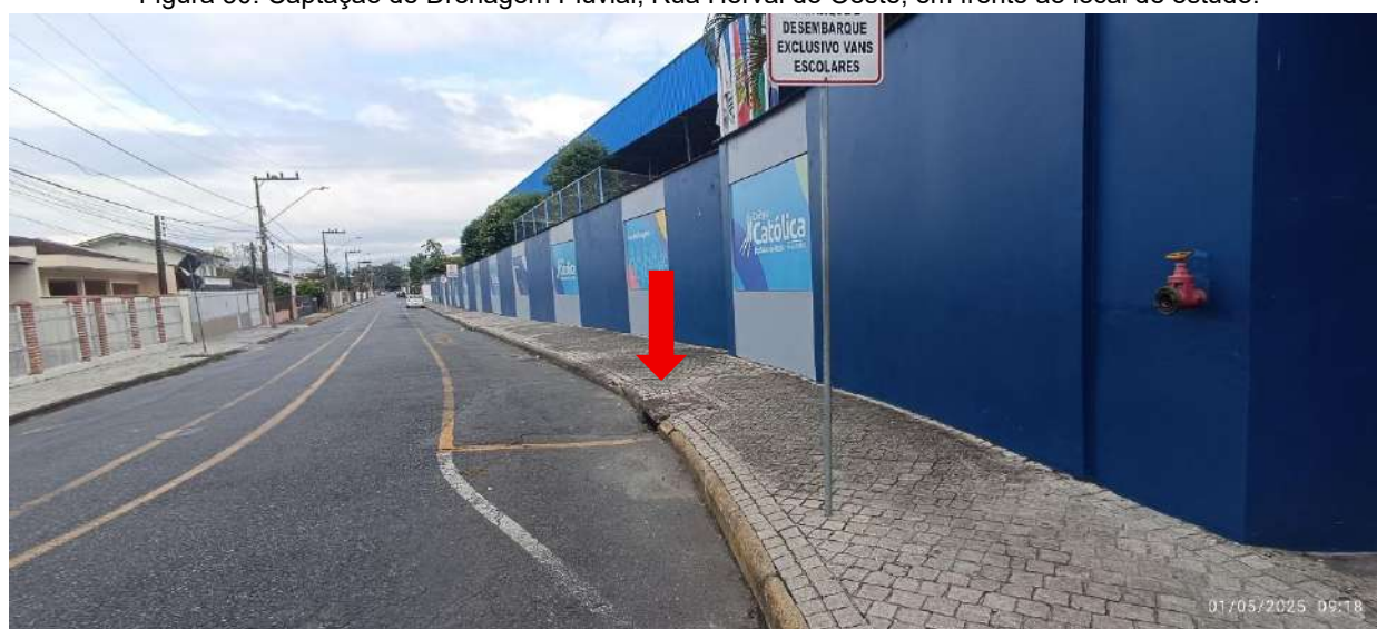
Figura 31: Captação de Drenagem Pluvial, Rua Guaramirim.
