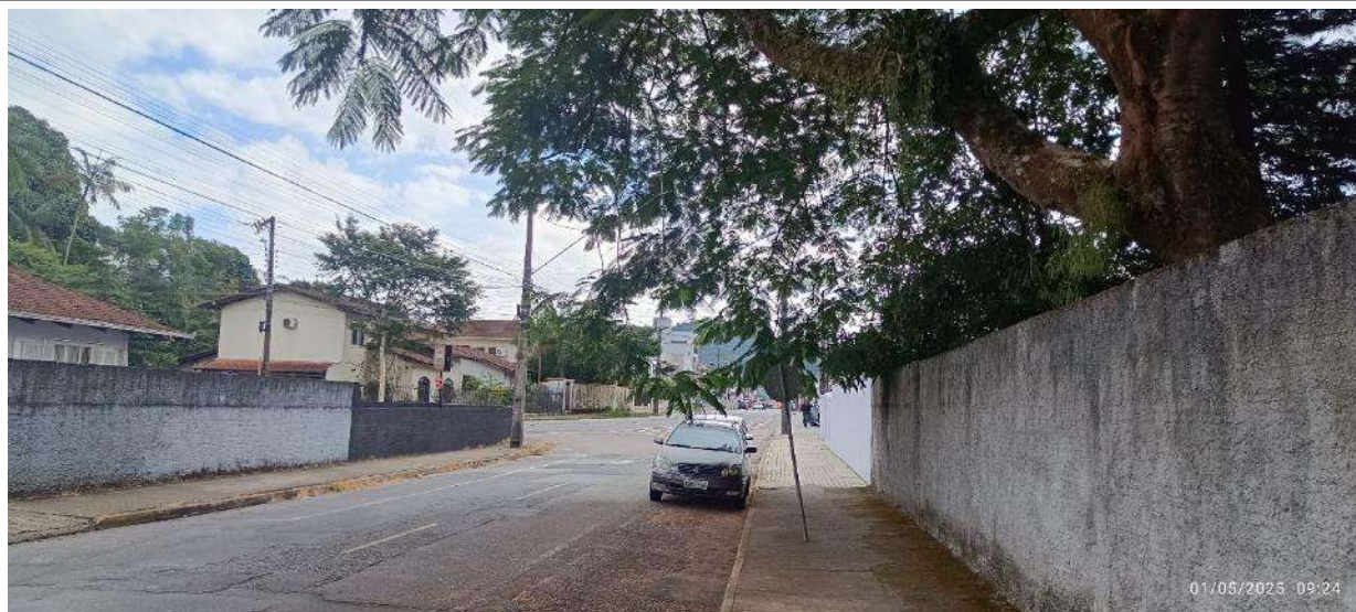
Figura 63: Aspecto calçada, Rua Herval do Oeste.
