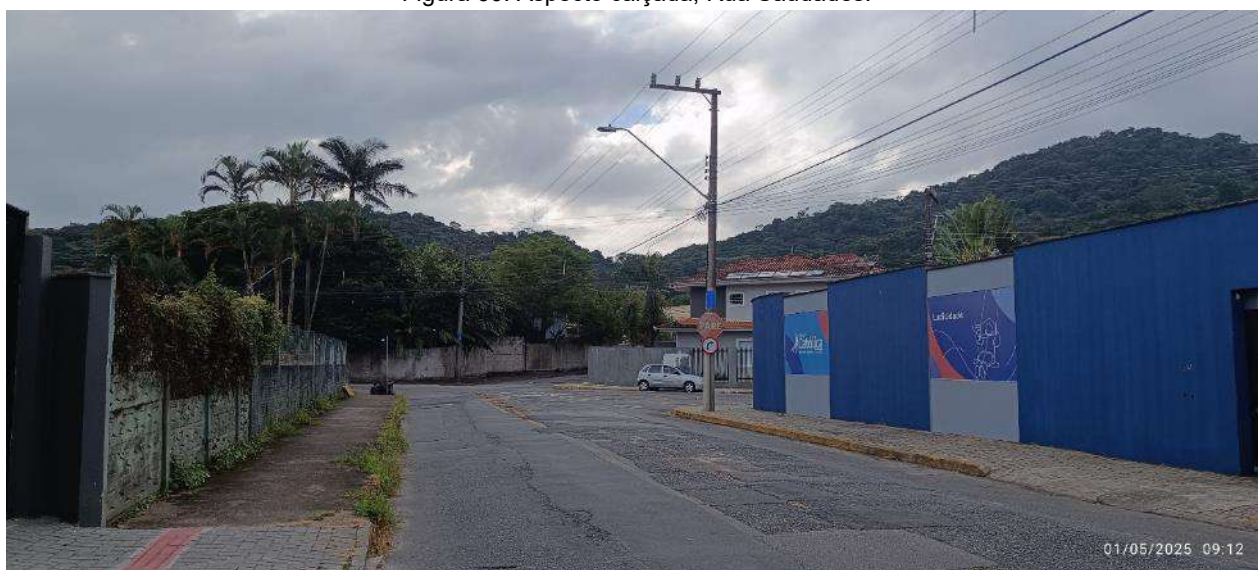
Figura 61: Aspecto calçada, Rua Saudades.
