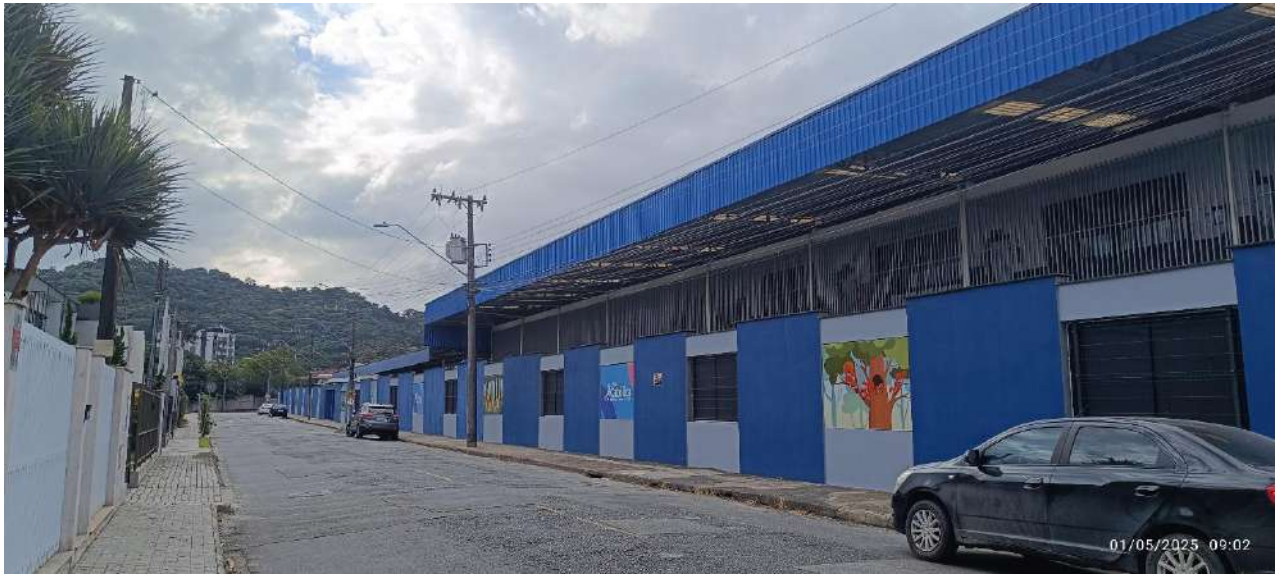
Pontos de Iluminação, Rua Saudades.
