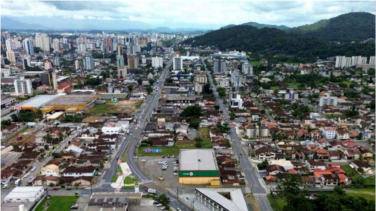
Figura 17. Via arterial - Binário Avenida Coronel Procópio Gomes e Rua Urussanga
