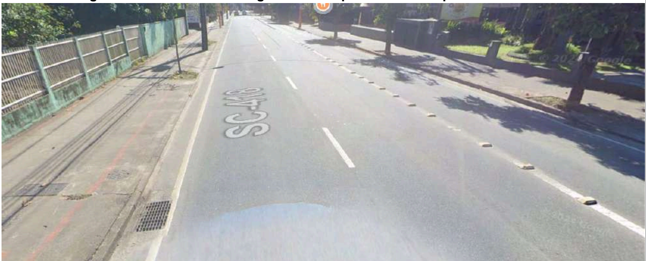
Figura 13. Sistema de drenagem em vias públicas - exemplo Rua São Paulo.
