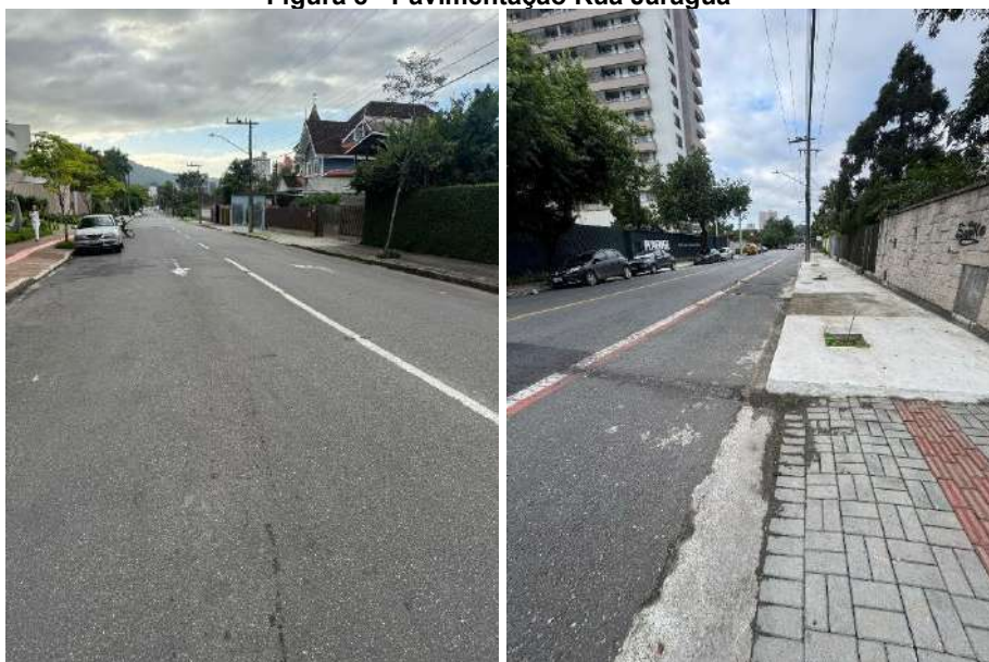
Figura 8 - Pavimentação Rua Jaraguá
