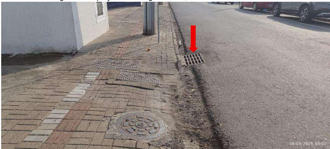
Figura 26: Captação de Drenagem Pluvial, Travessa São José.
