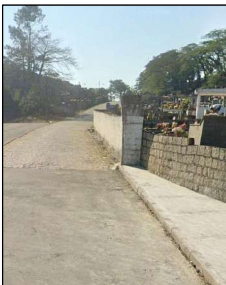
Figura 19: Sarjeta na Rua Iguapé. Fonte: Arquivo pessoal, 2025.
