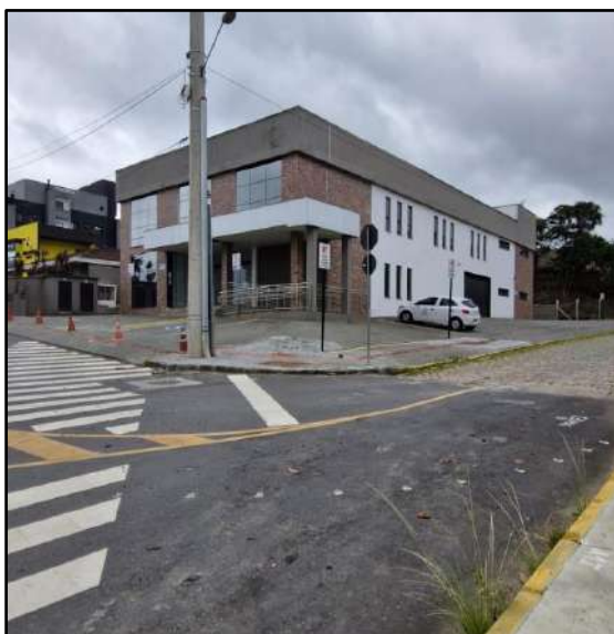
Figura 54: Fachada do empreendimento. Fonte: Arquivo pessoal, 2025.
