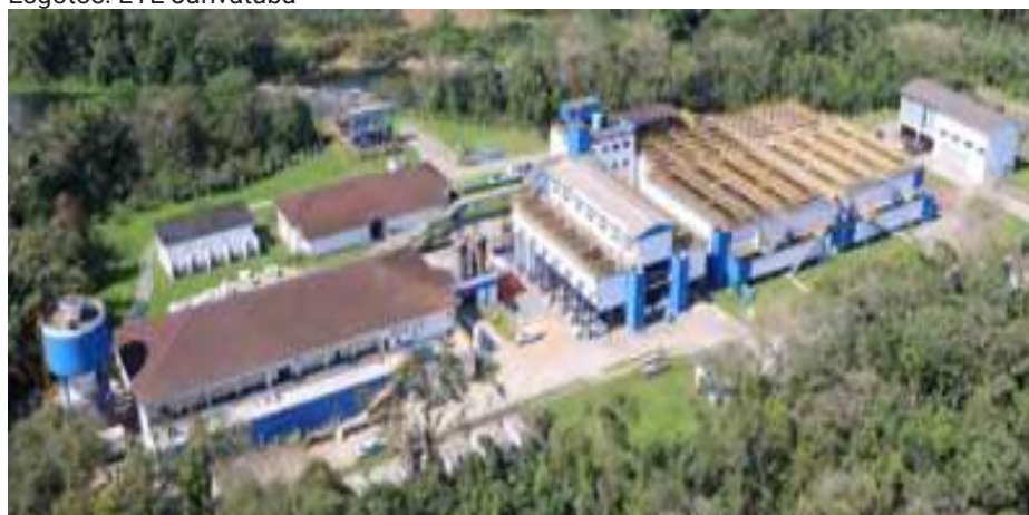
Figuras 20- Estação de Tratamento de Água: ETA Cubatão e Figura 22 - Estação de Esgotos: ETE Jarivatuba
