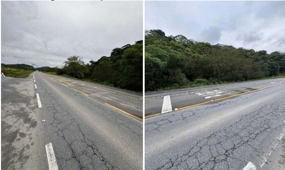
Figura 16 - Sinalização horizontal e vertical da Rodovia Rodolfo Jahn
