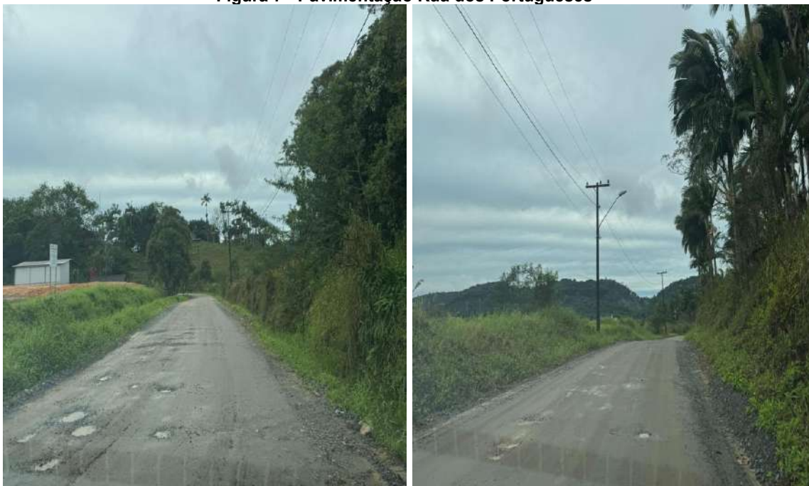
Figura 7 - Pavimentação Rua dos Portugueses
