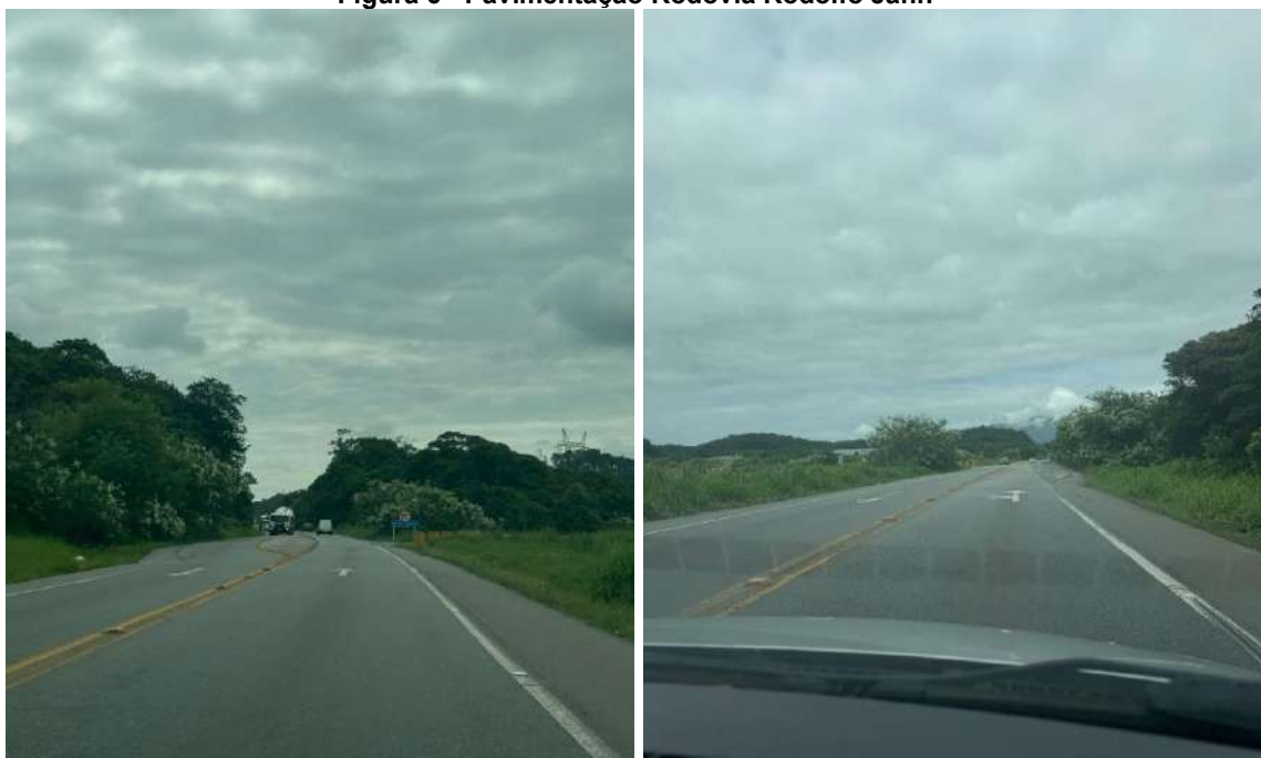
Figura 6 - Pavimentação Rodovia Rodolfo Jahn
