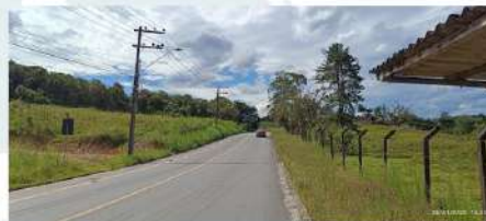
Iluminação Pública, vista sentido Bairro Santa Catarina.
