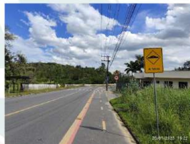
Sinalização vertical e horizontal na rua Santa Catarina, sentido sul.
