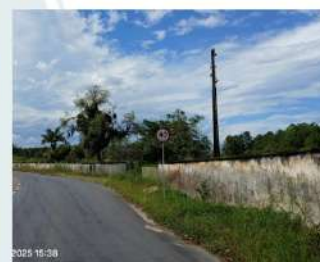
Aspecto calçada, sentido Bairro Santa Catarina.
