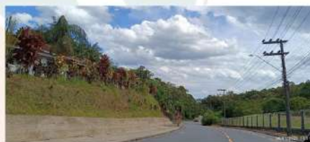
Iluminação Pública, vista para sentido Eixo Sul.
