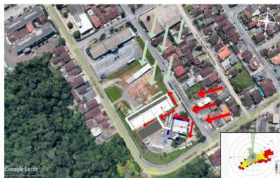
Com a ampliação do empreendimento
